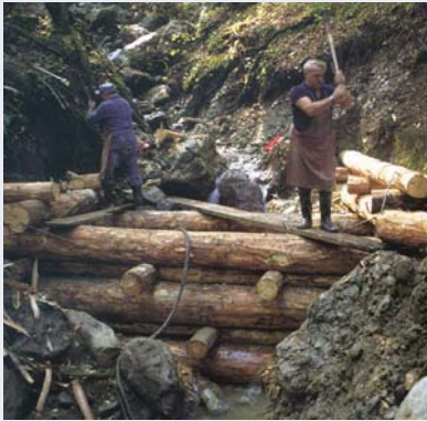
An engen Schluchten oder von Auswaschung bedrohten Bächen werden querliegende Holzstämme als Schutzverbauung eingesetzt. © Bayerisches Staatsministerium für Umwelt und Gesundheit
