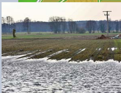
Rückhalteräume: Künstlich angelegte oder natürliche Becken oder Ebenen, die im Hochwasserfall geflutet werden und so einen Teil des Wassers aufnehmen. © Harald Frater
