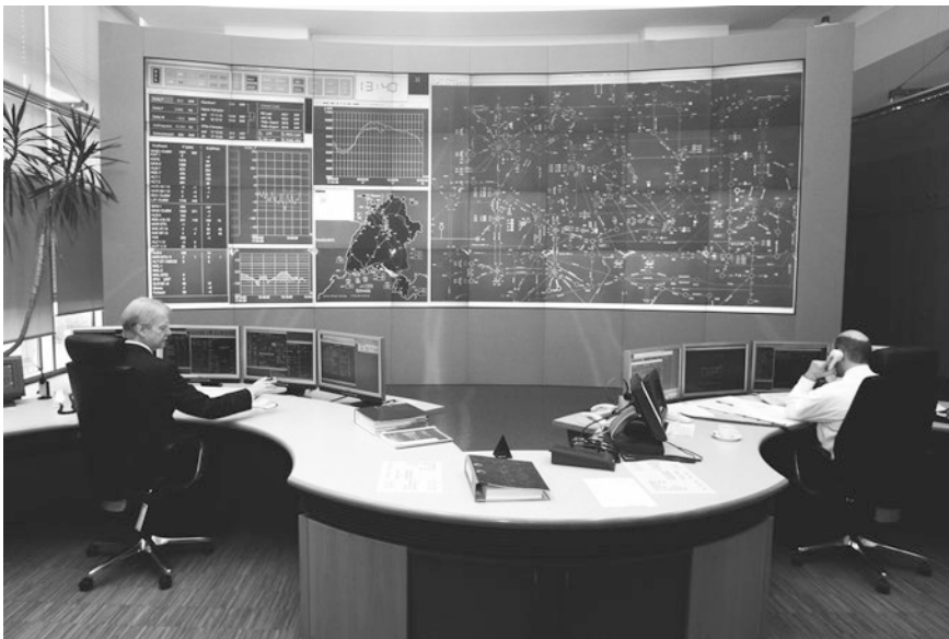
Abb. 8.28 Netzleitwarte der TransnetBW mit LED-Rückwärtsprojektion (TransnetBW GmbH)
