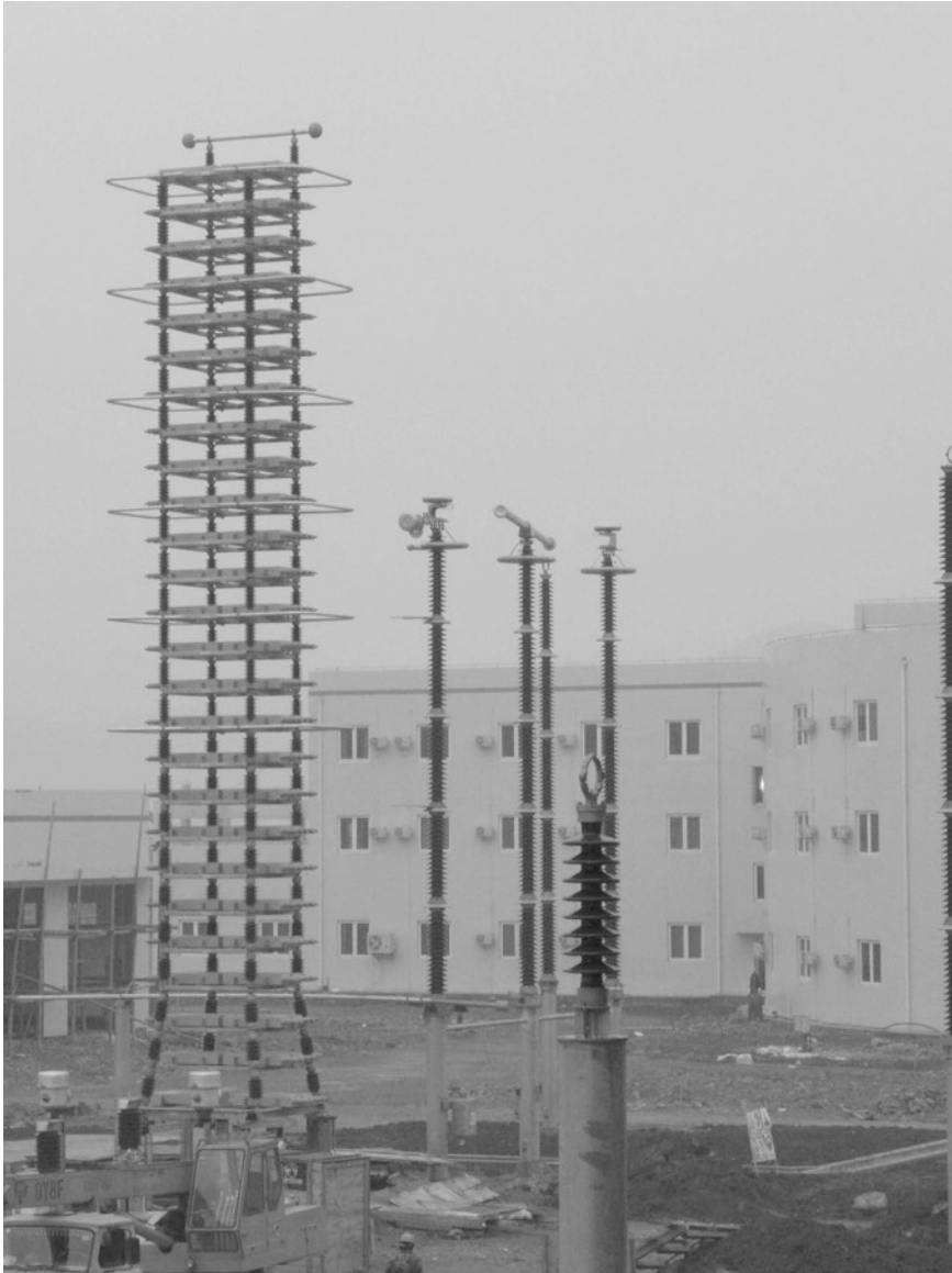
Abb. 3.40 Bau einer Kondensatorbank für eine 750-kV-HGÜ-Anlage (Stenner)
