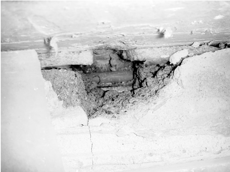
Abb. 3.15 Links überbrückt die Fliese die Randfuge des Estrichs. Der Randstreifen ist unterbrochen und der Estrich hat Wandkontakt, auch unten weil ein Kabel direkt vor der Wand liegt. Beide Gewerke wurden mangelhaft ausgeführt
