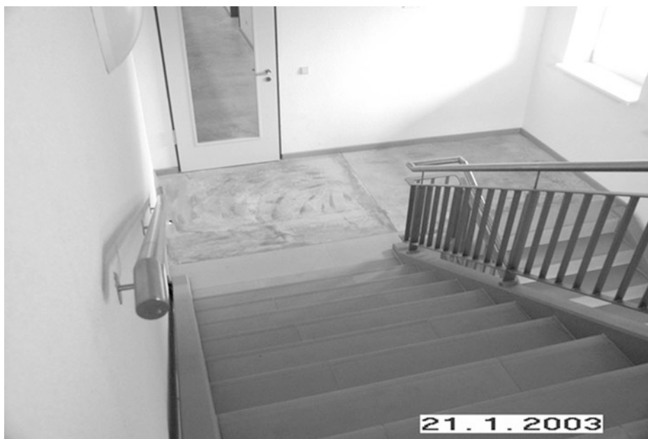
Abb. 6.13 Diese zweigeteilte Farbgebung eines Magnesiaestrichs innerhalb einer kleinen Podestfläche kann nicht mehr vertragsgerecht sein
