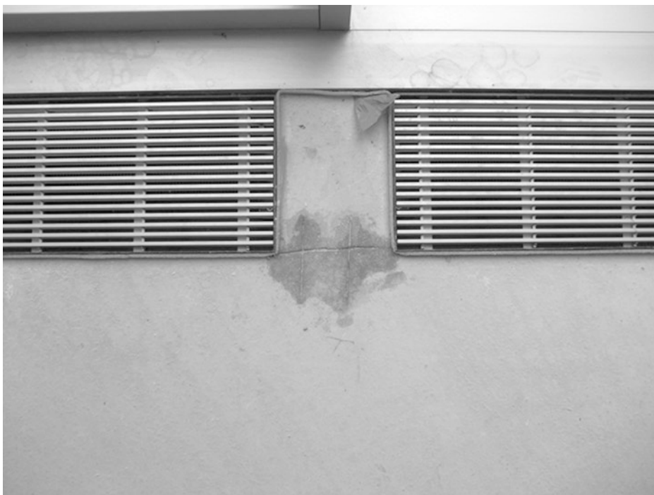
Abb. 3.26 Design-Spielerei provoziert Schwindrisse. Ein durchgehender Rost hätte das verhindert
