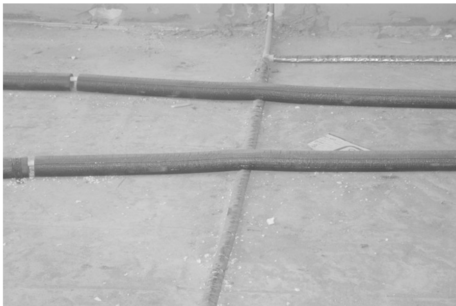
Abb. 7.4 Auf Decken erfordern in der Regel einen Ausgleichestrich
