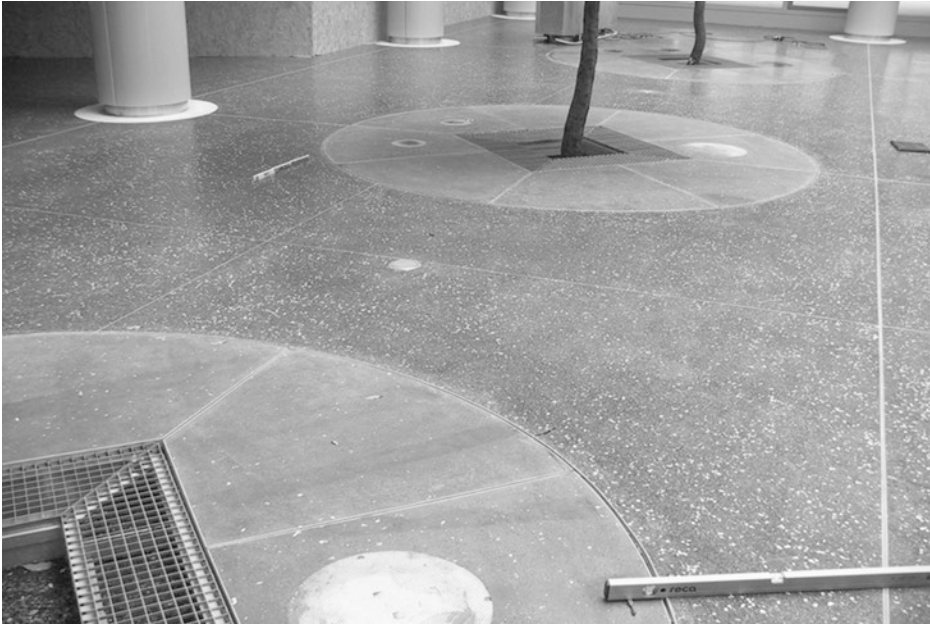
Abb. 2.22 Die Baumscheiben wurden im Werk, der Fußboden vor Ort hergestellt. Deutliche Unterschiede in Kornverteilung und Farbgebung
