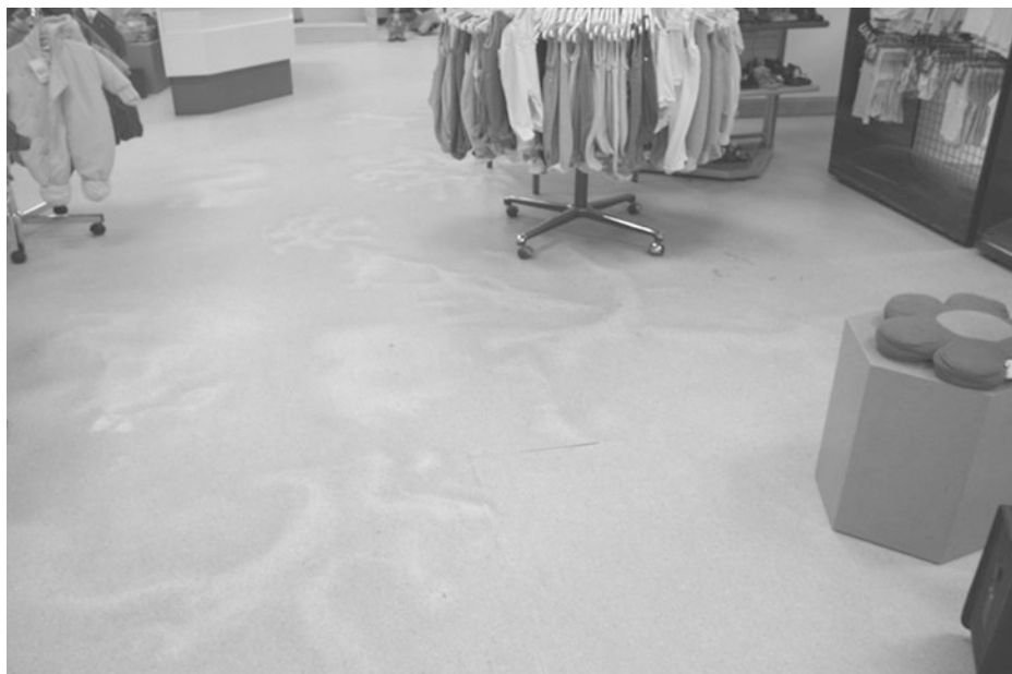
Abb. 6.18 Diese Belagablösung in einem Kaufhaus erfolgte einige Monate nach Belegung. Die Ursache der Schäden war ein 95 mm dicker CAF-Estrich, der auch 2 Jahre nach Herstellung noch ca. 1,4 CM-% Restfeuchte hatte. Er wurde viel zu früh belegt
