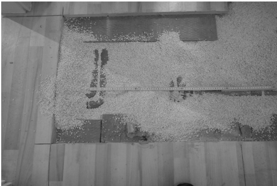
Abb. 1.7 Der Fertigteil Estrich brach jeweils genau über den weichummantelten Rohren in der Schüttung
