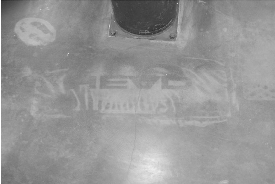
Abb. 6.14 Das längere Abstellen einer Werbetafel auf einem noch etwas zu feuchten Magnesiaestrich führte zu einer nunmehr dauerhaften „Werbung“ für den Hersteller von Tennis-Artikeln
