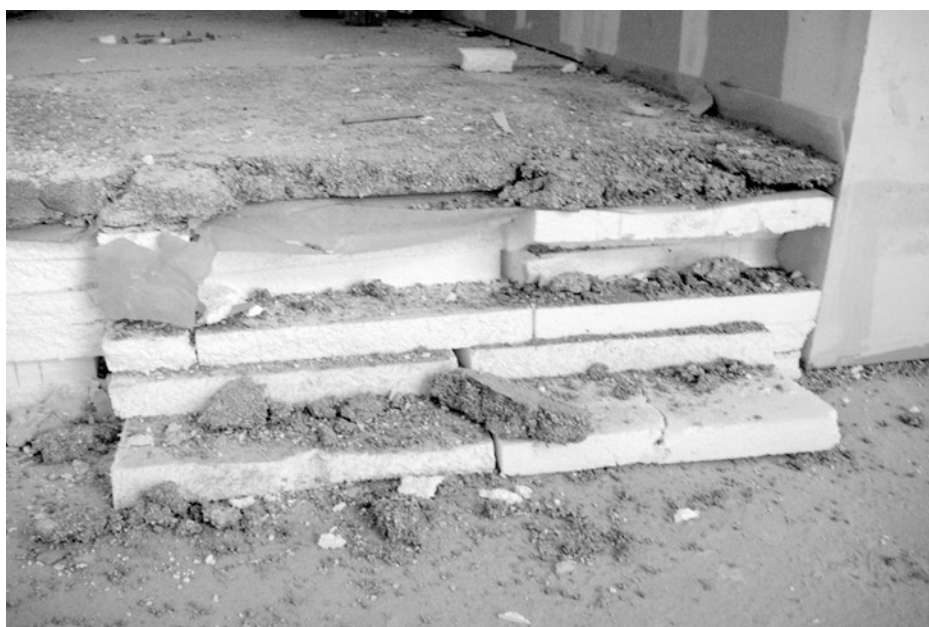
Abb. 2.4 Mangelhaft verlegte Ausgleichsschicht mit Lücken und ohne versetzte Stöße
