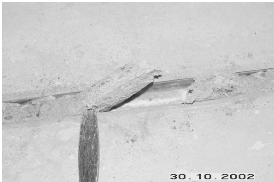
Abb. 3.19 Die im Heizestrich ausgebildete Bewegungsfuge ist mit 10 mm Tiefe nur vorgetäuscht
