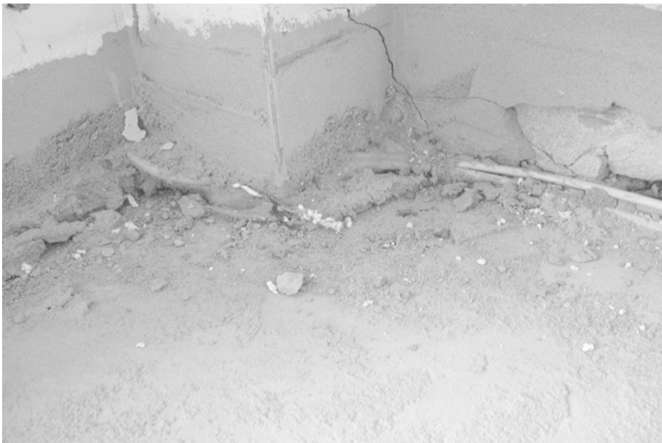
Abb. 2.2 Kein geeigneter Untergrund für eine Dämmschichtverlegung
