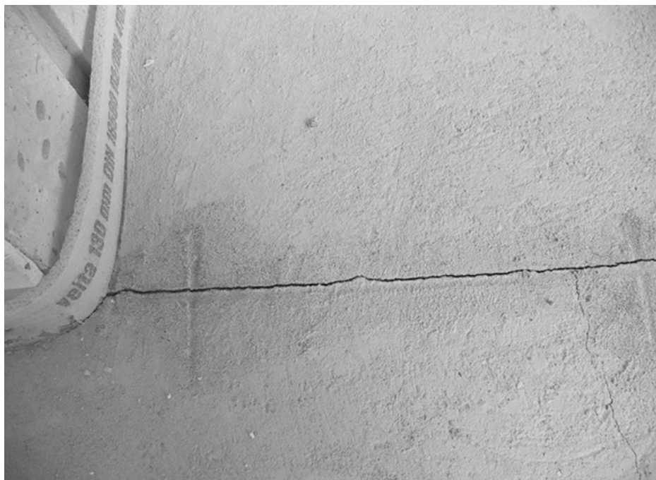
Abb. 12.2 Erneutes Aufreißen einer Scheinfuge, weil sie zu früh festgelegt wurde
