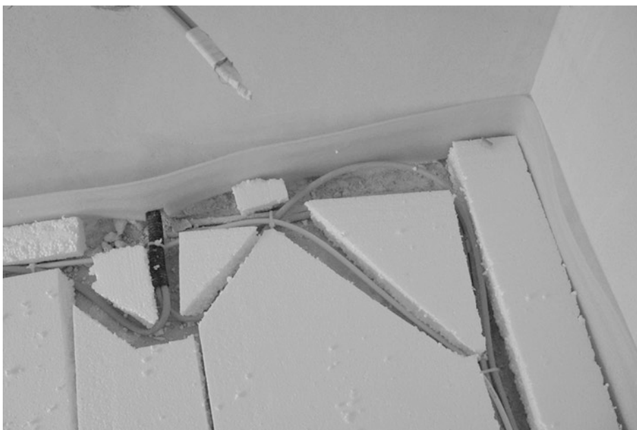
Abb. 2.6 Kabelverlegung und Ausgleichsschicht mangelhaft. Die Kabelverlegung erfordert vom Estrichbetrieb zeitaufwändige Anpassungen, die der Auftraggeber als „Besondere Leistung“ nach VOB/C vergüten muss
