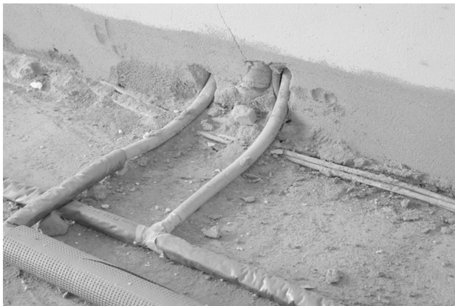
Abb. 2.3 Kein geeigneter Verlegeuntergrund für Dämmschichten
