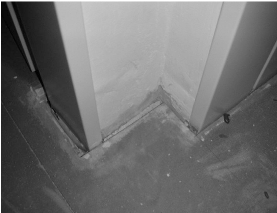
Abb. 1.5 Die Verlegung der GK-Platten erfolgte mangelhaft mit großen Abständen zur Zarge
