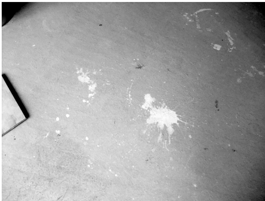
Abb. 12.4 Typische Verschmutzungen, die mechanisch entfernt werden müssen
