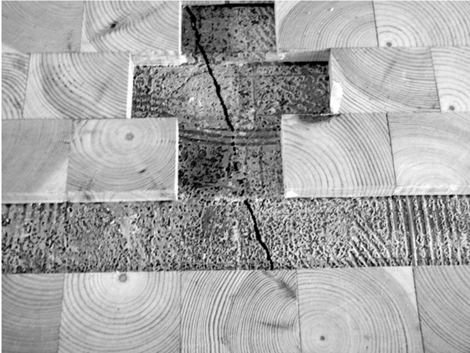
Abb. 12.10 Breiter Riss im Zementestrich unter dem Holzpflaster. Die Ursache sind Zugkräfte, die von dem Holzpflaster über den harten Klebstoff auf den Estrich wirken
