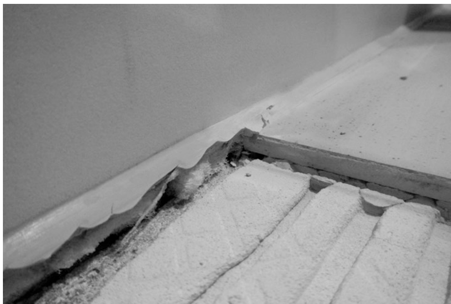
Abb. 12.15 Der Dünnbettmörtel wurde nur flach gedrückt, haftete aber nicht mehr an der Fliese
