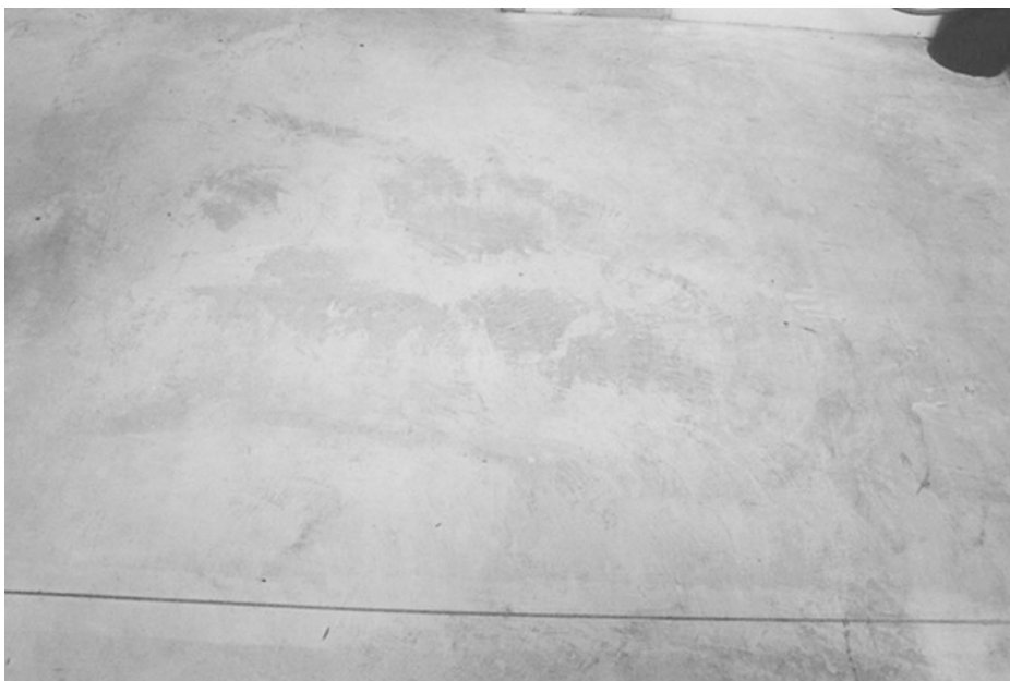
Abb. 6.11 Ein Magnesiaestrich mit nicht unüblichen Farbunterschieden in einem Lager
