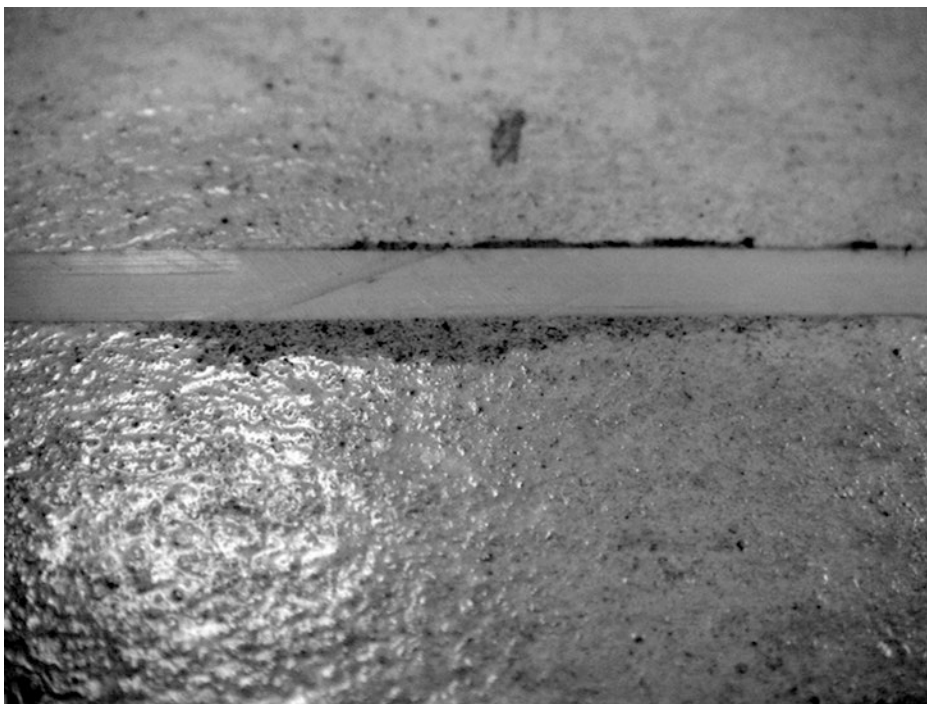
Abb. 12.7 Die rauen Bereiche neben der Fuge wurden durch ein Nacharbeiten mit einem Messer verursacht. Der Belag weist dadurch einen irreversiblen Schaden auf
