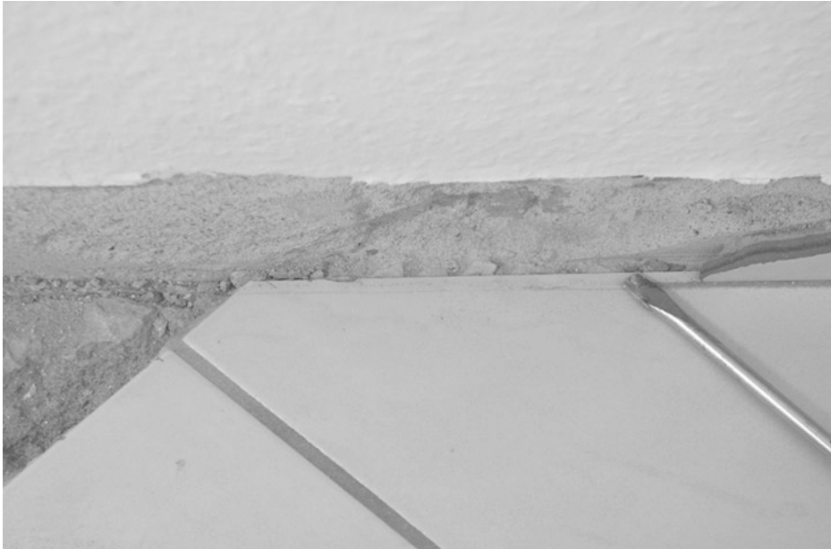
Abb. 3.18 Die Fliese wurde bis an die Wand geführt und überbrückte die Randfuge des Estrichs
