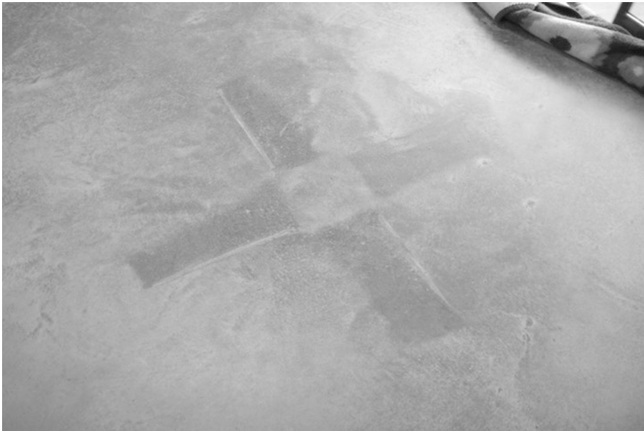
Abb. 1.8 Auf dem Estrich ließ man den Flügelglätter stehen und erzeugte einen bleibenden Mangel in dem Sichtestrich einer Ladenfläche
