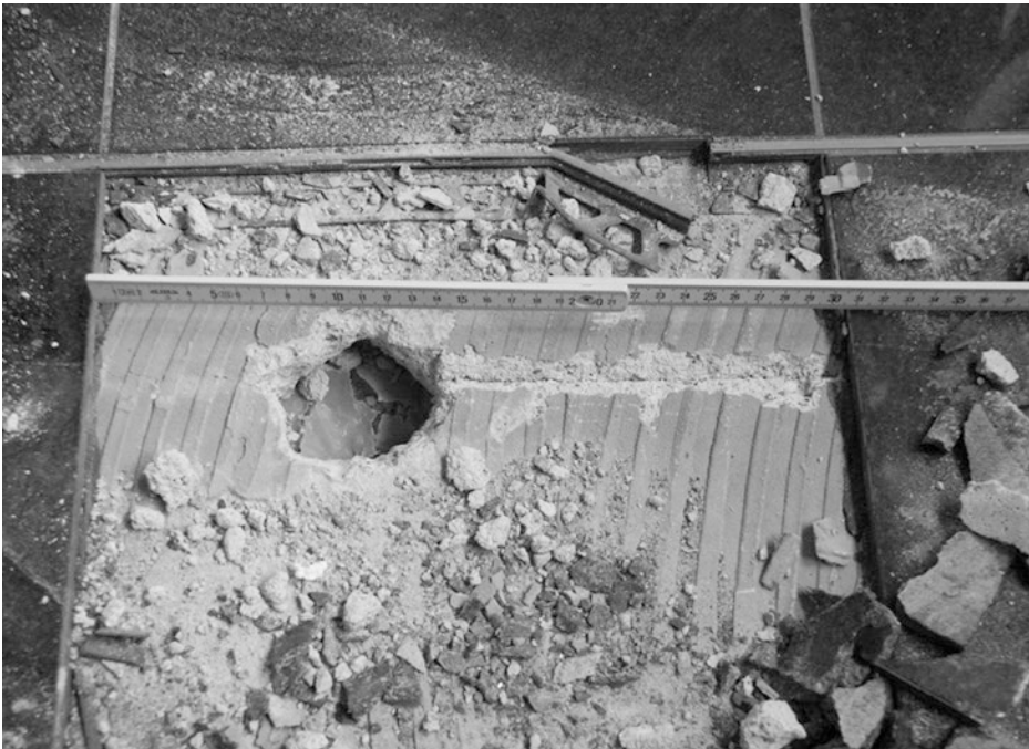
Abb. 3.25 Riss in einem Naturwerksteinbelag auf einem Estrich auf Dämmschicht, über einer Scheinfuge, die im Estrich vor dem Belegen nicht kraftübertragend festgelegt und verfüllt wurde
