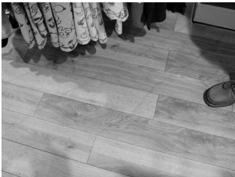
Abb. 12.8 Die dunklen Streifen waren kaum tastbare mit Schmutz aufgefüllte Vertiefungen
