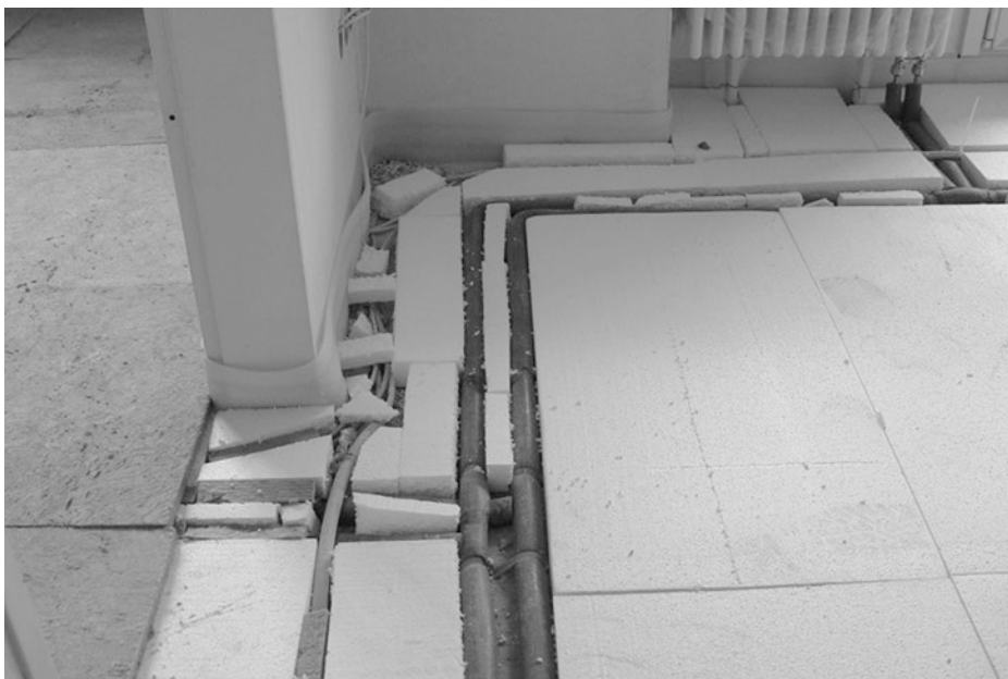
Abb. 2.5 Entsorgung von EPS-Reststücken in der Ausgleichsschicht. Mangelhaft!
