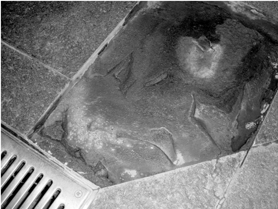
Abb. 12.16 In den Hohlräumen des Mittelbettmörtels sammelte sich Wasser, das die Unterseite des Naturwerksteins quellen ließ. Die Platte verwölbte sich konkav. Auch hygienisch inakzeptabel
