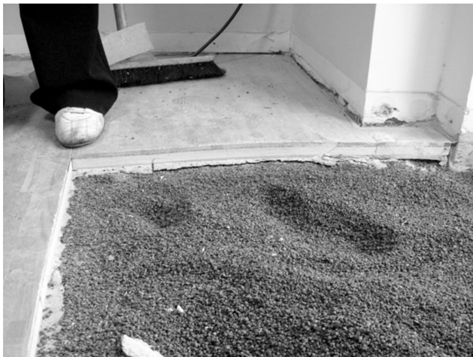
Abb. 12.11 Konvexe Verwölbung von Parkett und Fertigteilestrich
