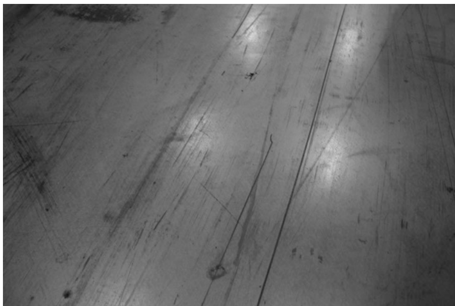
Abb. 1.3 Kunstharzbeschichtungen sind häufig kratzempfindlich und dann schwer zu reinigen
