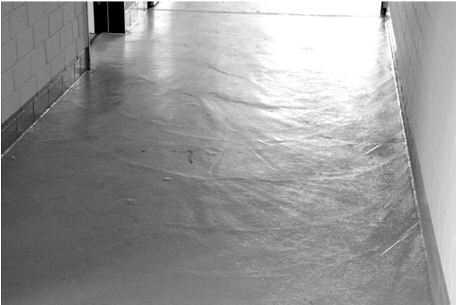
Abb. 6.9 Geglättet, jedoch deutliche Spuren der Oberflächenbearbeitung
