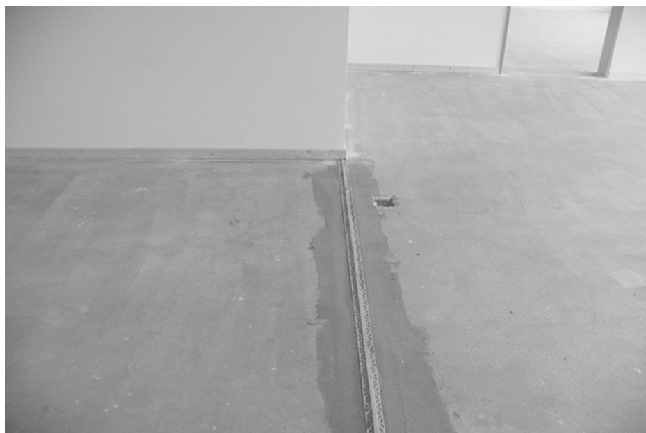
Abb. 3.20 Obwohl es nur einen Heizkreis gab und Linoleum verlegt werden sollte, wurde hier nachträglich völlig unnötig eine Bewegungsfuge ausgebildet, die wegen der durchlaufenden Heizelemente zudem nicht normenkonform ist
