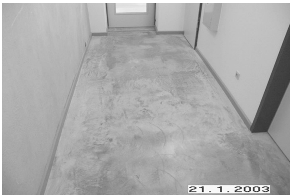
Abb. 6.12 Dieser Magnesiaestrich in einem Schulflur liegt sicher im Grenzbereich
