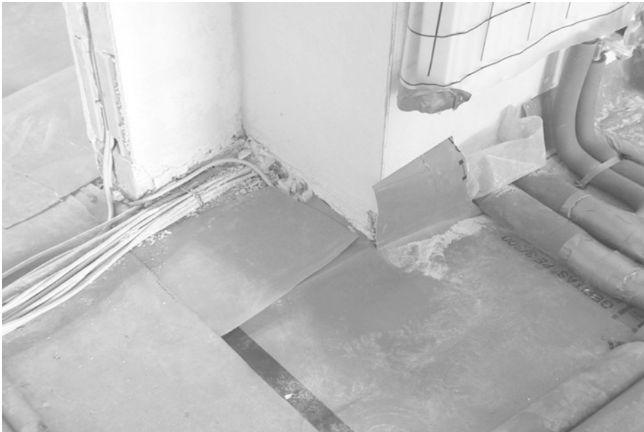
Abb. 2.17 Ein typischer Fall, der nur mit einem Ausgleichestrich bewältigt werden kann
