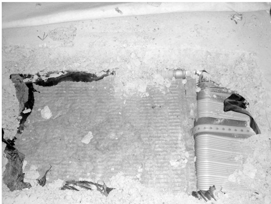
Abb. 7.6 Hier liegen Heizkanäle auf der Decke direkt unter dem Estrich. Die Mineralfaser-Trittschalldämmschicht wurde nur an die Kanäle herangeführt. Die Ausführung mindert den erreichbaren Trittschallschutz erheblich und ist daher mangelhaft
