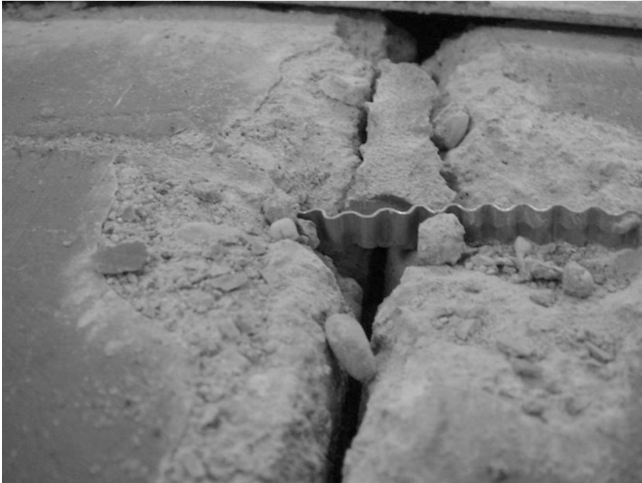
Abb. 3.5 Dieser Wellverbinder wäre geeignet gewesen, wenn er in Kunstharz eingebettet und tiefer im Estrichquerschnitt angeordnet worden wäre
