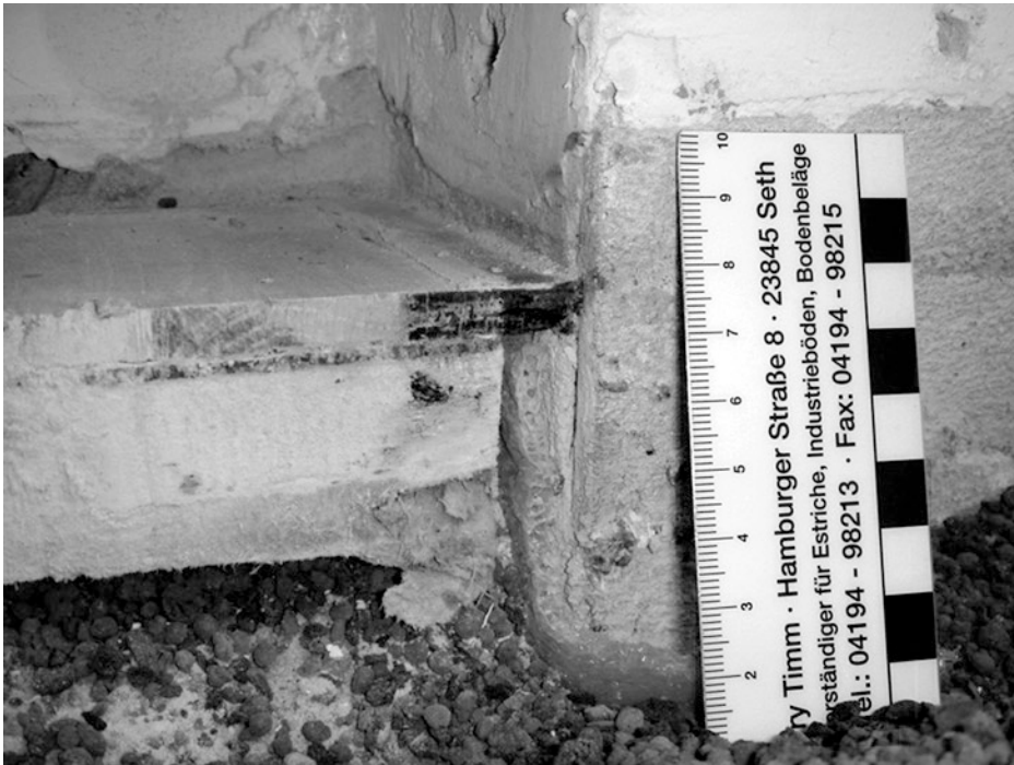
Abb. 12.12 Die Randfuge des Fertigteil Estrichs wird vom Parkett überbrückt
