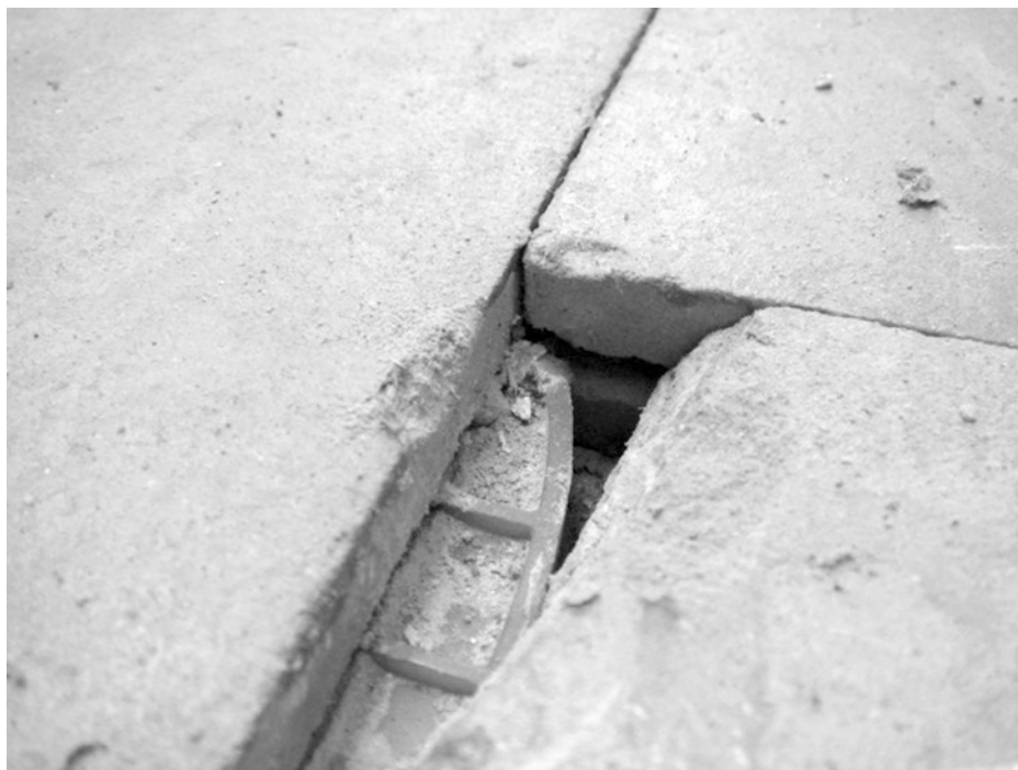
Abb. 1.6 Der Flachdübel in der Nut der Fertigteilstrichelemente sollte eigentlich so eingebaut werden, dass die beiden angrenzenden Platten in der Fuge gestützt werden. So wie der Dübel lag, entstanden deutliche vertikale Bewegungen, die einen Rückbau erforderten
