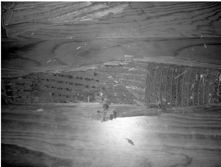
Abb. 12.13 Das Kleberbett unter den hochgewölbten Dielen hatte nie hinreichend Kontakt zur Diele
