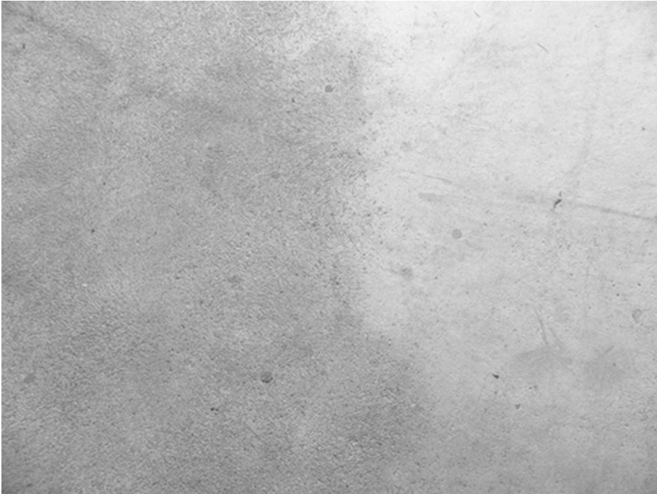
Abb. 6.8 Eine geglättete Oberfläche rechts, aber links nur gerieben
