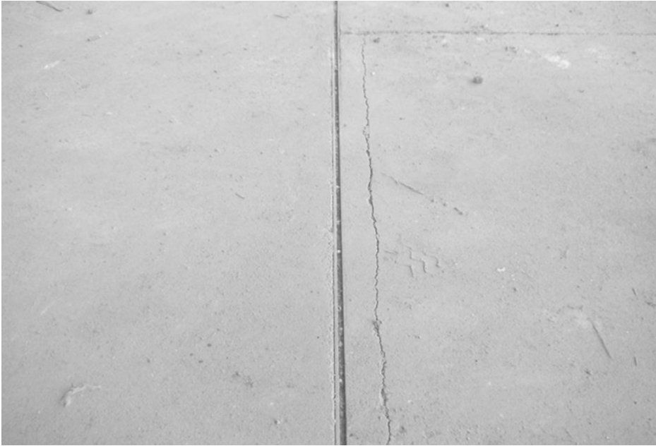
Abb. 3.8 Metallprofile mit geringer Estrich-Überdeckung führen zu diesen Schäden
