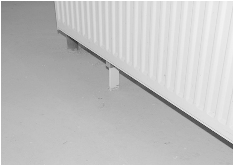
Abb. 3.14 Auch Heizkörperkonsolen sind mit Randfugen zu trennen und nicht wie hier, fest einzubinden
