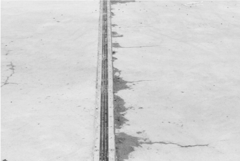
Abb. 3.11 Typisches Rissbild, wenn der Verbundestrich auf den Schenkeln des Profils nicht haftet
