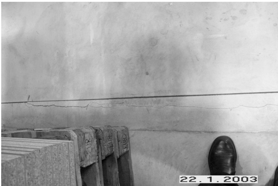
Abb. 3.6 Typische Rissbildung, wenn die geschnittene Fuge und die Pressfuge im Untergrund nicht deckungsgleich verlaufen
