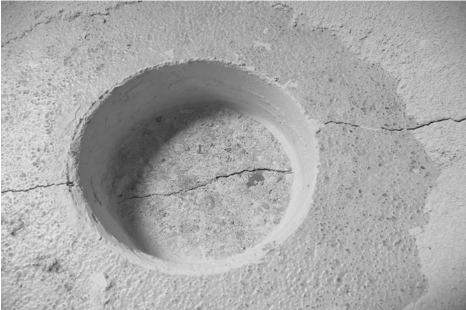
Abb. 3.24 Riss in einem Verbundestrich über einem Schwindriss der Betonsohle ohne Hohllagen
