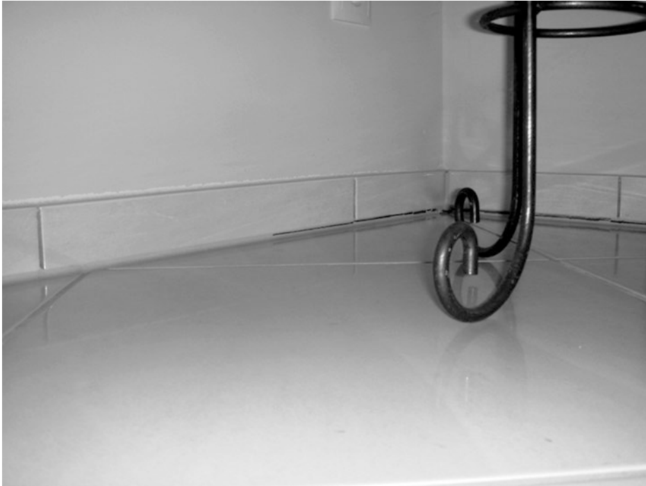
Abb. 12.3 Typische Absenkung in den Raumecken bei zu früher Fliesenverlegung
