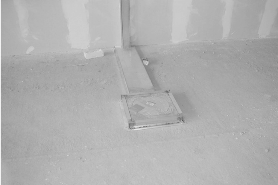
Abb. 2.18 Hier kann mit einer Wärmedämmschicht ausgeglichen werden, besser mit Ausgleichesrich
