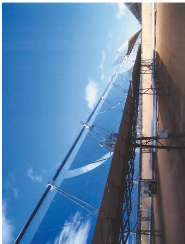
Abb. 2.43 Parabolrinne mit Solarreceiver. (Bildrechte: SCHOTT AG)
