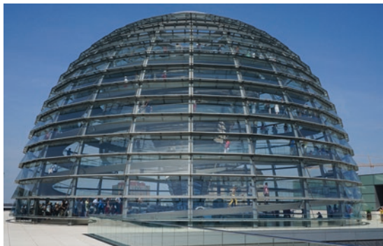
Abb. 2.21 Kuppel des Reichstages in Berlin. Glaskuppel aus hoch transparentem, eisenarmen Floatglas, Sicherheitsverbundglas, 2 \times 12,5 mm. (Bildrechte: Walburga Schaeffer)
