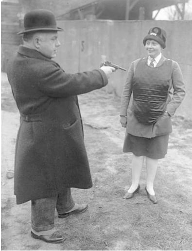
Abb. 6.36. Schutzwestenprüfung im Jahre 1931. Originalbildtitel: „Der Kugelschützpanzer ist eine deutsche Erfindung und wird von der Berliner Kriminalpolizei bei Kämpfen mit Verbrechern getragen“. (Quelle siehe Abbildungsnachweis).
