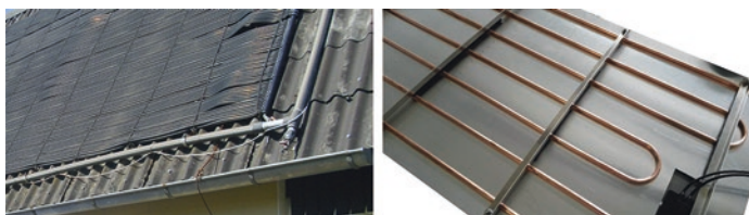
Abb. 4.14 Einfacher Schwimmbadabsorber aus Rohrmatten (links), Rückseite eines PVT-Moduls mit aufgeklemmtem Kupferrohr (rechts) [4]
