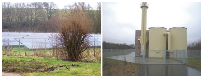
Abb. 4.18 Solarthermiefeld mit 1422 m 2 Kollektorfeldfläche (links) sowie Heizzentrale mit zwei Hackschnitzelkesseln (900 kW, 360 kW) und zwei großen Pufferspeichern mit je 60 m 3 (rechts) in Neuerkirch-Külz
