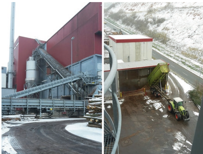
Abb. 3.27 Biomasse-Kraftwerk Bischofferode, Transport der Hackschnitzel zum Brennstoffbunker (links), Anlieferung von Hackschnitzeln (rechts)
