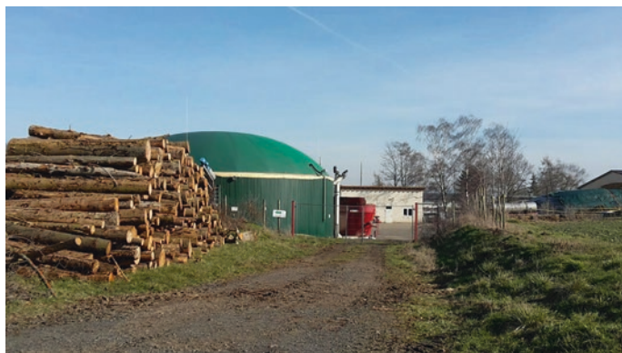
Abb. 3.28 Fermenter einer bäuerlich betriebenen Biogasanlage
