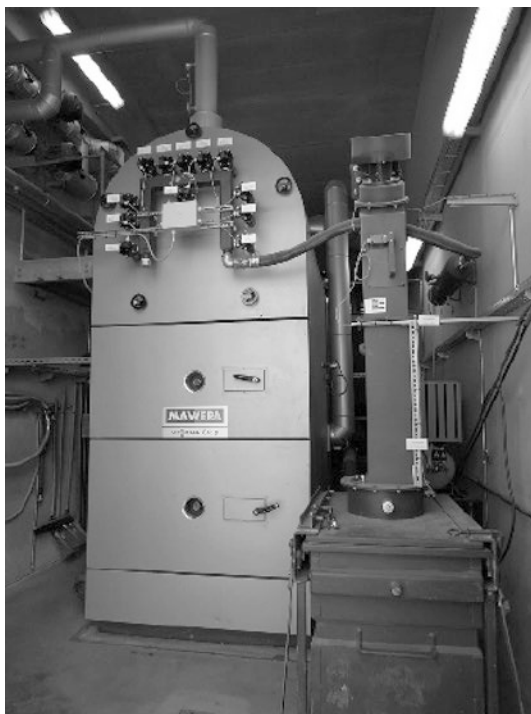
Abb. 4.3 Hackschnitzelkessel mit 800 kW Leistung in der Heizzentrale eines Fernwärmenetzes [9]
