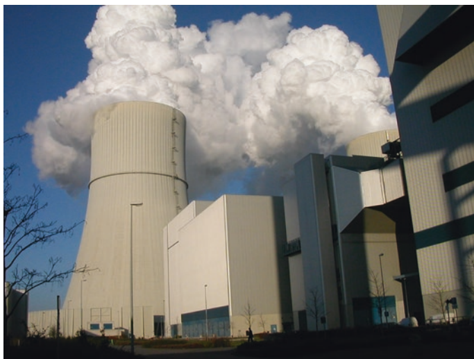
Abb. 3.3 Braunkohlekraftwerk Schwarze Pumpe mit Dampfschwaden aus den Nasskühltürmen
