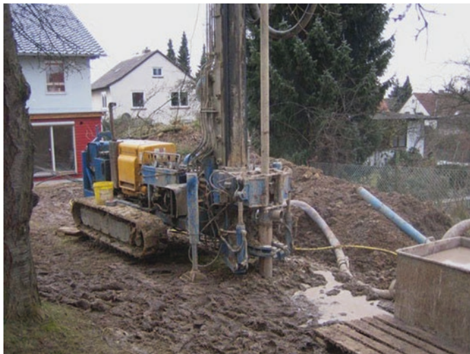
Abb. 4.5 Bohrung für eine Erdwärmesonde
