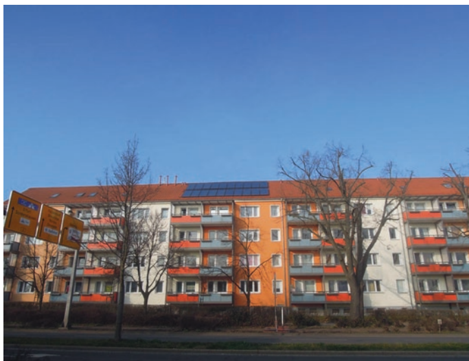
Abb. 4.9 Solarthermische Anlage auf dem Dach eines Mehrfamilienhauses. (Foto: P. Steinert)
