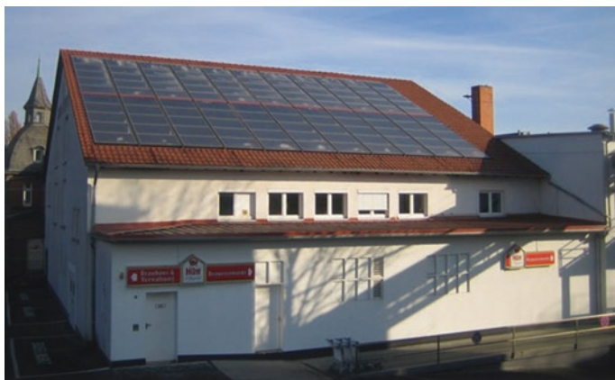
Abb. 4.17 Kollektorfeld der Hütt-Brauerei in Baunatal, Nordhessen
