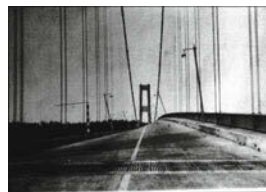
Entgegen weitläufiger Meinung spielte Resonanz beim Einsturz der Tacoma-Narrows-Bridge im Jahre 1940 eine weitaus geringere Rolle als das durch den Wind hervorgerufene aerodynamische Flattern.
