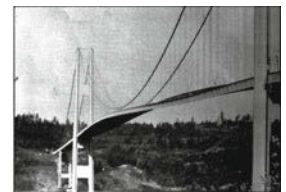
Entgegen weitläufiger Meinung spielte Resonanz beim Einsturz der Tacoma-Narrows-Bridge im Jahre 1940 eine weitaus geringere Rolle als das durch den Wind hervorgerufene aerodynamische Flattern.
