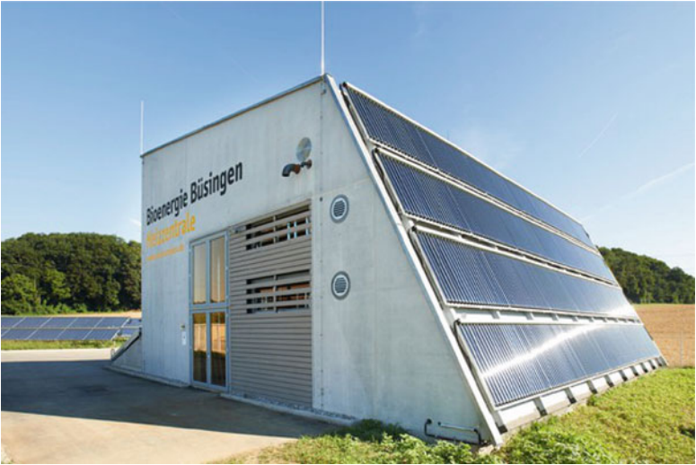
Abb. 6.19 Kollektorfeld Nord mit Heizzentrale, aus [43]
