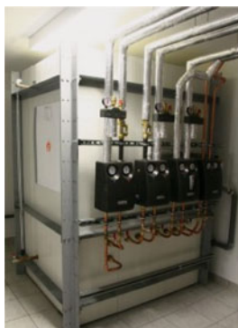
Abb. 3.17 Modularer druckloser Pufferspeicher mit drei hydraulischen Kreisläufen (links), rechts Einbausituation in einem Kellerraum (Fa. FSAVE, Kassel [27])
