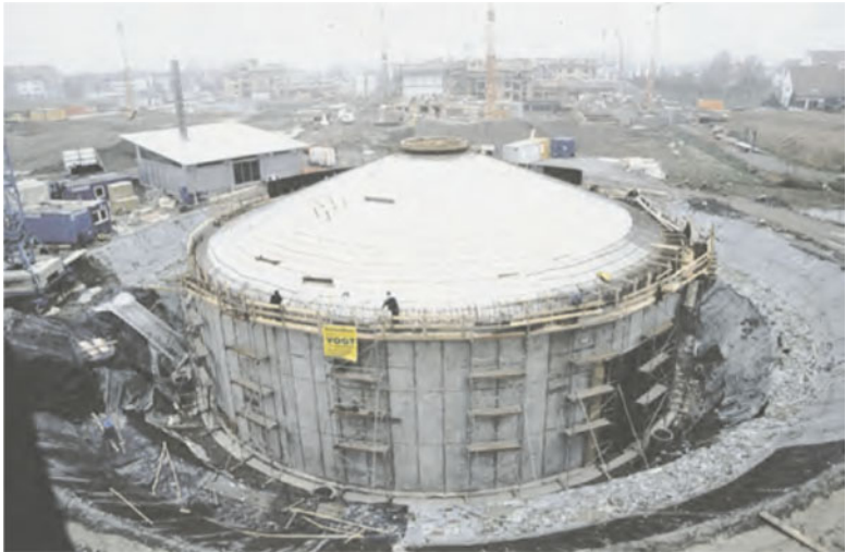
Abb. 4.8 Bau eines 12.000 \text{ m}^3 großen Betonspeichers zur Langzeit-Wärmespeicherung in Friedrichshafen (Foto: ITW Stuttgart)
