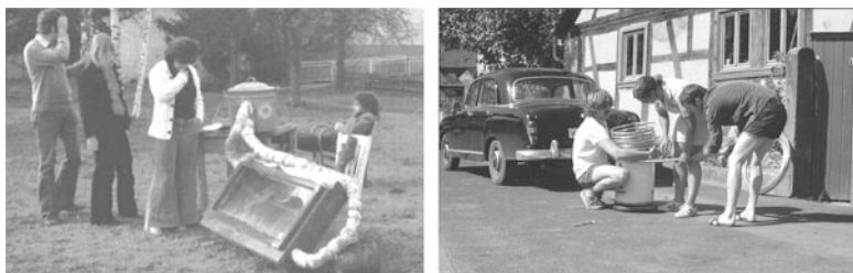
Abb. 7.3 Studentische Umweltgruppe in Marburg beim Bau eines dachintegrierten Solarkollektors (1979) und eines Solarwärmeübertragers. Aus der Umweltgruppe ging das Unternehmen Wagner & Co hervor, ein Pionier der Solarthermie [51]
