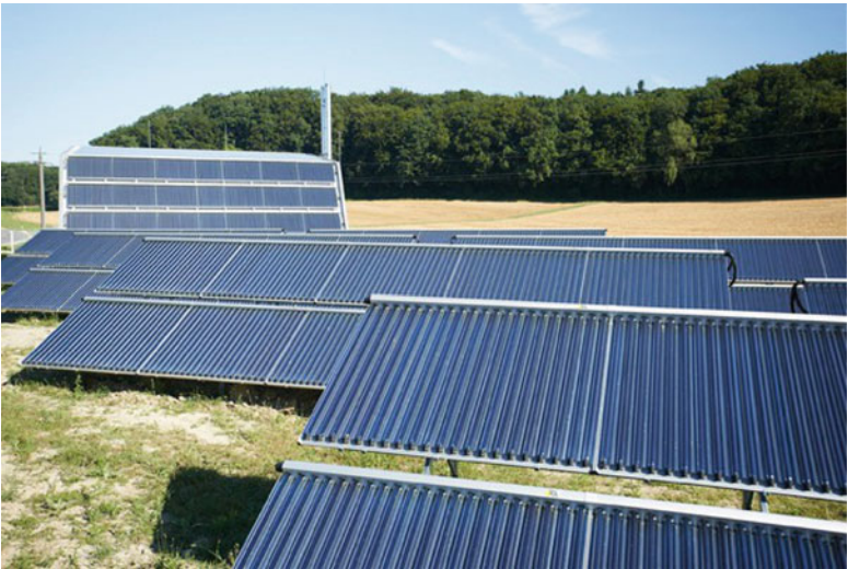
Abb. 6.20 Kollektorfeld Süd mit Heizzentrale im Hintergrund, aus [43]
