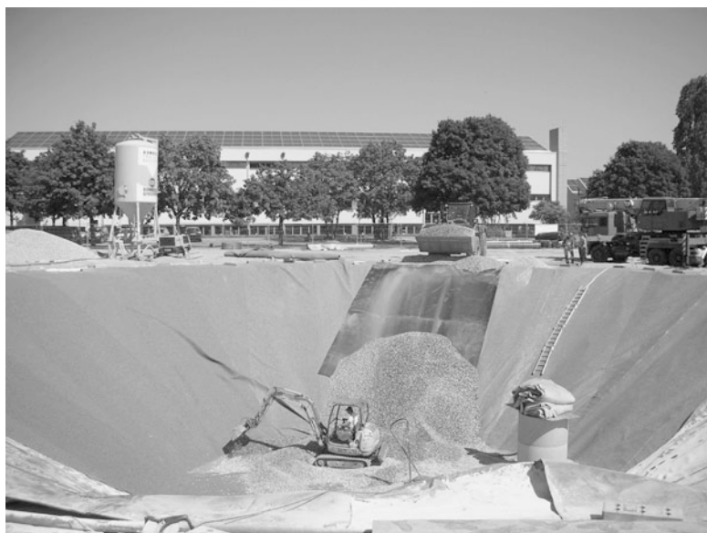
Abb. 4.9 Bau eines Kies-Wasser-Wärmespeichers für eine solar unterstützte Nahwärmeversorgung in Eggenstein-Leopoldshafen (Foto: Solites, Stuttgart)
