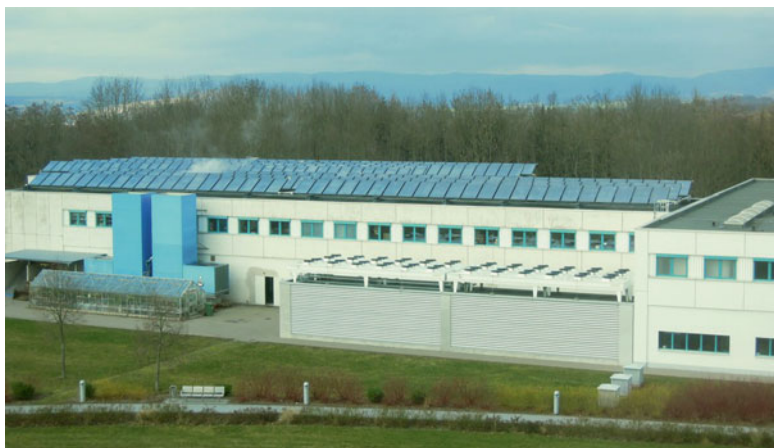
Abb. 6.14 Kollektorfeld auf der Apotheke und dem Technikbau des Südharzkrankums
