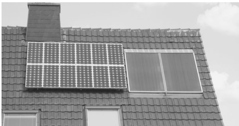
Abb. 1.1 Photovoltaik- ( links ) und Solarthermieranlagen ( rechts ) nutzen beide die Solarenergie
