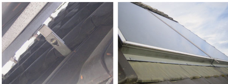
Abb. 3.12 Kollektoren in Aufdachmontage ( links ) mit höhenverstellbarem Sparrenanker und in Indachmontage ( rechts ) mit Rahmenprofil und Bleischürze zum Regenablauf
