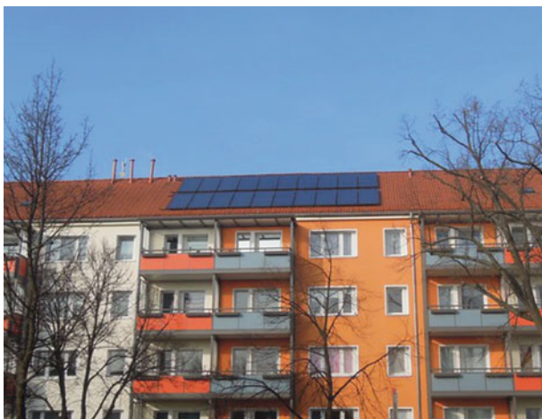
Abb. 6.12 Kollektorfeld einer solaren Trinkwassererwärmung im Mehrfamilienhaus
