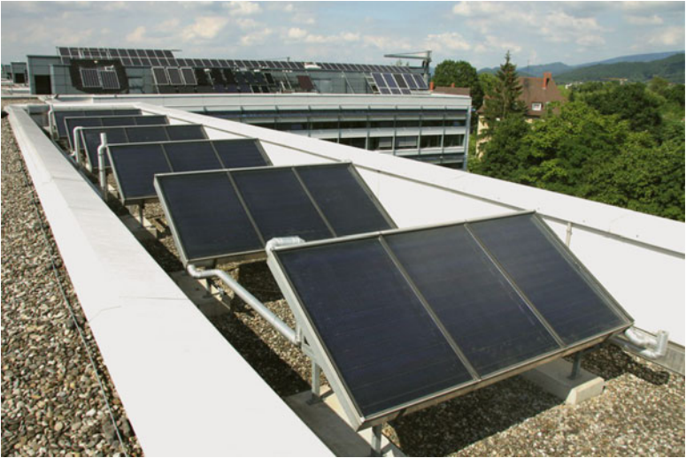
Abb. 3.2 Flachkollektorfeld auf dem Dach des Fraunhofer ISE in Freiburg [40], (Foto Fraunhofer ISE)
