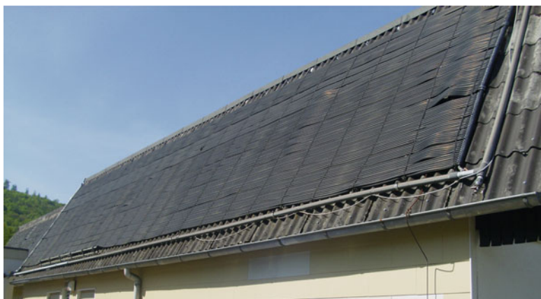
Abb. 3.1 Einfacher Schwimmbadabsorber aus Kapillarrohrmatten auf dem Dach eines kombinierten Frei- und Hallenbades
