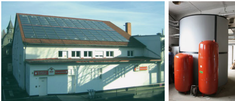
Abb. 6.16 Kollektorfeld der Hütt-Brauerei ( links ) und Solarspeicher ( rechts ) [48]
