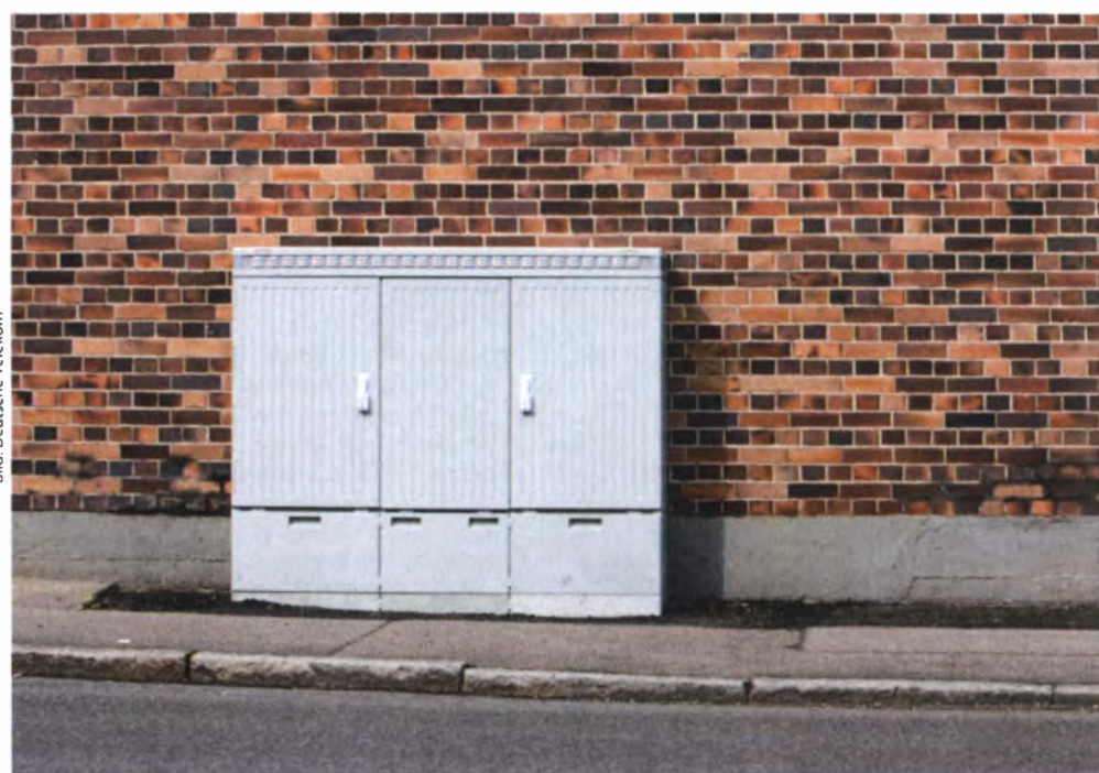
Outdoor-DSLAMs stehen möglichst nah bei den über sie versorgten Haushalten. Man erkennt sie an den Lüftungsschlitzen, durch die die Abwärme der aktiven Komponenten abgegeben wird.
