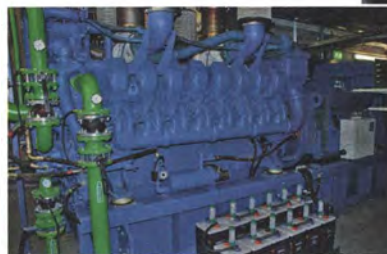
Lamellenvorhänge aus PVC sorgen im unterirdischen Rechenzentrum für eine saubere Trennung von kalter und warmer Raumluft. Die Hochverfügbarkeit gewährleisten Hunderte Akkus und eine redundant ausgelegte Diesel-USV mit zwei 16-Zylinder-Maschinen.
