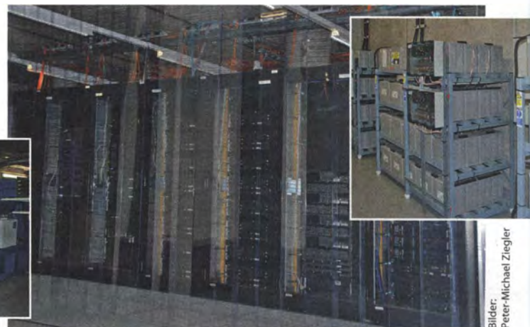
Lamellenvorhänge aus PVC sorgen im unterirdischen Rechenzentrum für eine saubere Trennung von kalter und warmer Raumluft. Die Hochverfügbarkeit gewährleisten Hunderte Akkus und eine redundant ausgelegte Diesel-USV mit zwei 16-Zylinder-Maschinen.
