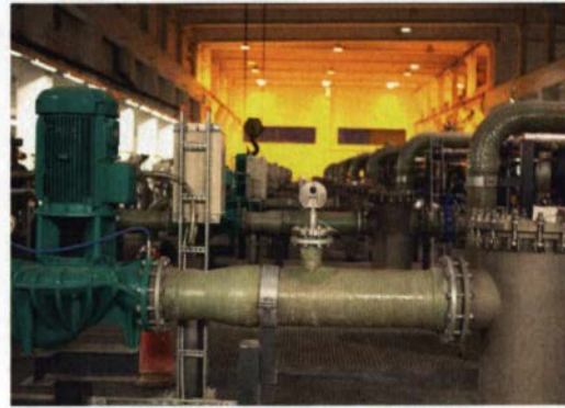
Rechenzentrum mit Meerwasserkühlung: Google spart Energie für die Klimatisierung der Server-Räume.
