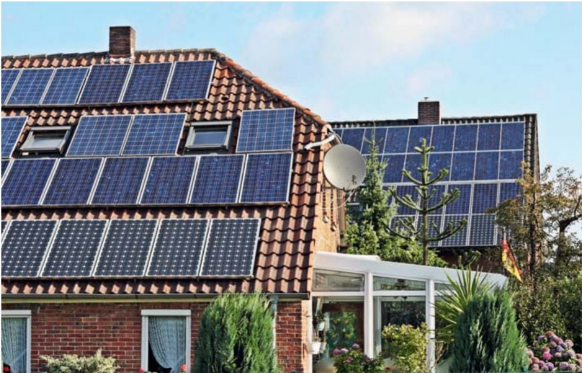
Blick auf deutsche Dächer. Eine Photovoltaikanlage besteht aus Modulen, die per Spezialkabel verschaltet werden. Optimal ist eine Ausrichtung nach Süden.
