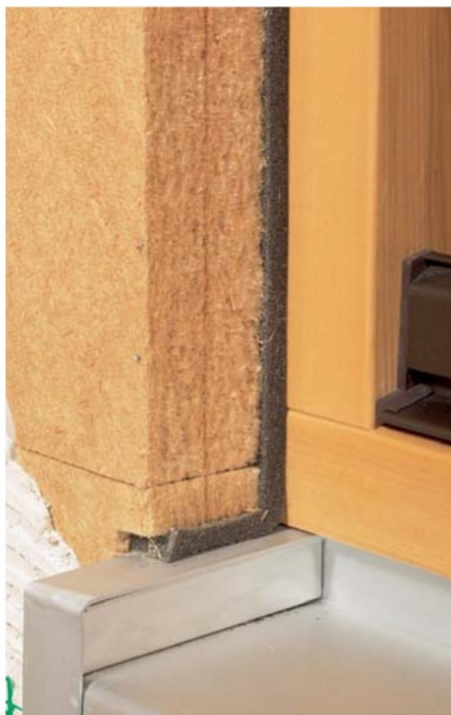
Wärmebrücken: Rund um die Fenster müssen die Handwerker sorgfältig arbeiten, damit die Wärme drinnen bleibt.
