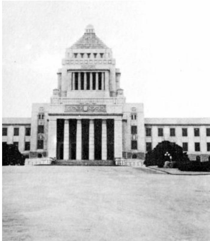
© Abb. 27: Das Reichstagsgebäude
