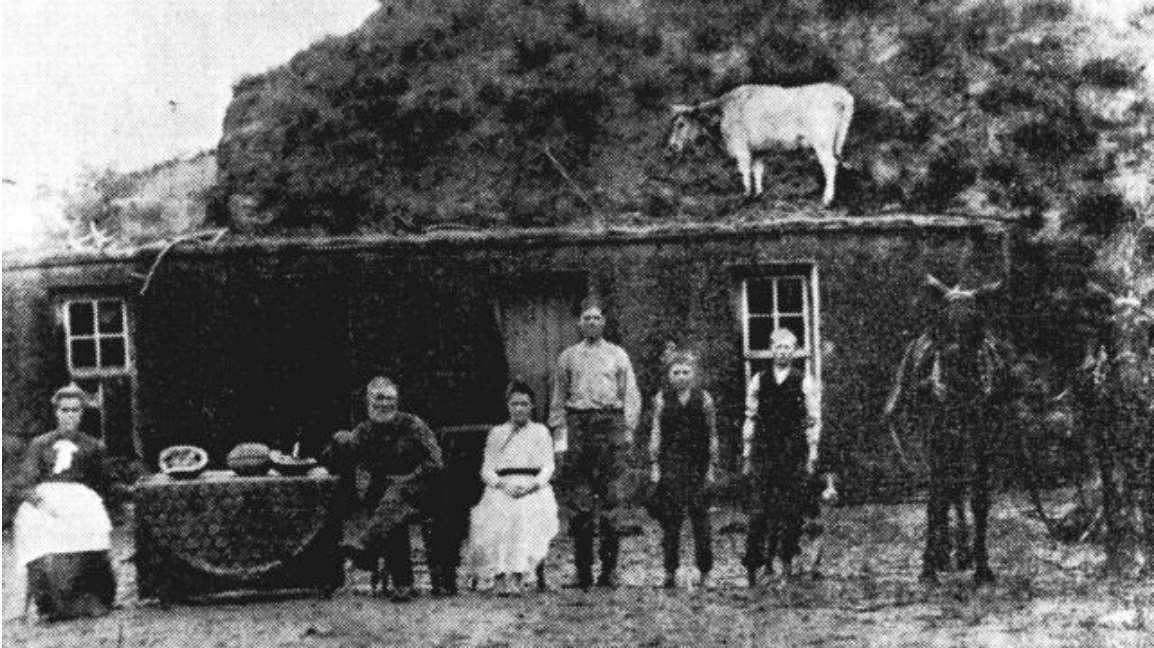
© Abb. 19: Siedlerfamilie vor ihrem ersten Behelfsheim in der Prärie; das Haus ist aus Grassoden gebaut, 1880.
