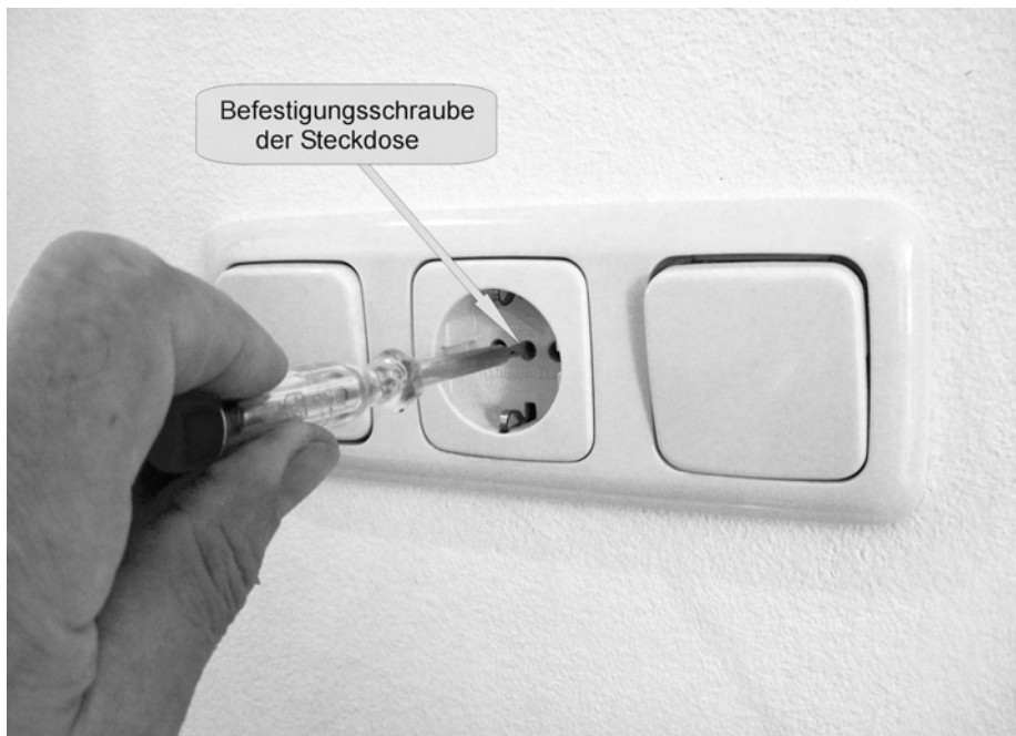
Abb. 44: Wenn Lichtschalter zusammen mit einer Steckdose in einem gemeinsamen Rahmen untergebracht sind, muss vor der Demontage der Lichtschalter erst die Befestigungsschraube der Steckdosenfront losgeschraubt werden.
