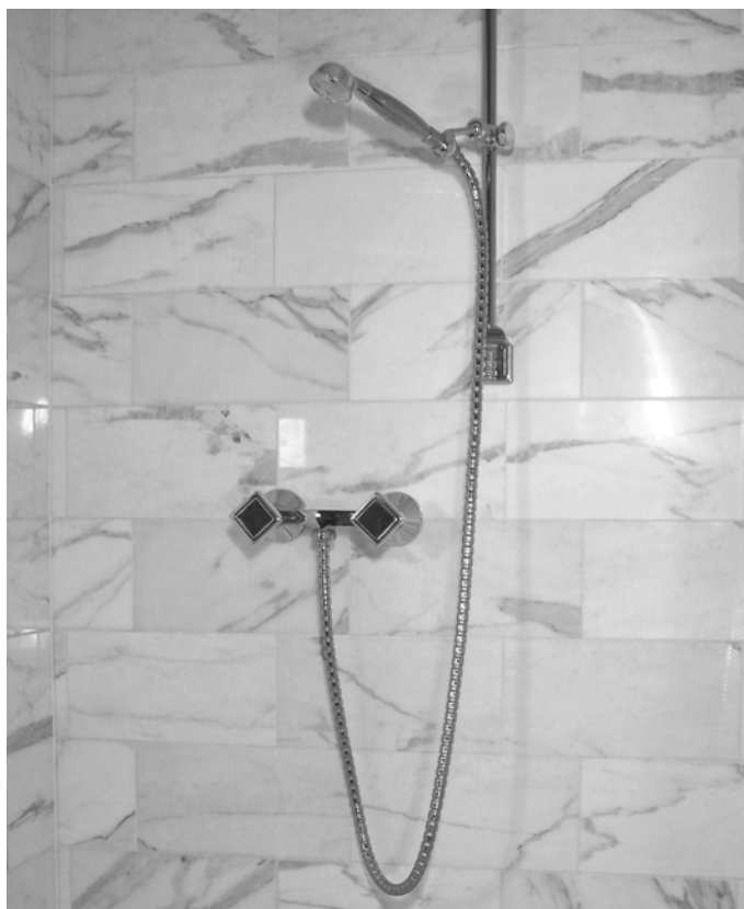
Abb. 15: Eine Dusch-Mischbatterie mit Keramikdichtungen derselben Type unterscheidet sich von der Spülbecken-Mischbatterie zwar etwas in der Form, hat aber dieselben Ventile.
