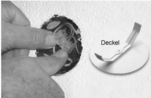
Abb. 137: Dosenklemmen sollten pro Abzweigdose nur als eine einzige Klemmleiste untergebracht werden.
