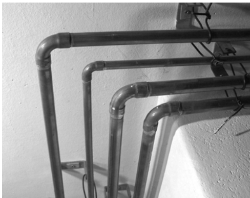
Abb. 77: Ausführungsbeispiel von Kupferrohr-Leitungen mit Fitting-Bögen (Leitungen in Bearbeitung)
