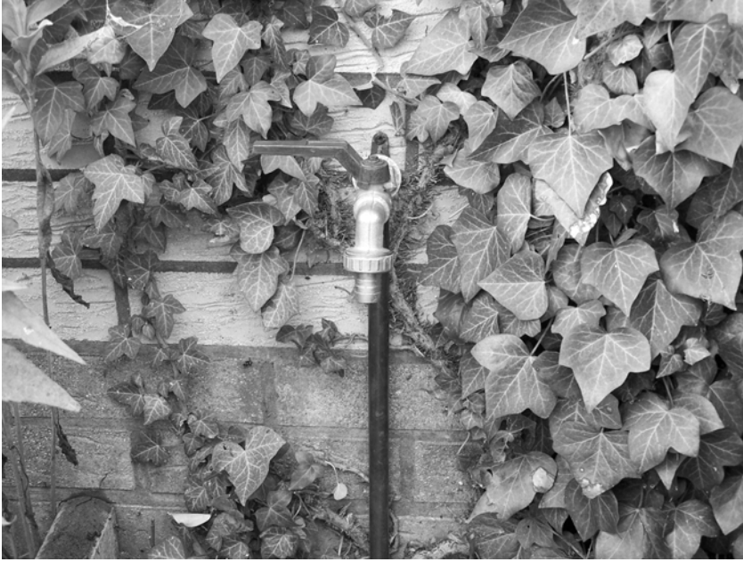
Abb. 84: Ein Außen-Wasserhahn kann problemlos an die Mauer angebracht werden, wenn innen im Haus (im Keller) der Kaltwasser-Anschluss vorhanden ist
