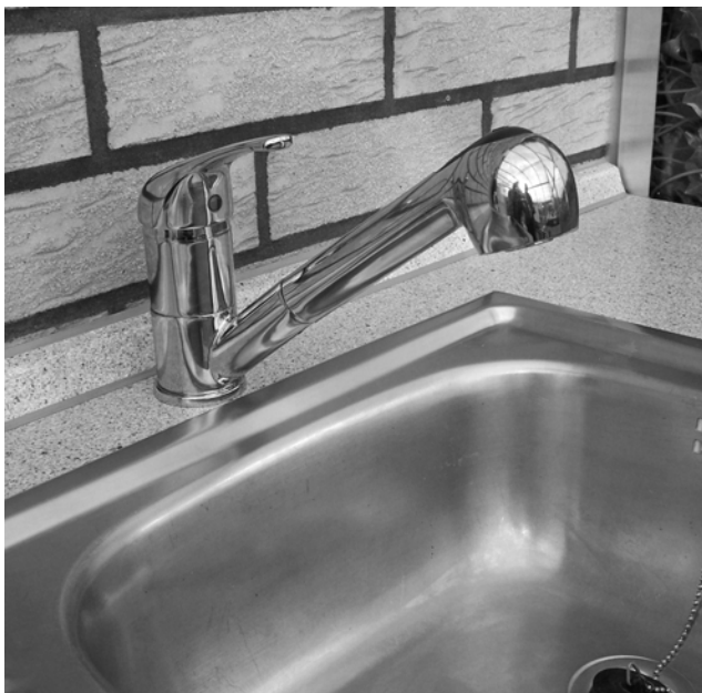
Abb. 40: Tisch-Mischbatterien sind an Wasserzuleitungen über eigene Absperrventile angeschlossen, die sich unter dem Waschbecken befinden.
