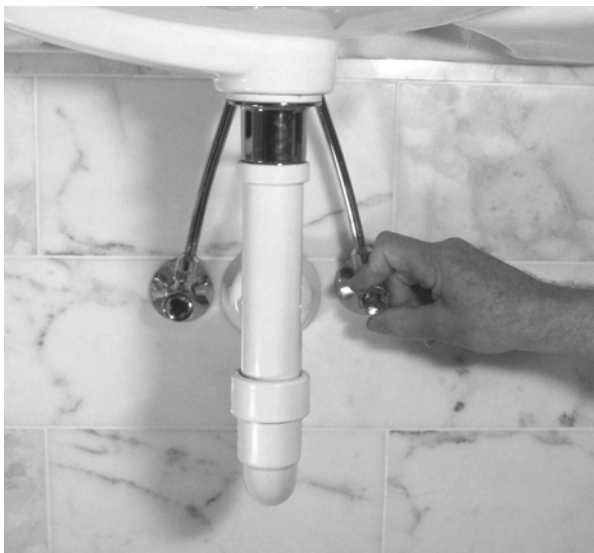
Abb. 8: Absperr-Eckventile unter einem Waschbecken
