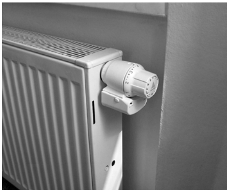
Abb. 30: Ausführungsbeispiel eines elektronischen Thermostates von Danfoss – Thermostat montiert
