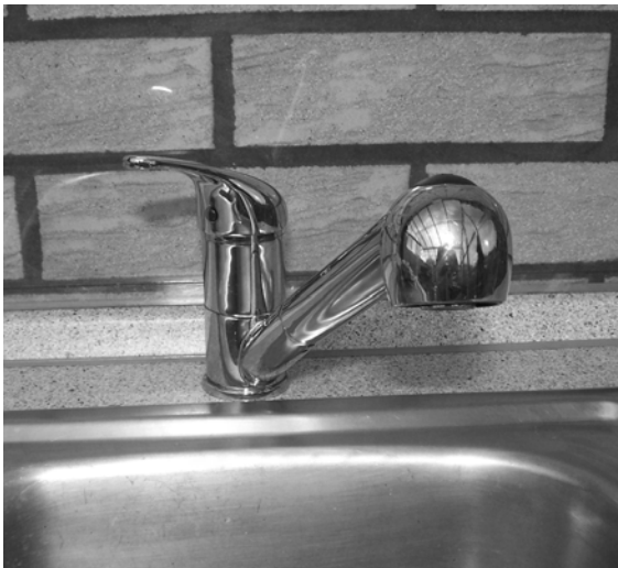
Abb. 17: Einhand-Mischbatterien haben anstelle von Gummidichtungen sogenannte „Kartuschen“, die gleichzeitig zwei Funktionen erfüllen: das Öffnen/Schließen und das wunschgerechte Mischen des kalten und warmen Wassers.
