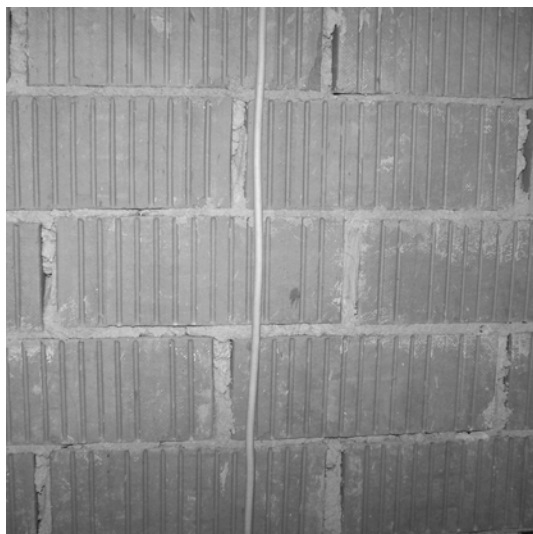
Abb. 77: Senkrechte Leitungen mit dem NYM-J-Installationskabel können leider nur teilweise in die waagrechten Fugen des Mauerwerks verlegt werden, da bei einer fachlich erstellten Mauer die senkrechten Fugen (Stoßfugen) der Ziegel versetzt sein müssen.
