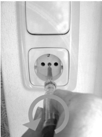
Abb. 61: Wenn sich eine Steckdose den Rahmen mit einem Lichtschalter teilt, wird erst die Schraube der Steckdosenabdeckung gelöst (wie abgebildet) und anschließend muss der Rahmen samt der Lichtschalterwippe(n) abgenommen werden.
