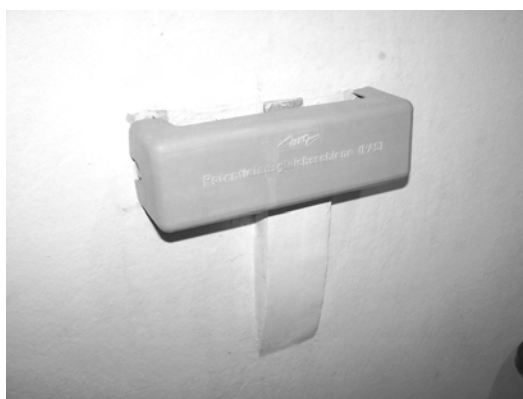
Abb. 97: Abgedeckte Potential-Ausgleichsschiene
