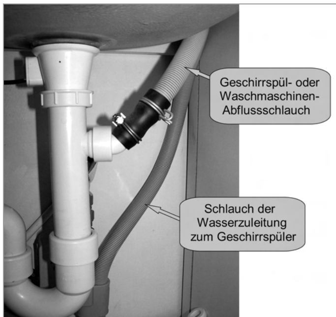
Abb. 60: Die meisten Spülbecken-Abflussrohre sind bereits mit einem Zweitanschluss für die Geschirrspül- oder Waschmaschine versehen (wird er nicht benutzt, ist er mit einer Dichtungsscheibe verschlossen).
