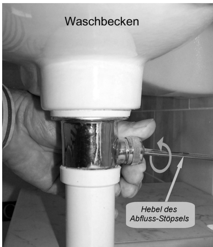
Abb. 33: Durch Zudrehen der Überwurfmutter unter der Waschschiüssel kann der Betätigungsknopf des Stöpsels fester eingeklemmt werden.
