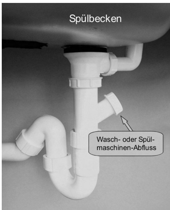
Abb. 61: Die Geschirrspül- oder Waschmaschine wird an den Zweitanschluss des Spülbecken-Abflussrohres mit einer Schlauchschelle angeschlossen.
