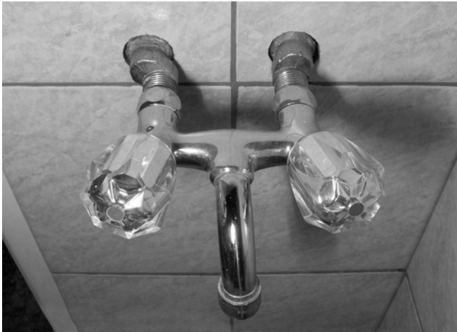
Abb. 39: Wand-Mischbatterien werden an Wasserzuleitungen angeschlossen, die in der Wand installiert sind und üblicherweise über keine eigenen Absperrventile verfügen.
