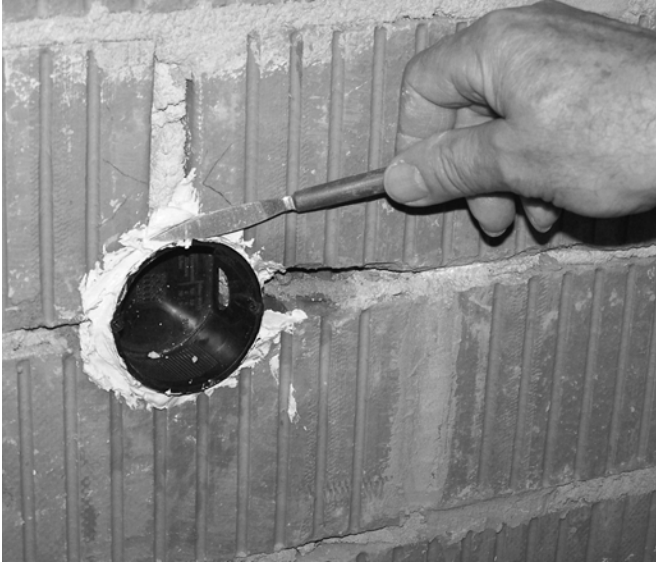
Abb. 147: Um Geräte- und Abzweigdosen wird der Putz mit leinen Spachteln hineingedrückt.
