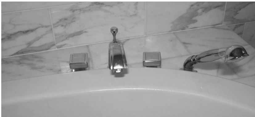
Abb. 55a: Eine Wannenfüll- und Brause-Mischbatterie – Ansicht von oben
