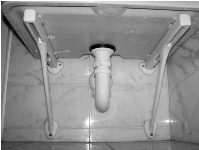
Abb. 95: Ansicht der Konsole des Waschbeckens aus Abb. 94 von unten
