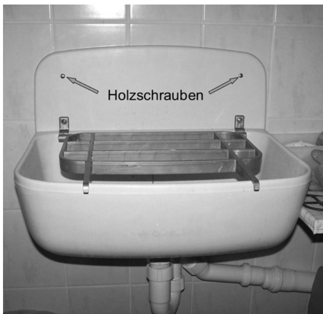
Abb. 93: Kunststoff-Waschbecken werden oft mit kleineren Holzschrauben (plus Dübel) an der Wand befestigt.
