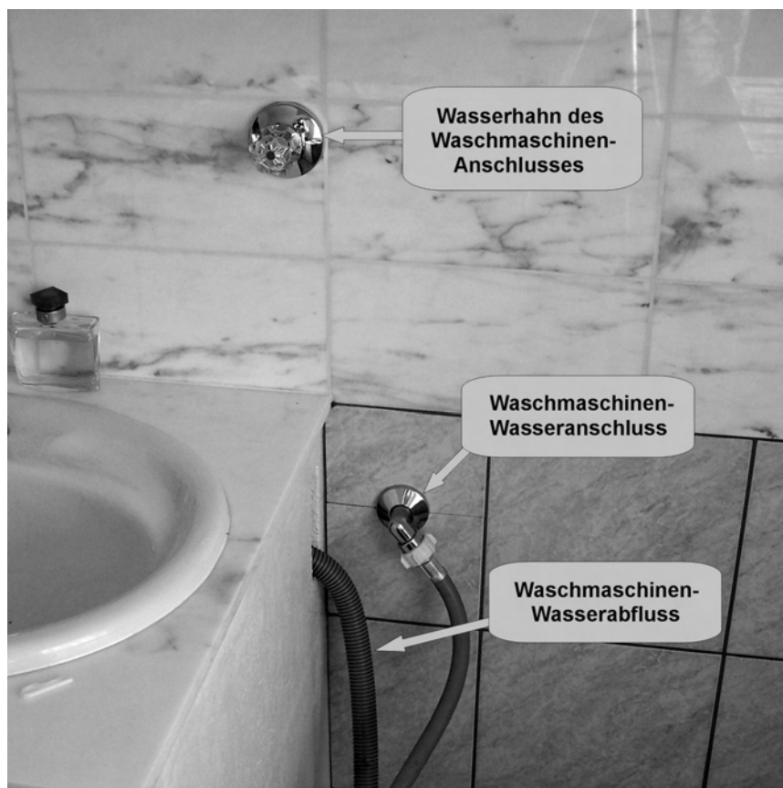
Abb. 86: Beispiel eines abschließbaren Waschmaschinen-Wasser-Anschlusses
