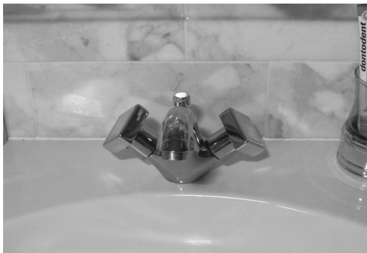
Abb. 14: Ausführungsbeispiel einer Spülbecken-Mischbatterie mit Keramikdichtungen
