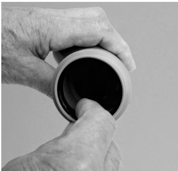
Abb. 98: Auf den dichtenden Gummi-Ring der Kunststoffrohr-Verbindung wird vor der Montage Schmierseife aufgetragen.
