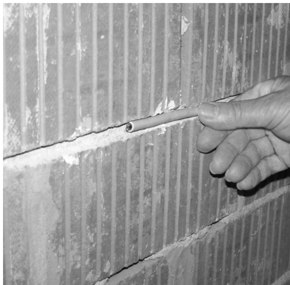
Abb. 76: Runde NYM-J-Installationskabel lassen sich sehr einfach in den waagrechten Fugen zwischen den Ziegelreihen verlegen.
