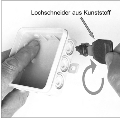
Abb. 36: Zu solchen Feuchtraum-Abzweigkästen sind (oft kostenlos) kleine Kunststoff-Lochschneider erhältlich, mit denen die passenden Löcher in den Dosenwänden für die Kabelanschlüsse eingeschnitten werden können (einige Handumdrehungen genügen, um in die vorgefertigten Öffnungen perfekt runde Löcher hineinzuschneiden).
