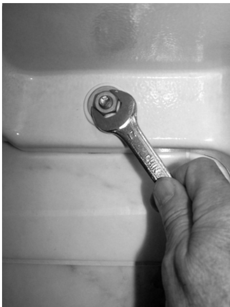
Abb. 92: Größere Waschtische werden oft mit Muttern auf Gewindestifte aufgeschraubt, die vorher in die Mauer eingeschraubt wurden.
