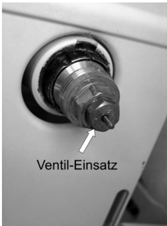
Abb. 28: m Heizkörper eingebautes Ventilgehäuse mit Ventil-Einsatz
