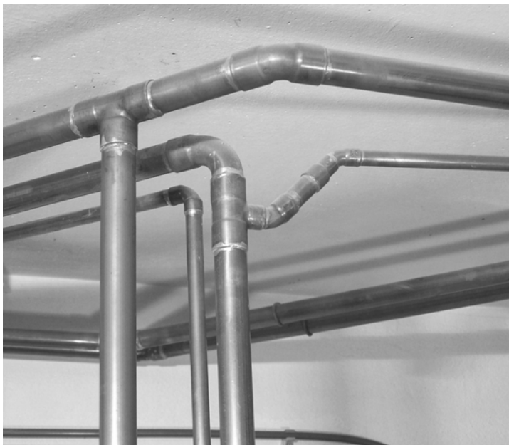
Abb. 58: Mit Hilfe von verschiedenen handelsüblichen Lötfittings können Kupferrohr-Leitungen zu eindrucksvollen „Kunstwerken“ verlötet werden.
