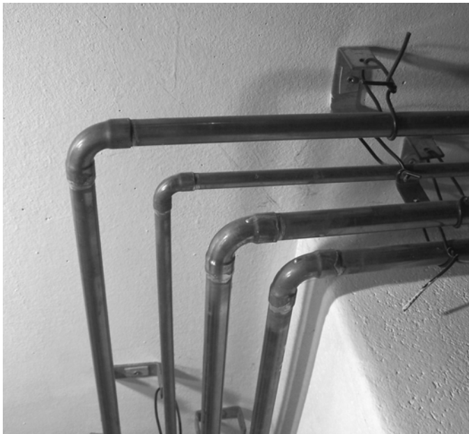
Abb. 59: Biegen der Kupferrohre erübrigt sich, denn kleine 90°- oder 45°-Kupfer-Bögen sind als Lötfittings in allen passenden Durchmessern erhältlich (Leitungsrohre sind noch provisorisch befestigt).
