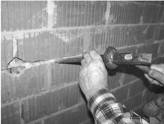
Abb. 70: Eine Ziegelwand besteht immer aus aufeinander gelegten und mit Mörtel verbundenen Ziegelreihen, in deren Fugen sich waagrechte Leitungen oft leicht mit einem Flachmeißel einstemmen lassen.
