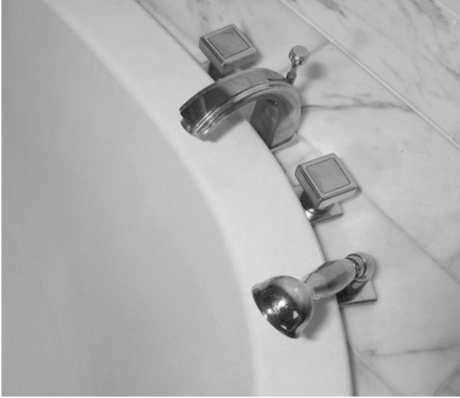
Abb. 16: Auch bei Badewannen sind Zweihand-Ventile mit Keramkdichtungen ähnlich ausgelegt wie bei Spülbecken oder Duschen.
