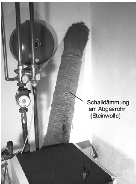
Abb. 24: Verkleidung des Abgasrohrs mit Dämmmaterialien
