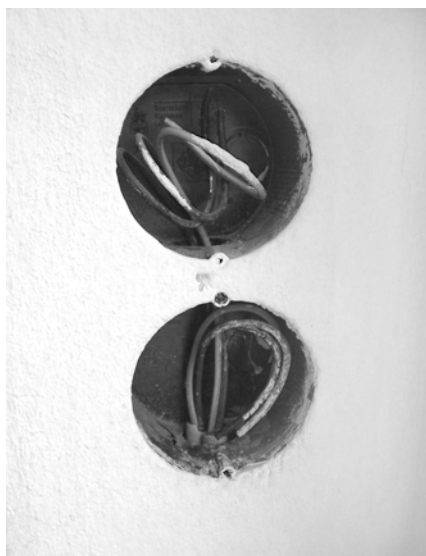
Abb. 83: Gerätedosen werden in der Wand so tief installiert, dass sie nach dem Verputzen nicht über den Putz herausragen, aber bevorzugt auch nicht viel tiefer als ca. 2 bis 3 mm wenn eine Tragplatten-Befestigung der Schalter- oder Steckdoseneinsätze vorgesehen ist.
