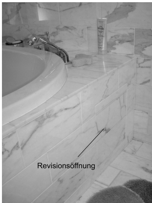
Abb. 104: Festgehalten wird diese Revisionsabdeckung von einem Möbel-Magneten.
