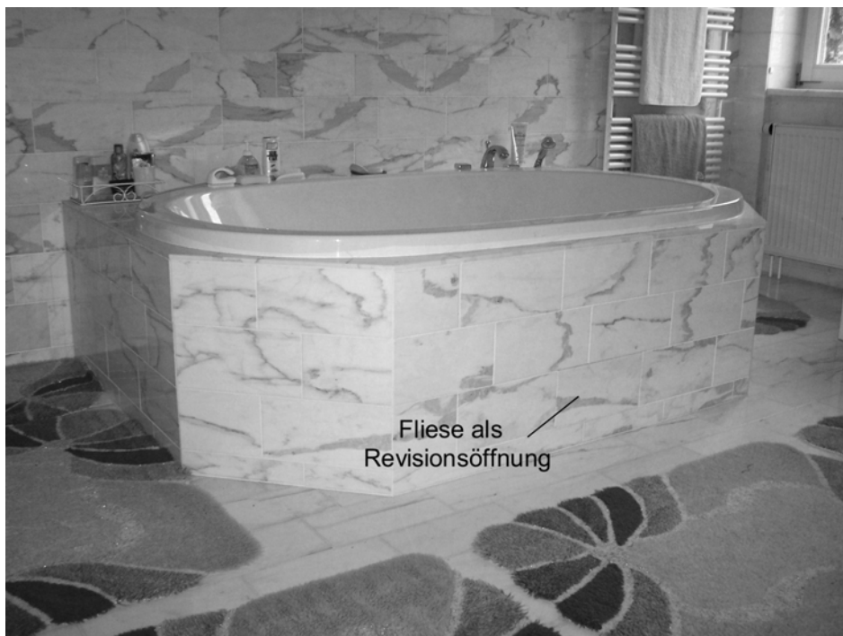
Abb. 101: Ausführungsbeispiel einer Wannenablauf-Revisionsöffnung, die im Selbstbau ohne einen zusätzlichen Rahmen erstellt wurde und in geschlossenem Zustand praktisch unsichtbar ist
