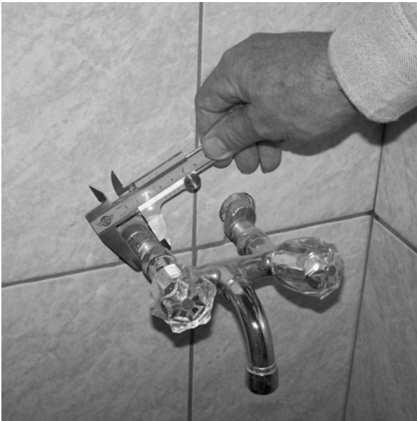
Abb. 42: Messen des Gewinde-Durchmessers eines „S-Anschlusses“
