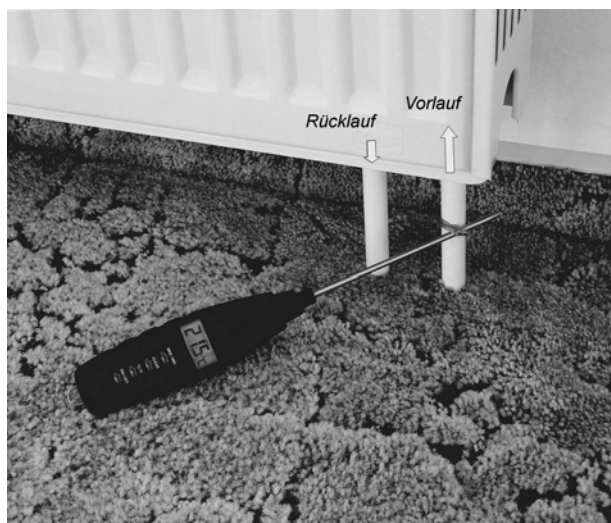
Abb. 26: Die Temperatur des Heizkörpers-Vorlaufs- und Rücklaufsrohr kann u. a. mit einem Küchen Bratthermometer gemessen werden.
