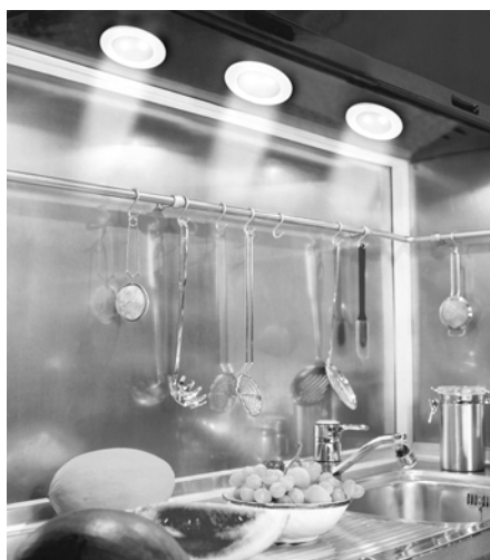
Abb. 28: Beleuchtung eines Küchenarbeitsplatzes mit Einbau-LED-Leuchten
