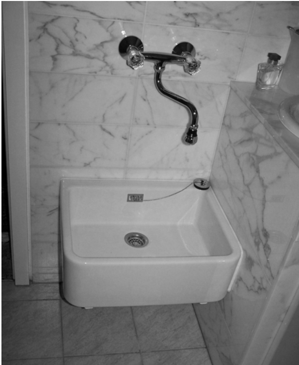
Abb. 94: Speziellere Porzellan-Ausgussbecken werden meist nur auf Konsolen aufgesetzt.
