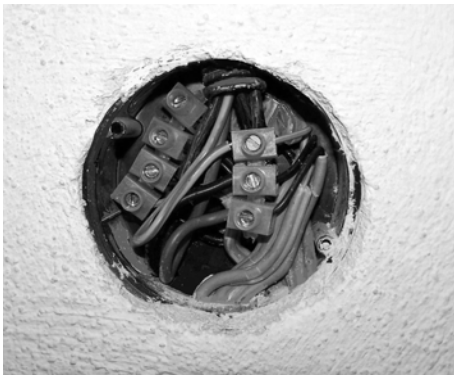
Abb. 129: Bei mehreren Leiterklemmen in einer Abzweigdose müssen diese ausreichend weit auseinander angeordnet sein, um keinen Kurzschluss zu verursachen.
