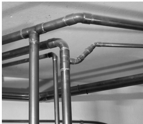
Abb. 74: Gelötete Kupferrohr-Verbindungen
