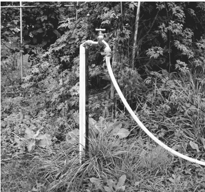
Abb. 85: Eine längere Wasserleitung zu einem Gartenwasserhahn darf beliebig „untief“ angelegt werden, denn das Wasser wird vor der Frostperiode ohnehin aus der Leitung abgelassen.
