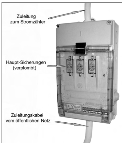
Abb. 94: Hausanschlusskasten mit Sicherungen
