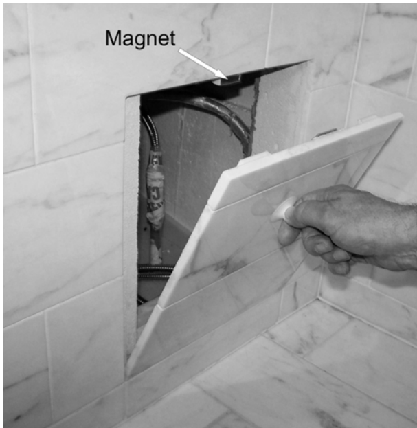
Abb. 102: Eine größere Revisionsöffnung für Wasseranschlüsse befindet sich auf der Rückseite der Wanne und die Abdeckung wurde ebenfalls ohne einen optisch störenden Rahmen erstellt.
