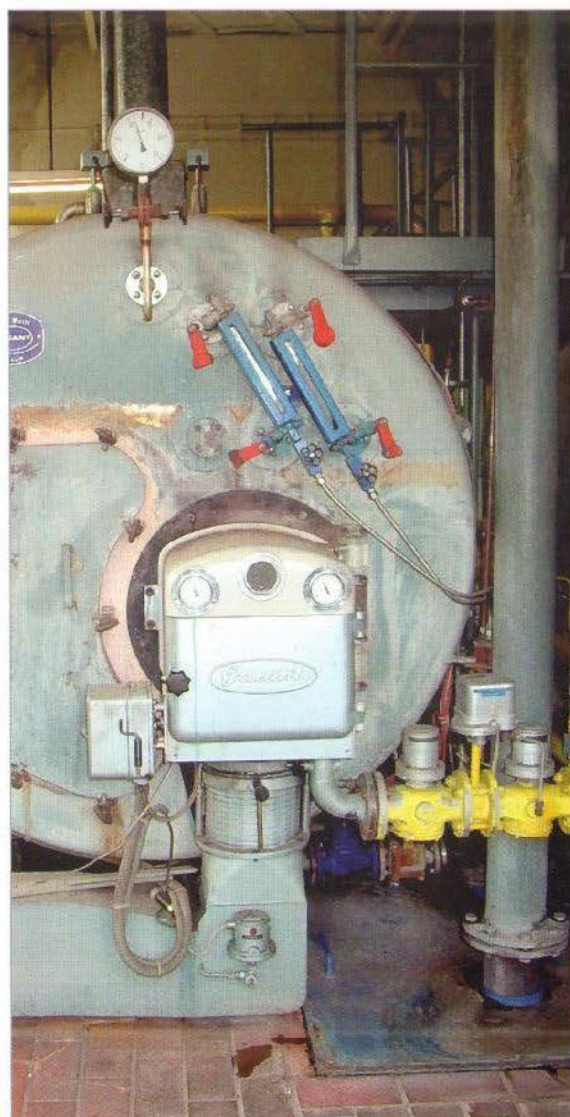
Zwei dieser Dampfkessel versorgen die Maschinen des Presswerkes mit Energie
