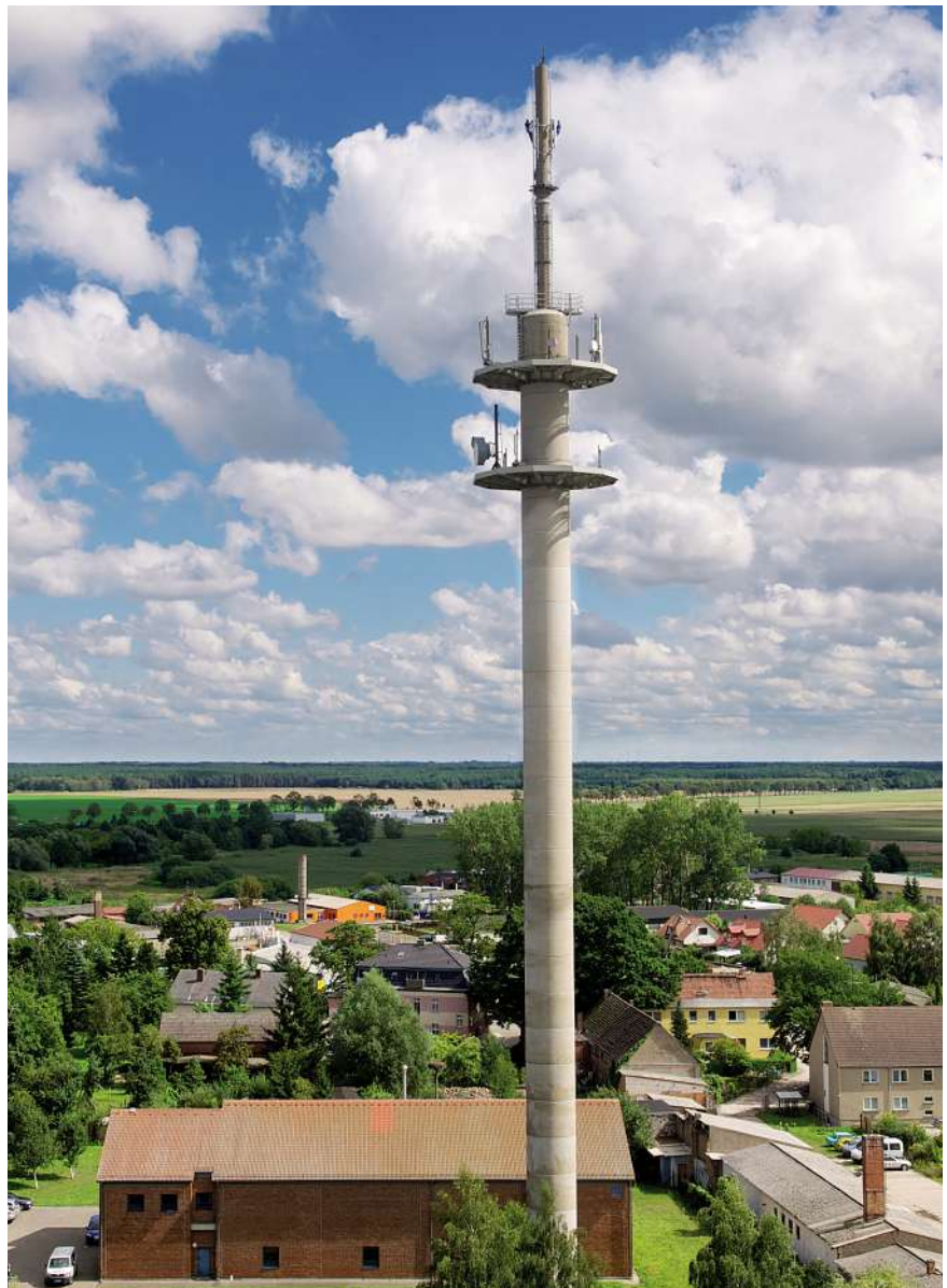
LTE auf dem Land: Eine Basisstation im 800-MHz-Betrieb kann einen 10-Kilometer-Radius mit mobilem Internet versorgen.
