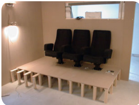
8 Nehmen Sie Platz: Die ersten drei Kinosessel sind bereits perfekt ausgerichtet und fest mit dem Podest verschraubt.
