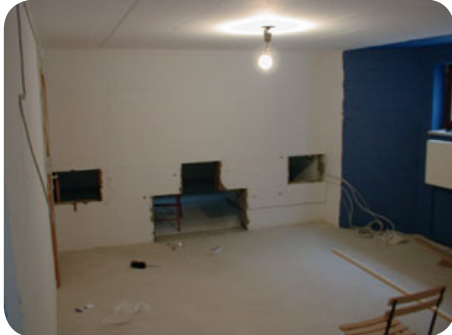
1 Platz schaffen: Um die Frontlautsprecher in der Wand unterkommen zu lassen, mussten zuerst Löcher gefräst werden.
