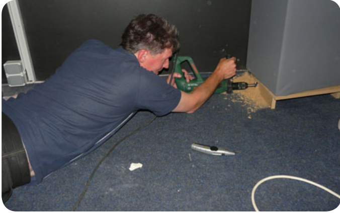
9 Die Optik muss stimmen, daher liegen alle Signalkabel für Bild und Ton versteckt unter den Absorbieren und Diffusoren. Passend gebohrte Löcher in den Sockeln der Absorber machen dies möglich.
