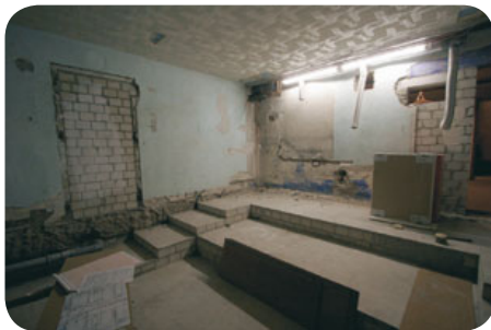
1 Aller Anfang ist schwer: Als der Pool endlich vollständig aus dem Keller entfernt war, ging es an den Bau der gemauerten Stufen, die künftig rechts und links neben den Sitzreihen hinabführen sollen.
