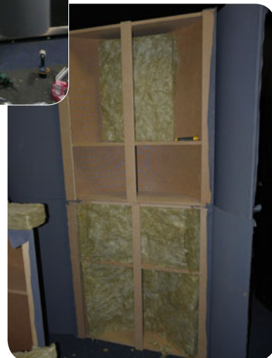
5 Für eine diffuse Schallverteilung im Raum müssen „schiefe“ Wände her oder sogenannte Polys. Diese halbkreisförmigen Elemente zerstreuen aufgrund ihrer Form Mittel- und Hochtonanteile auf horizontaler Ebene. Stehende Wellen und Flatterechos werden somit effektiv reduziert.
