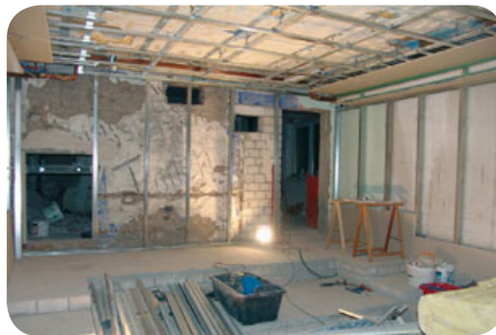
2 Der nächste Schritt war die Trockenbau-Installation. Nachdem das Grundgerüst stand, konnten bereits alle Lautsprecher- und Stromkabel ordnungsgemäß verlegt werden.
