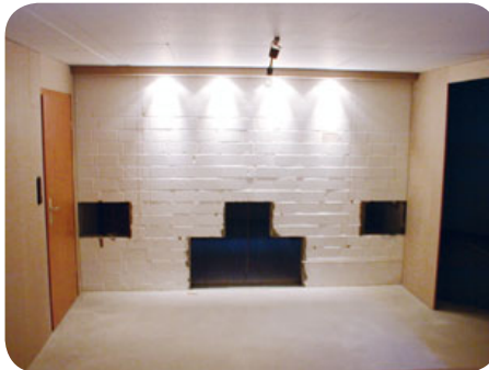
5 Es werde Licht: Insgesamt vier Halogenstrahler kommen in der eigens dafür hergestellten Abkoferung zum Einsatz und beleuchten die Leinwand.
