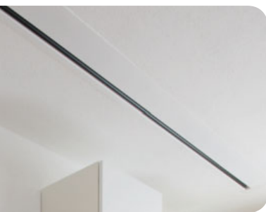
Millimeterarbeit: Im Off-Betrieb verschwindet die Leinwand bündig in der Zimmerdecke
