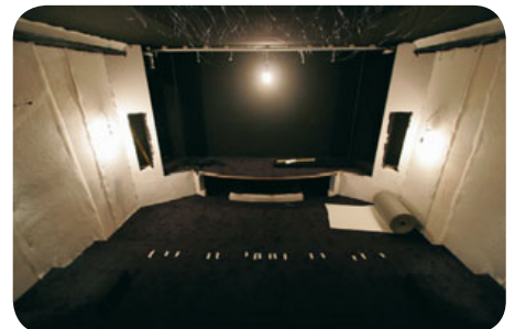
6 Es wird was: Alle Wände sind verputzt und der schwarze Teppich verlegt. Am oberen Bildrand sind die Glasfaserkabel des 3,70 x 2,00 Meter großen Sternenhimmels zu sehen.
