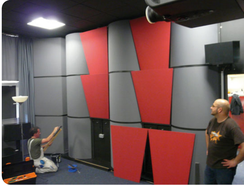
13 Die roten, trapezförmigen Elemente zwischen allen „Polys“ bestehen aus MDF-Platten und dienen der Zerstreuung der Schallanteile in vertikaler Ebene. Daher sind diese Elemente in einem leicht geneigten Winkel angebracht und machen so aus den glatten Wänden eine diffuse Oberfläche. Bringt viel akustischen Effekt und sieht dazu gut aus.
