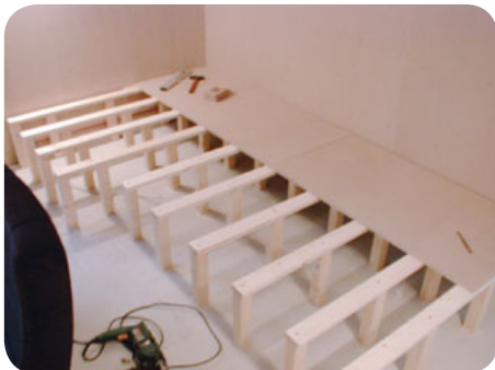
7 Bombenfest: Eine massive Rahmen-/Bügelkonstruktion sorgt für ein extrem stabiles Sitzpodest. Auch dieses ist mit Pressspanplatten verkleidet.
