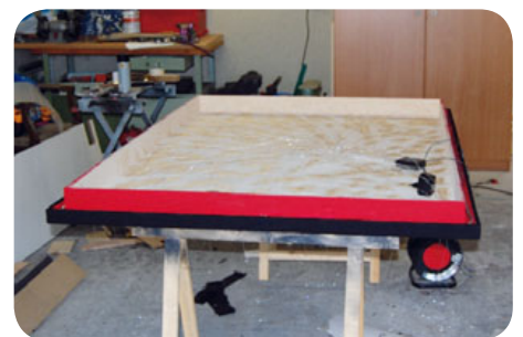
3 Fertig: Nachdem der Kleber angetrocknet ist, muss die rund zehn Kilogramm schwere Konstruktion nur noch unter die Decke gebracht werden.
