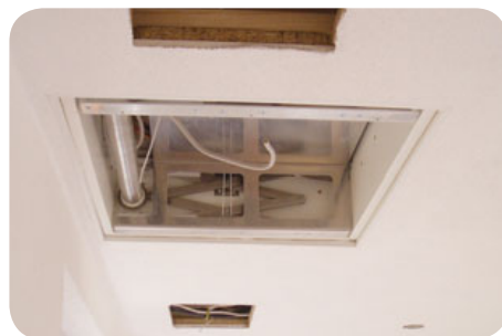
3 Inzwischen sind auch keine Stoßkanten mehr sichtbar, denn die gesamte Fläche ist verspachtelt, geschliffen und gestrichen. Jetzt müssen die Lautsprecher nur noch eingesetzt werden.
