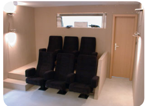
9 Das komplette Podest nebst Treppenaufgang und Geländer (rechts) ist inzwischen komplett fertiggestellt. Die vordere Sitzreihe ist fest im Estrich verschraubt.
