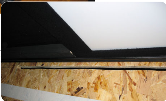
2 Der Schlitz in der Leinwandbühne erleichtert das Führen der Maskierung, die durch den unterhalb der Bühne befindlichen Motor angetrieben wird.
