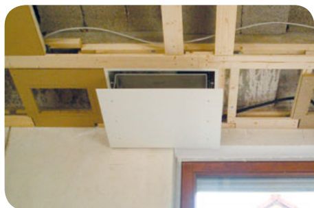
1 Die massive Grundverlattung dient als Träger der gesamten Deckenkonstruktion. Hier sind auch schon die Holzträger jedes Einbaulautsprechers eingesetzt.
