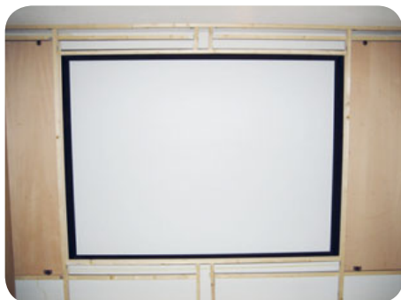
1 Der Rahmen für die Stirnwand steht. Die zwei großen Holzbretter werden auf Schienen geführt und verdecken später die Leinwand.
