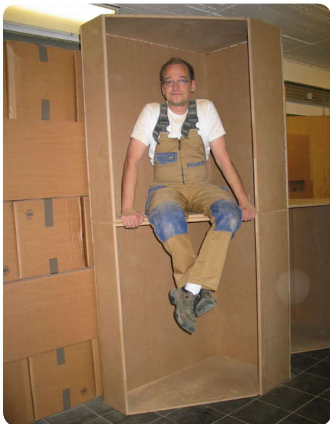
3 Für effektive Reduzierung der Nachhallzeiten im Bassbereich lässt sich die Physik nicht austricksen, Schaumstoff funktioniert da nicht: Insgesamt 12 dieser gigantischen Absorber mussten gebaut werden (im Bild: HEIMKINO-Redakteur Michael Voigt), die später noch mit Schwerfolien zu Membranabsorbern ausgebaut wurden.
