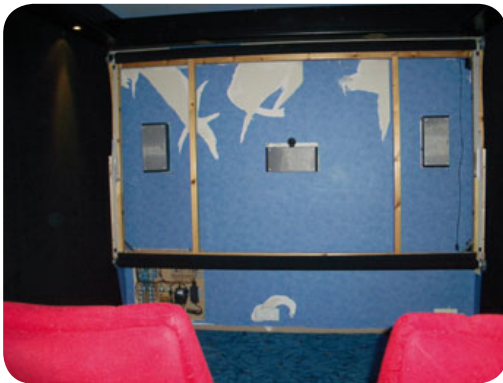
Die Basis besteht aus einer einfachen Balkenkonstruktion, welche ihren Platz direkt vor den an der Stirnwand montierten Frontlautsprechern findet
