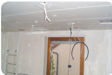
2 Mittlerweile sind sämtliche Leitungen verlegt und die Decke verschlossen. Hier entschied sich Heiko V. für den Einsatz von Rigipsplatten, die ein geringes Eigengewicht haben und sich leicht verarbeiten lassen.
