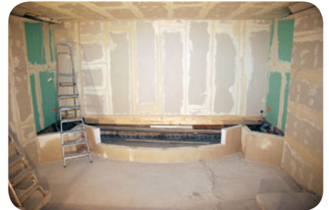
3 Sieht schon besser aus: Mittlerweile ist der Trockenbau fast abgeschlossen. Der komplette Kellerraum ist mit Rigipsplatten ausgekleidet. Selbst ein Teil der Bühne ist bereits gemauert.
