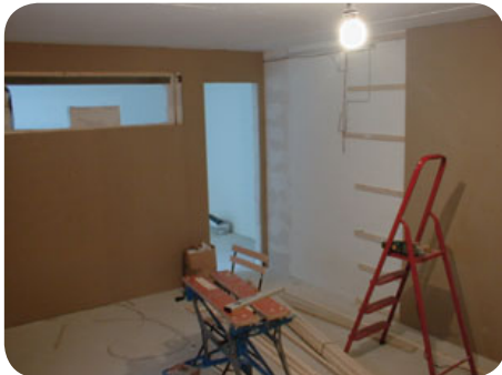
4 Innenausbau: Die gesamte Konstruktion wurde am Computer geplant. Alle Pressspanplatten sind an zuvor aufgetragenen Holzleisten befestigt.
