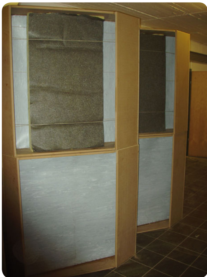
4 Mit einem extrem schweren Industrie-Fußbodenbelag aus PVC wurden gigantische Membranabsorber realisiert – die einzig effektive Methode, um tiefe Frequenzen wirkungsvoll zu unterdrücken. Ziemlich groß und schwer, aber es sollte ja perfekt werden.
