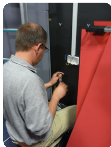
8 Ohne guten Strom geht nix: bei der Umbau-Aktion wurden sämtliche Stromleitungen neu verlegt. Direkter Anschluss per 3 x 2,5-qmm-Leitung am Hausanschlusskasten liefert optimale Stromversorgung. Alle Steckdosen sind als Aufputzversion mit Schraubklemmen (nicht per Clip geklemmt!) ausgelegt und bieten idealen Kontakt zur 230-Volt-Versorgung.
