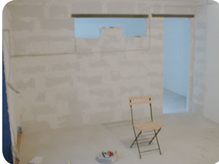
2 Inzwischen ist auch die Trennwand zum Gästezimmer entstanden. Schön zu sehen sind hier die Löcher für die Hush-Box und die Surround-Back-Lautsprecher.
