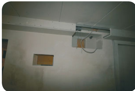
5 Clever: Wie im echten Kino verschwindet der Projektor komplett aus dem Sichtfeld. Er ist in der speziell dafür entworfenen Aussparung in der Zwischenwand untergebracht.
