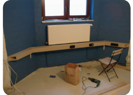
3 Kontrollnische: Alle Zuleitungen sind schon verlegt. Hier kommen später alle Zuspieler, wie DVD-Player, Computer und AV-Verstärker, unter.
