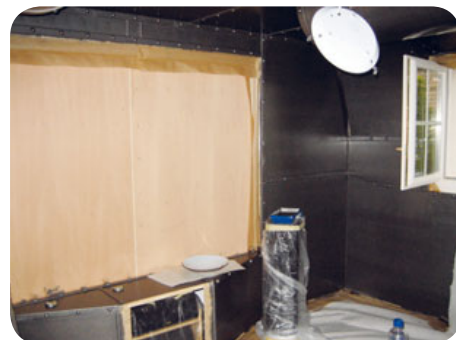
3 Mittlerweile ist das Kino dank des Hammerite-Lackes in die gewünschte Metalloptik gebracht worden. Die Leinwand wirkt noch wie ein Fremdkörper.
