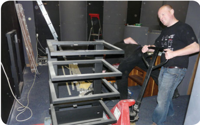
10 Sämtliche Elektronik wie Dekoder, Endstufen und Blu-ray-Player sollten vibrationsfrei in einem Rack an der Wand befestigt werden. Hat geklappt, nur das erforderliche Rack wog alleine schon leer um die 100 kg. Dafür ruhen alle Komponenten nun auf gedämpften Absorberplatten und spielen unter perfekten Bedingungen.
