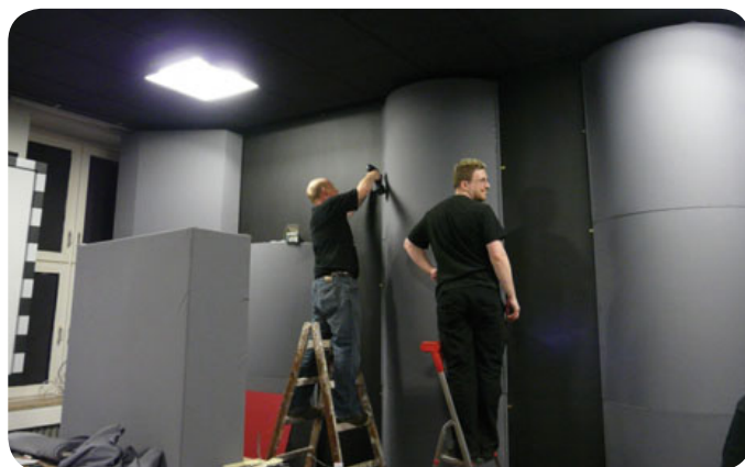
7 Sämtliche Absorber und Diffusoren wurden mit einem akustisch transparenten Stoff bezogen. Ideal wäre ein schwarzer Farbtton gewesen, um möglichst wenig Reflexionen während einer Projektion zu erhalten. Die Entscheidung fiel zugunsten des etwas „freundlicheren“ Mausgrau – ein guter Kompromiss zwischen Wohnlichkeit und optimaler Farbe.
