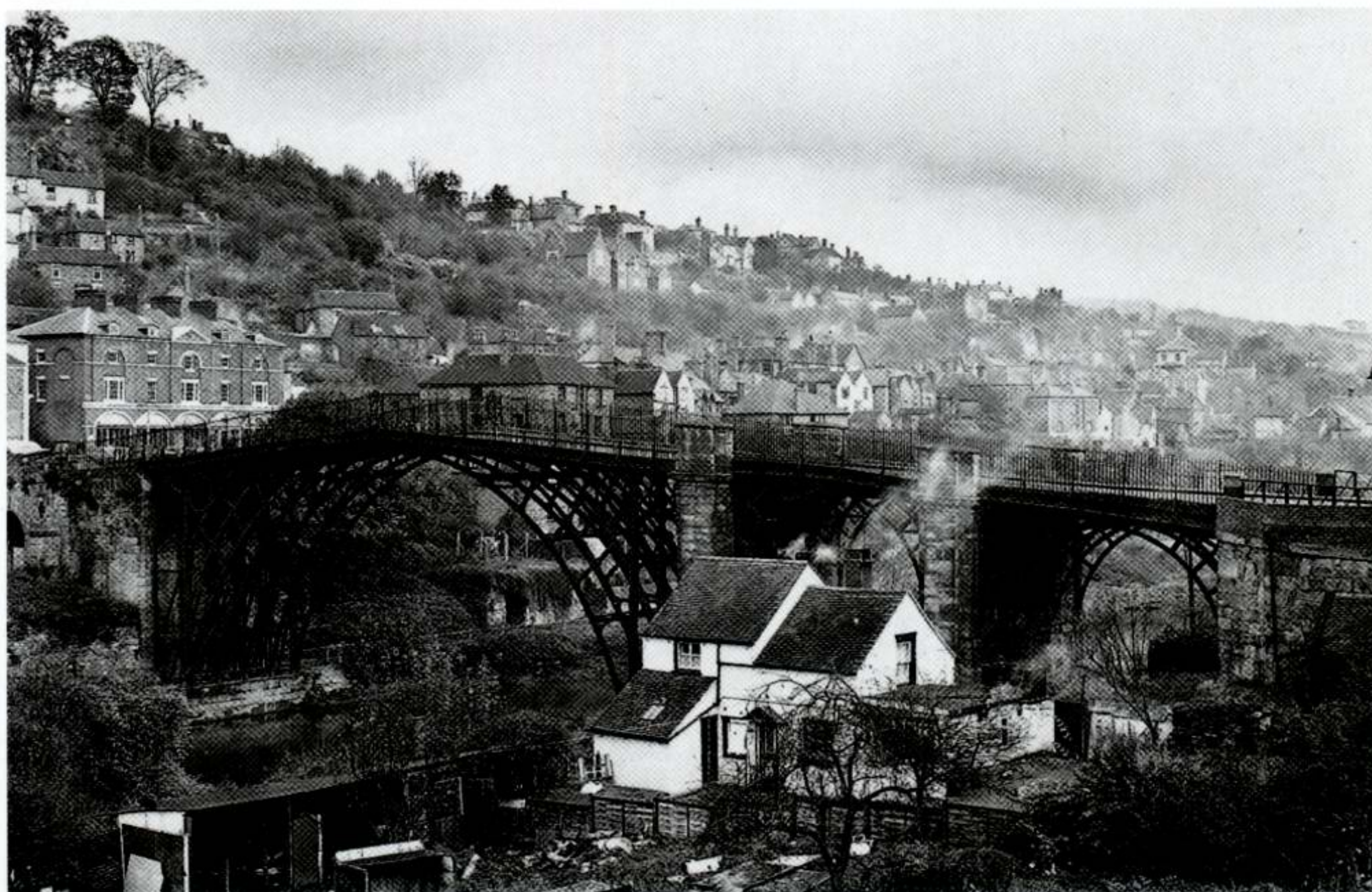
Die noch heute existierende Coalbrookdale-Brücke über den Severn in England war als erste aus Gußeisenteilen zusammengesetzt.
