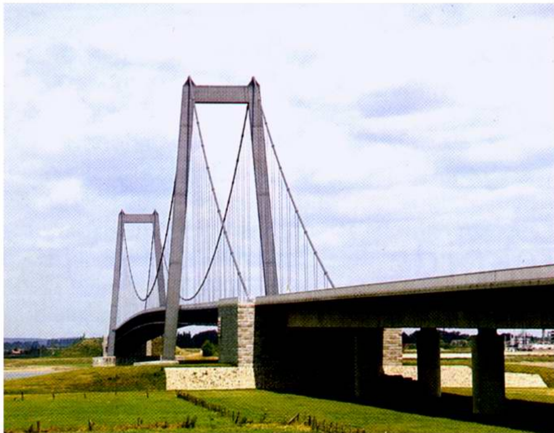
Die Rheinbrücke bei Emmerich, mit 500 Meter Spannweite die größte deutsche Hängebrücke.
