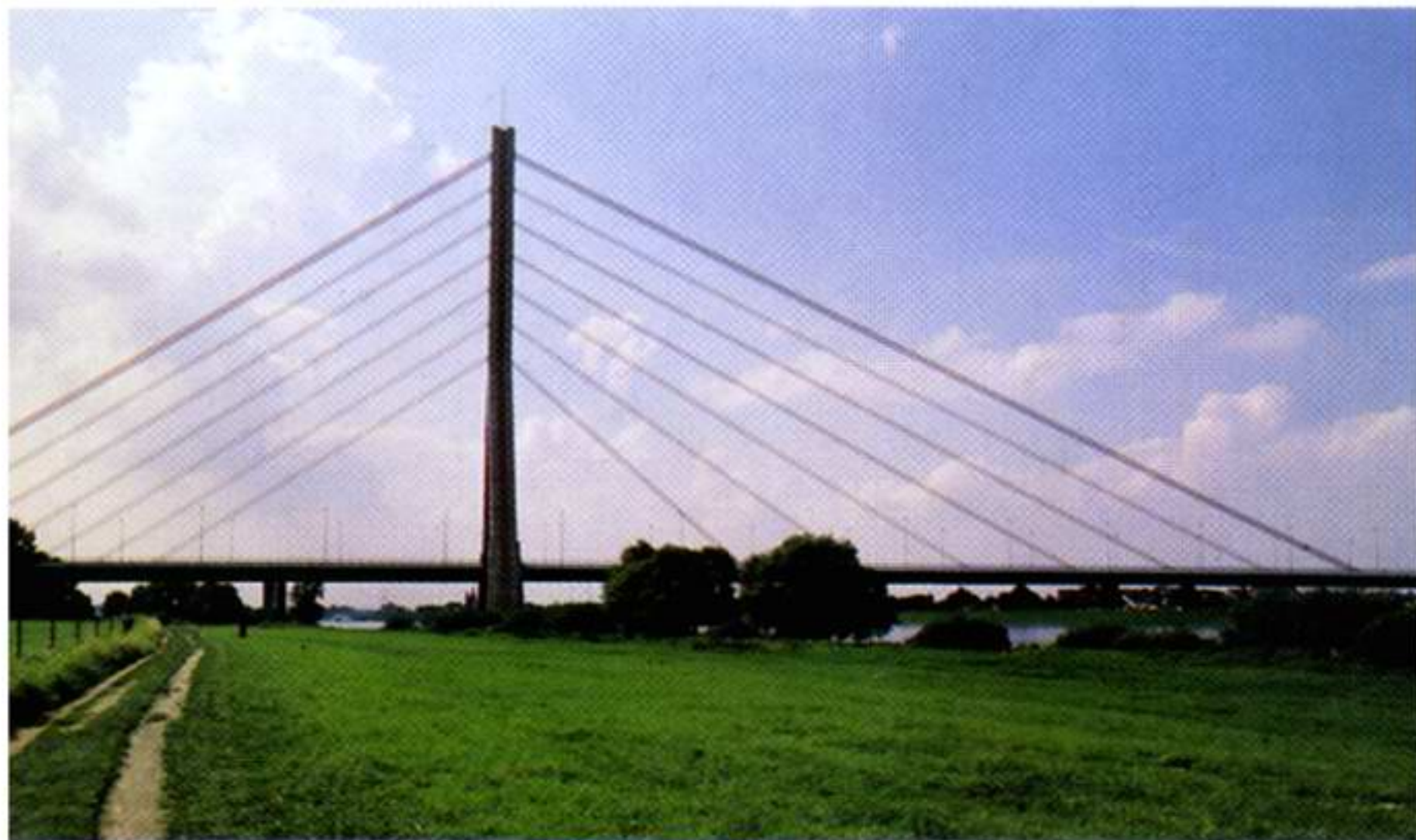
Die Autobahnbrücke bei Düsseldorf-Flehe. Sie ist mit 368 Meter Spannweite zur Zeit die größte deutsche Schrägkabelbrücke.
