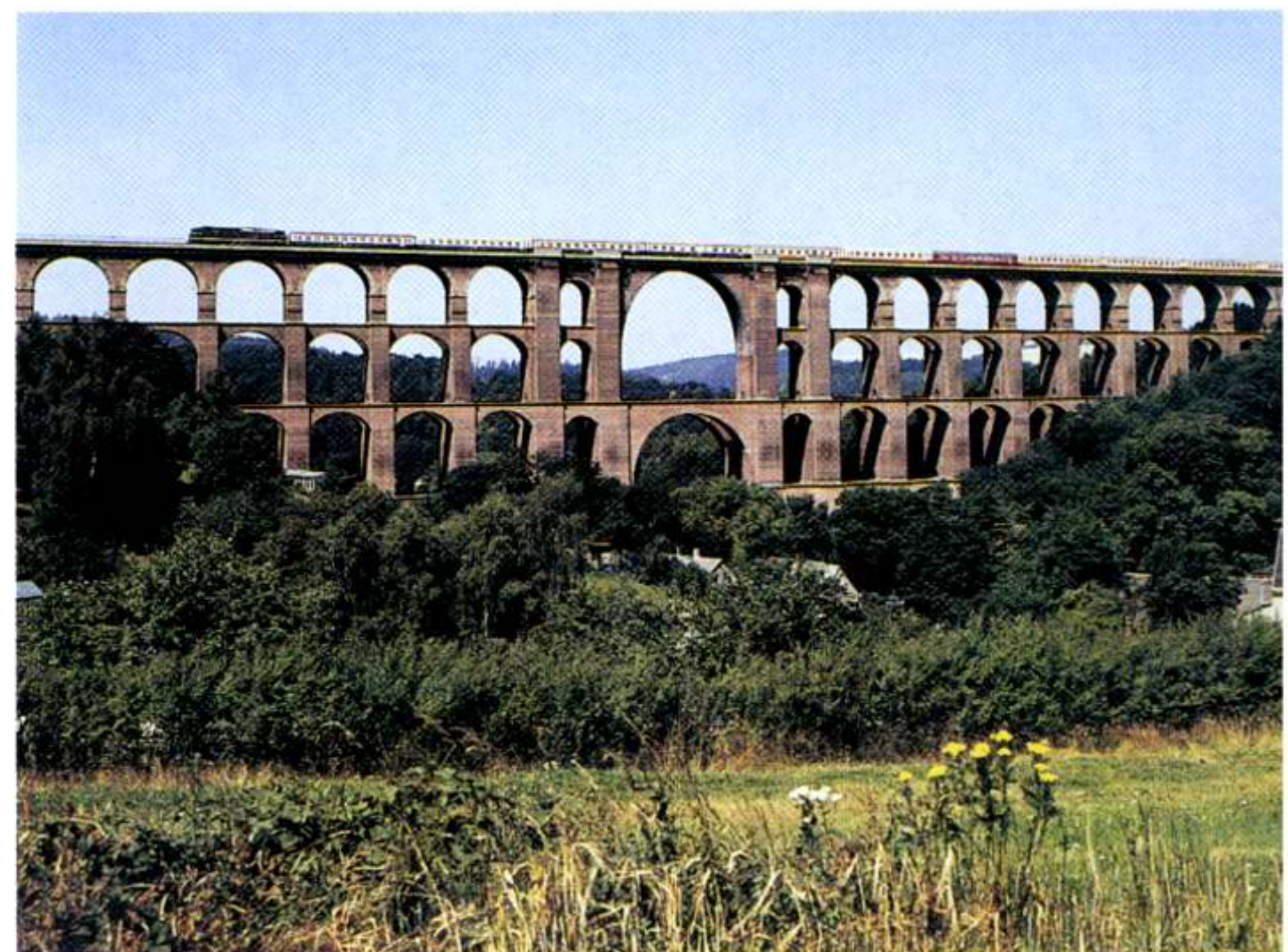
Der Göltzschtalviadukt bei Plauen in Sachsen ist aus Ziegelsteinen gemauert.
