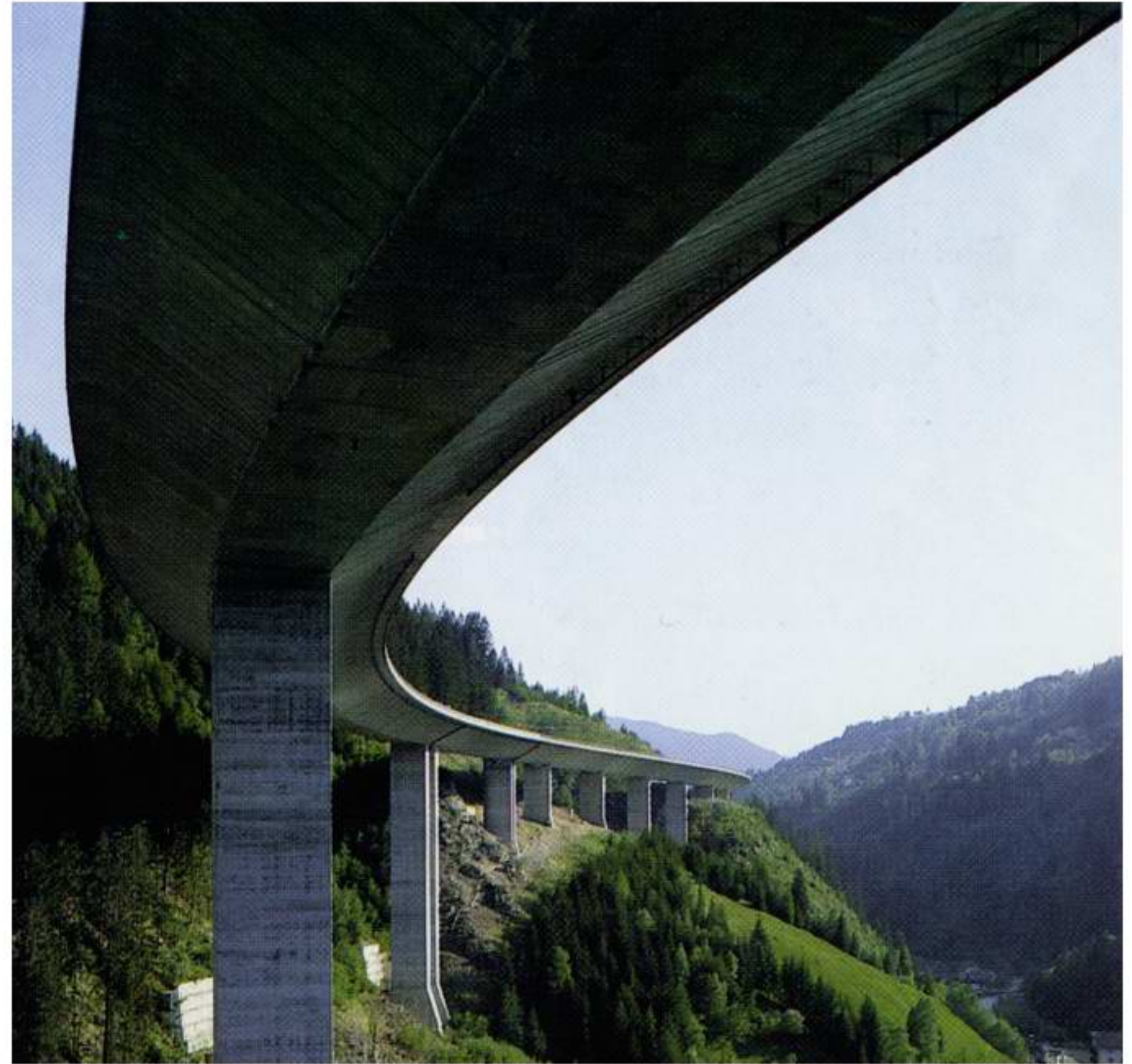
Spannbetonbrücke der Tauernautobahn über das Liesertal in Kärnten/Österreich.
