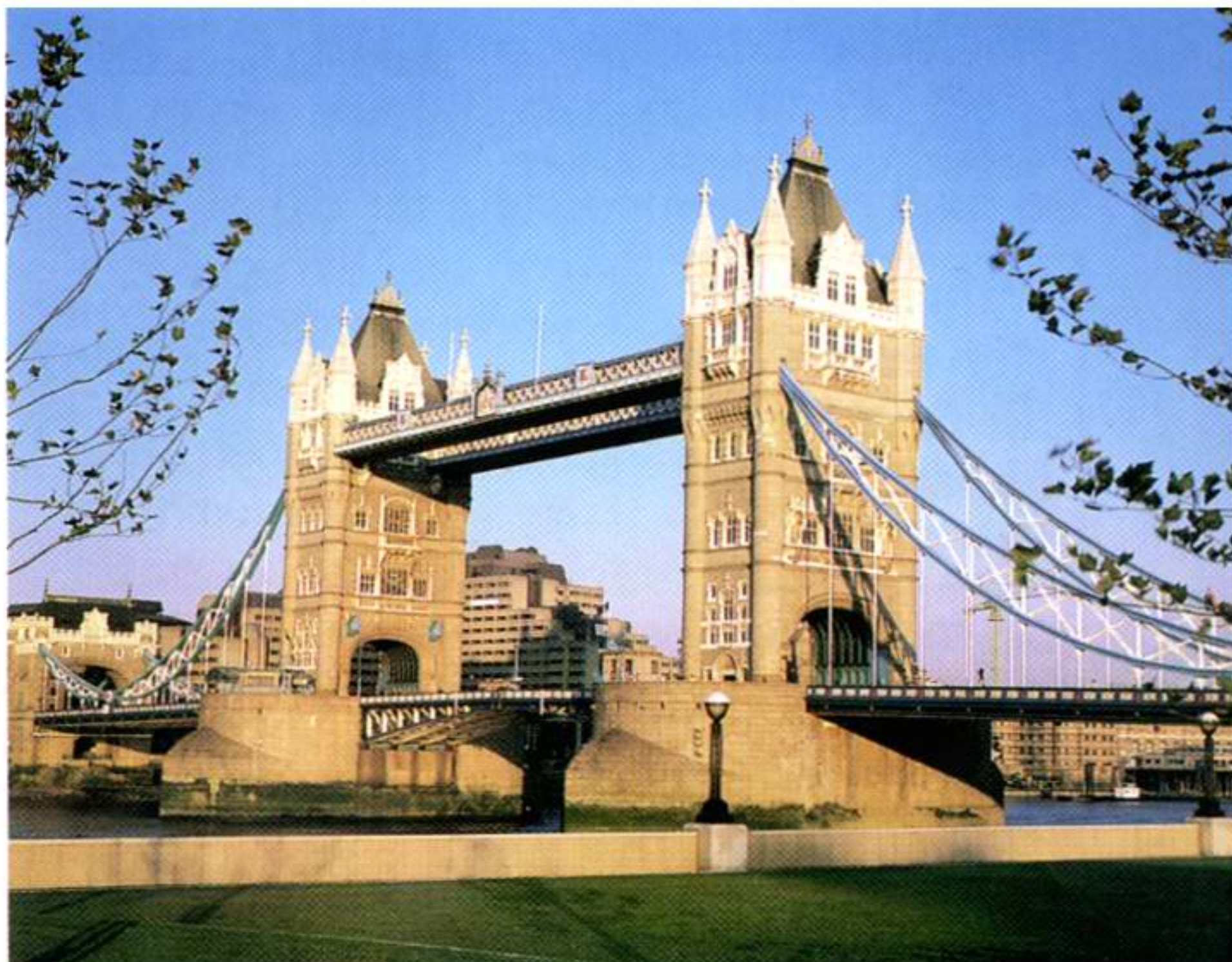
Die Towerbrücke in London. Die untere Fahrbahn kann hochgeklappt werden, oben läuft ein Fußgängersteig.
