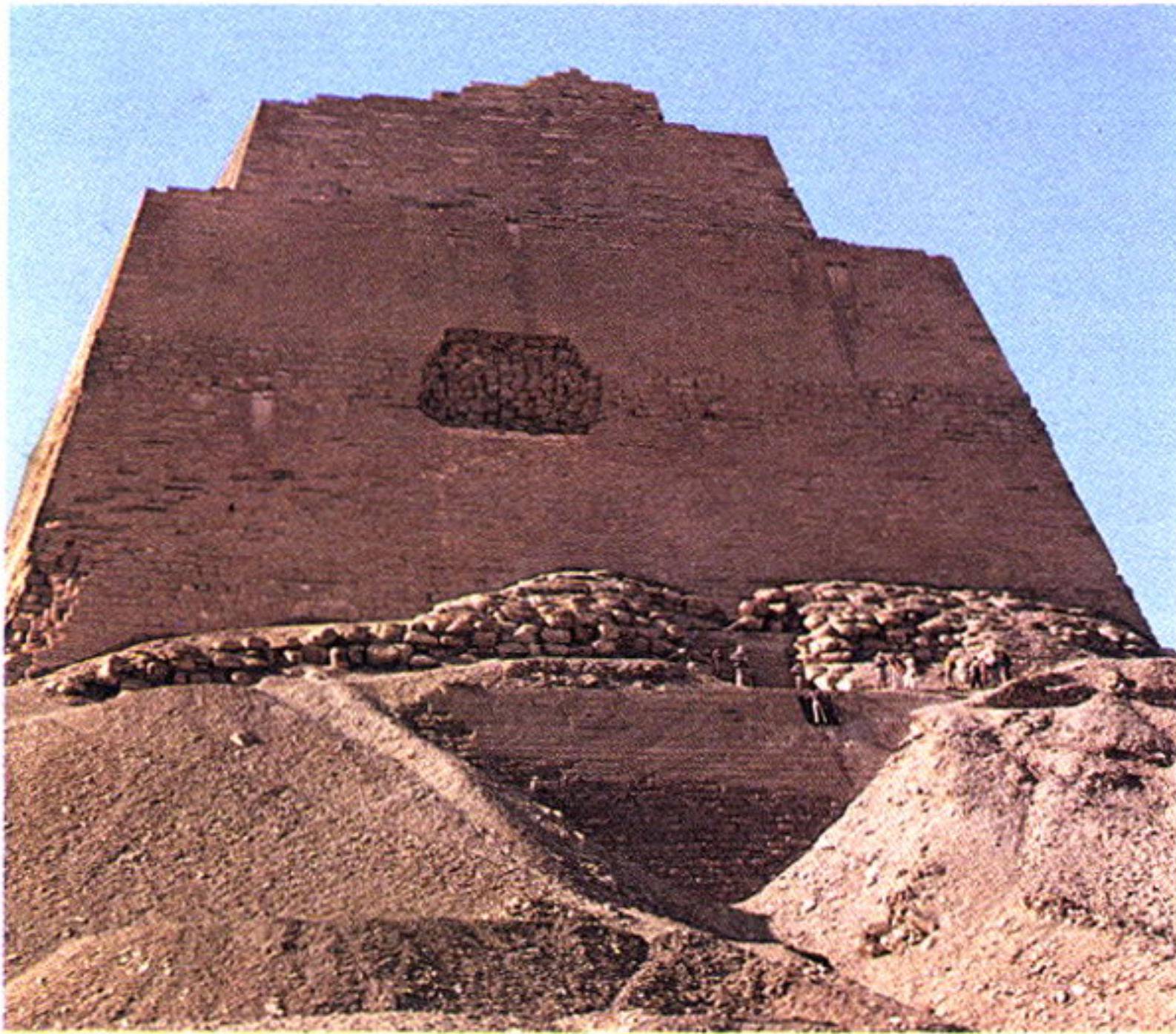
Weil sie zu steil war, stürzte die Pyramide bei Meidum halbfertig in sich zusammen.
