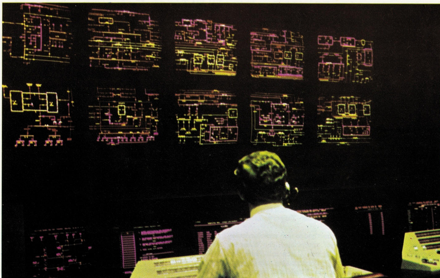
Unten: Ein Kontrollraum, in dem die Systemdaten an farbigen Katodenstrahlanzeigen wiedergegeben werden.
