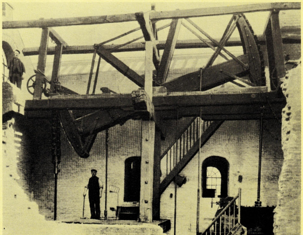
Oben: Watts doppelwirkende Dampfmaschine von 1786. Sie hatte Planetengetriebe und einen getrennten Kondensationsbehälter.
