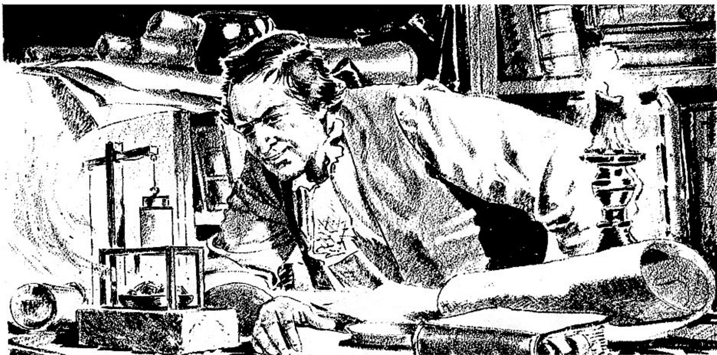
Mit diesem Maschinchen begann die technische Revolution: In der selbst gebastelten Dampfmaschine des Franzosen Denis Papin wurde zum erstenmal der Wasserdampf benutzt, um einen Kolben zu heben
