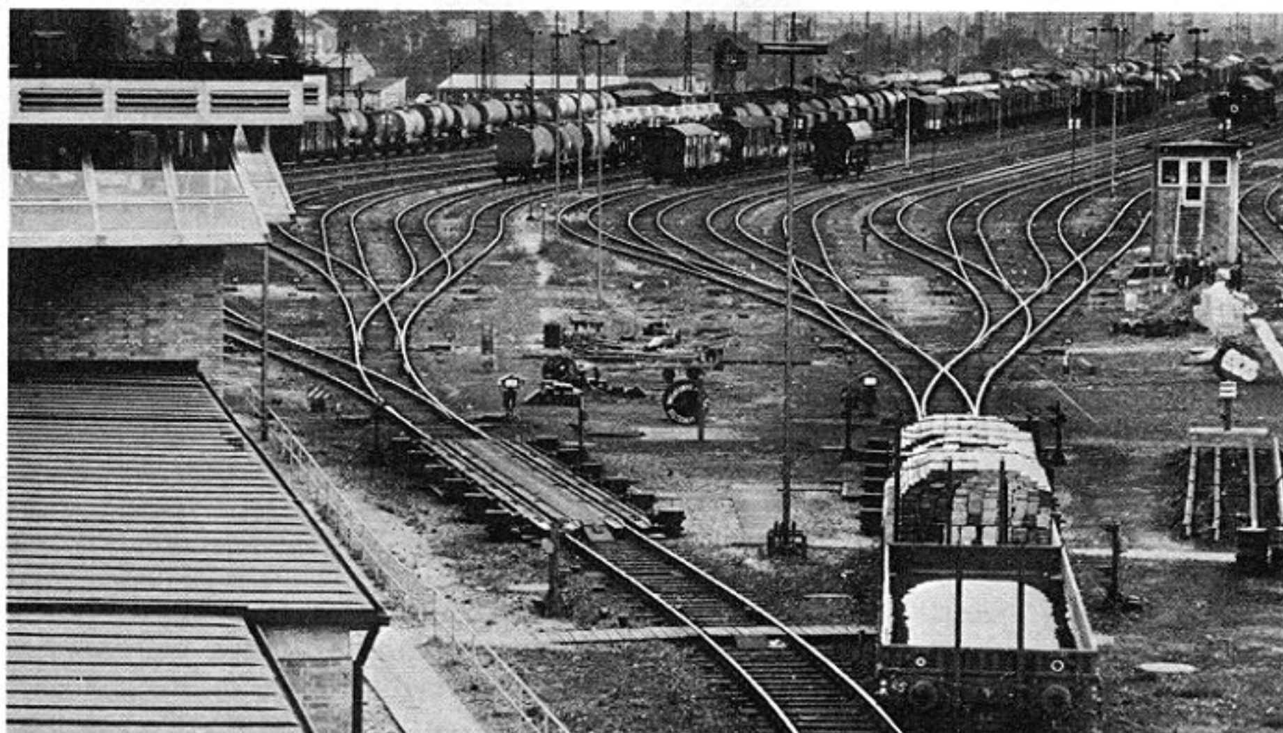
Auf großen Rangierbahnhöfen werden Güterzüge vor dem „Ablaufberg“ (Foto) auseinandergerissen und neu „sortiert“; d. h., der Schwerkraft folgend rollt jeder einzelne Wagen über viele Weichen auf das Gleis, auf dem ein neuer Güterzug mit entsprechendem Bestimmungsbahnhof zusammengestellt wird
