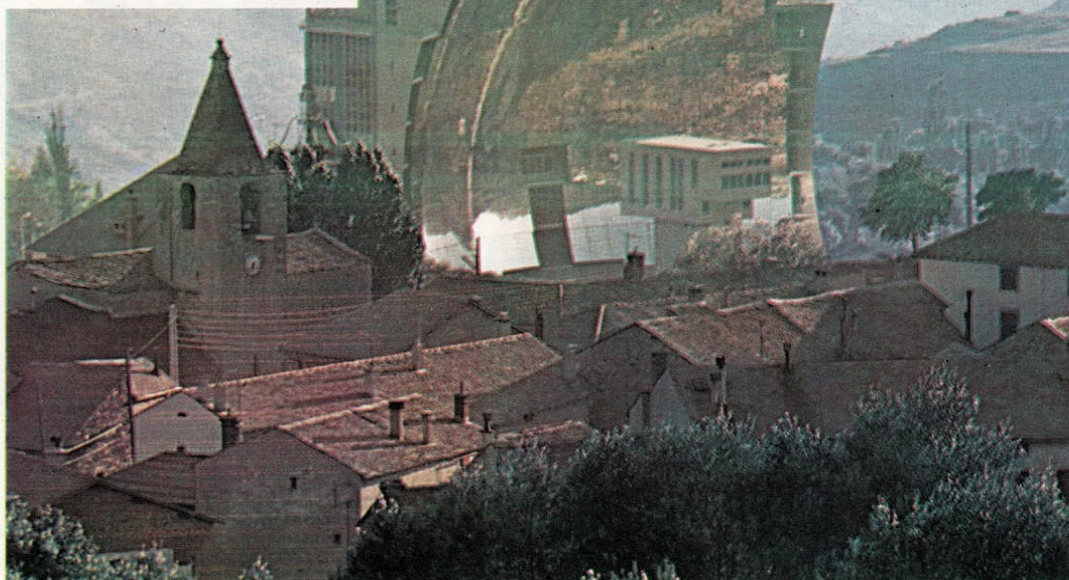
Oben und rechts: Zwei verschiedene Ansichten des Sonnenofens in Odeillo, Pyrenäen. Die im Bild rechts zu sehenden 9 000 Spiegel bilden einen nach Norden zeigenden Parabolspiegel, in dessen Brennpunkt sich der Schmelzofen befindet. (Nahaufnahme des Schmelzofens im Bild oben.) Auf dem gegenüberliegenden Berg (nicht abgebildet) befinden sich 11 000 Planspiegel, die die Sonnenstrahlen auf den Parabolspiegel reflektieren. In wenigen Minuten ist der Schmelzofen, der keine Umweltverschmutzung erzeugt, auf 3 300° C erhitzt.
