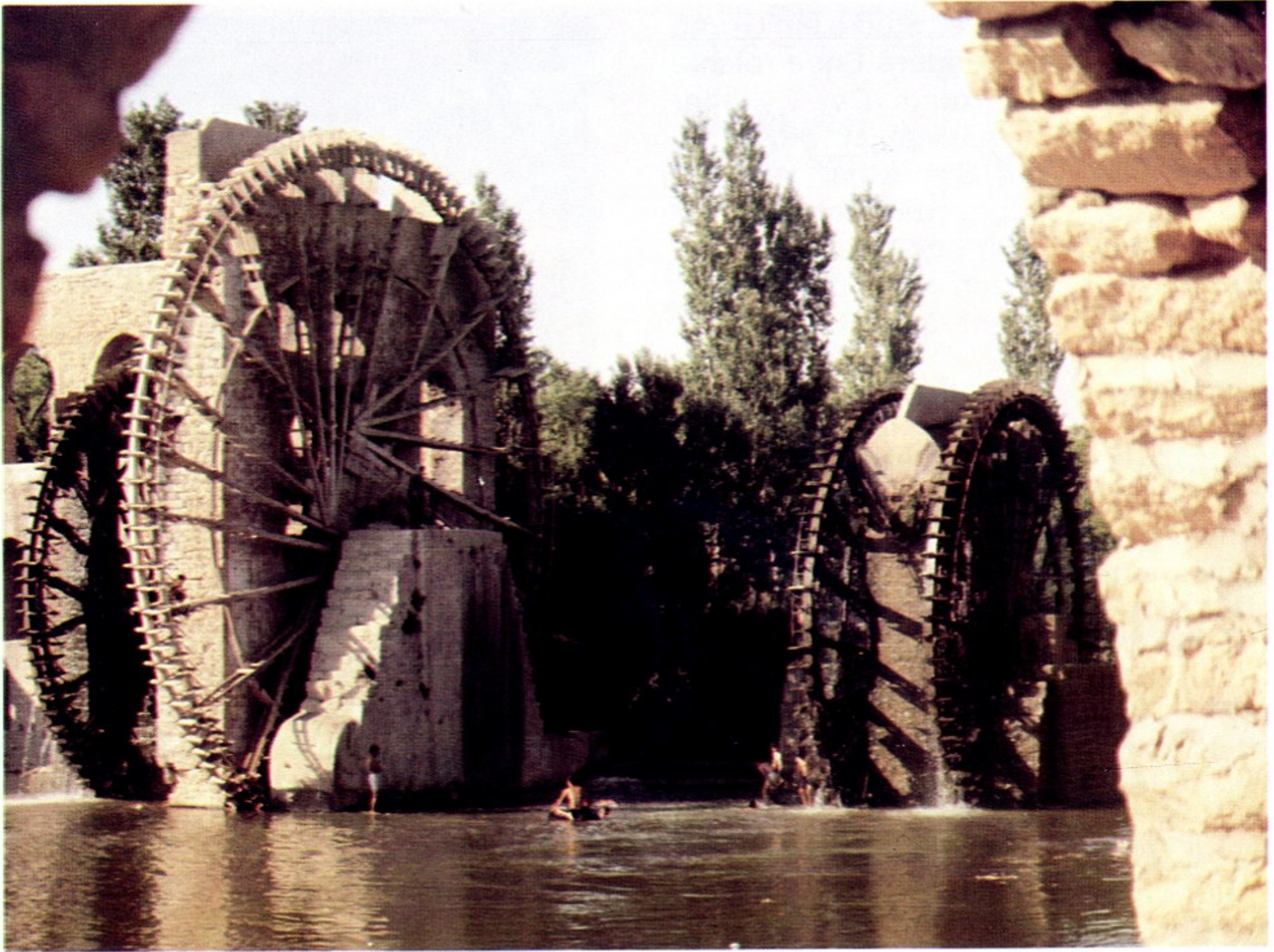
Hölzerne Schöpfräder bringen bei Hama (Syrien) das Wasser des Orontes über steinerne Aquädukte in die Stadt und auf die Felder. Dieses jahrhundertealte Bewässerungssystem funktioniert noch einwandfrei.
