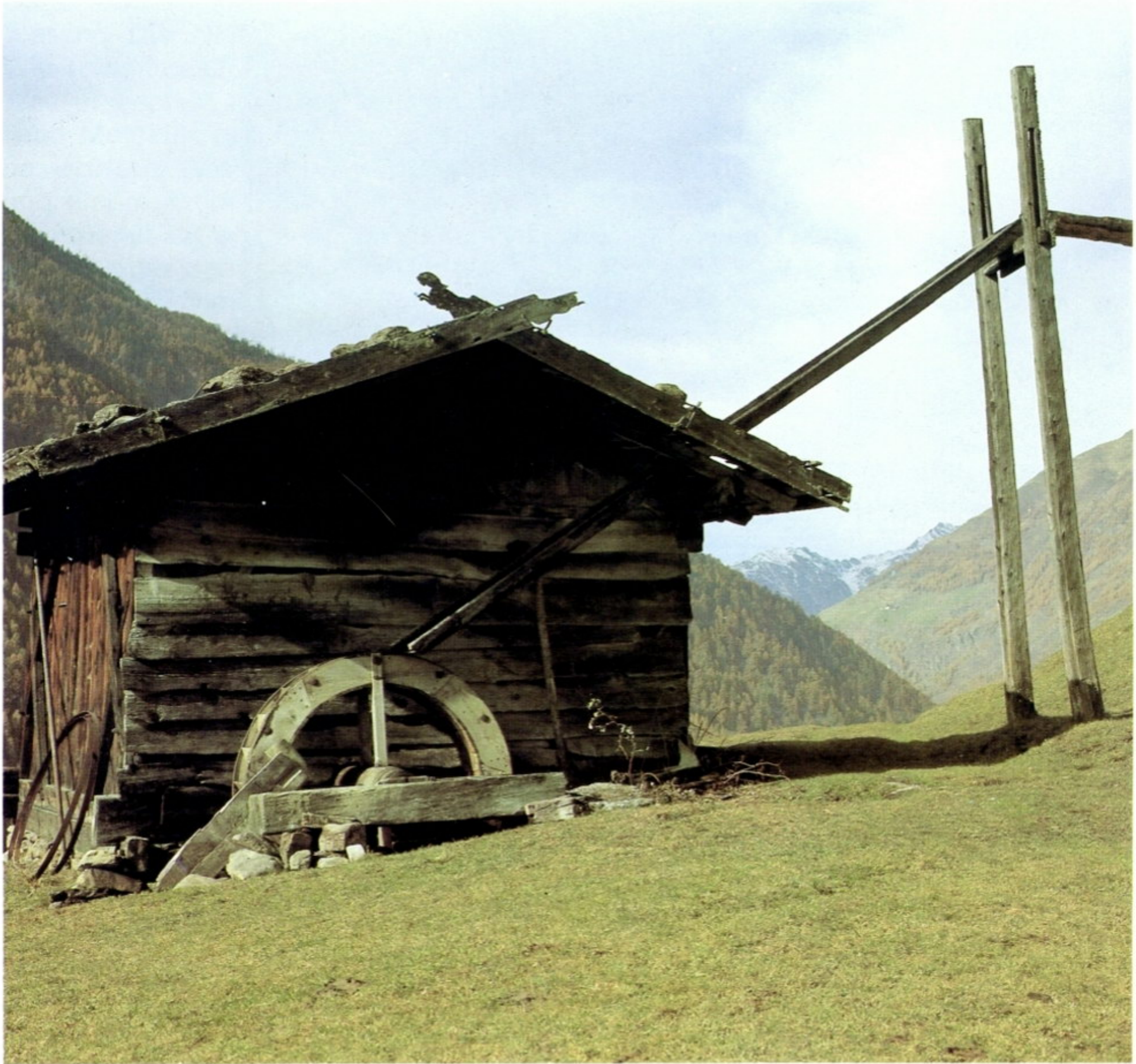
Diese alte Kornmühle in Südtirol ist mehrere Jahrhunderte alt, arbeitet aber noch einwandfrei. Das Wasser wird aus einem Bach über offene Leitungen auf das Wasserrad geleitet und treibt es an.
