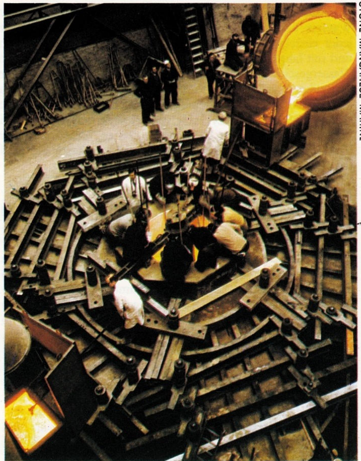
Oben: Der Guß einer Schiffsschraube mit sechs feststehenden Flügeln. Festpropeller werden gewöhnlich aus hochfesten Nicht-Eisen-Legierungen hergestellt.
