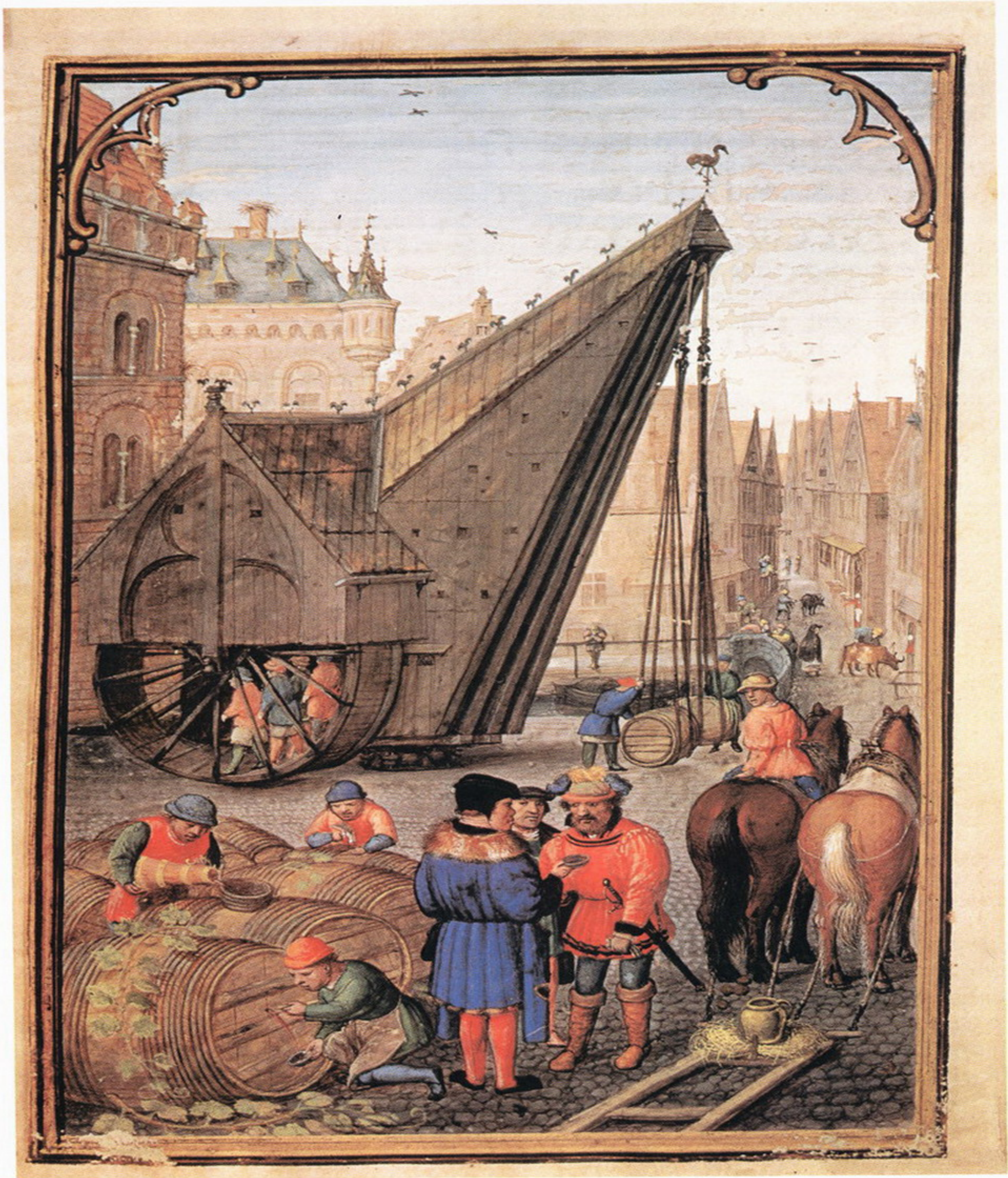
Illustration aus einem Buch aus dem 15. Jahrhundert: Kran in Brügge (Belgien). Der Kran wurde zum Entladen von Flußschiffen benutzt und mit einer Tretmühle angetrieben. Die Tretmühle war ein stehendes Rad, das sich unter dem Gewicht der in ihr laufenden Menschen drehte. Dabei wickelte sich das Hebeseil über die Achse und hob die Last über eine feste Rolle. Der Kran war drehbar gelagert.
