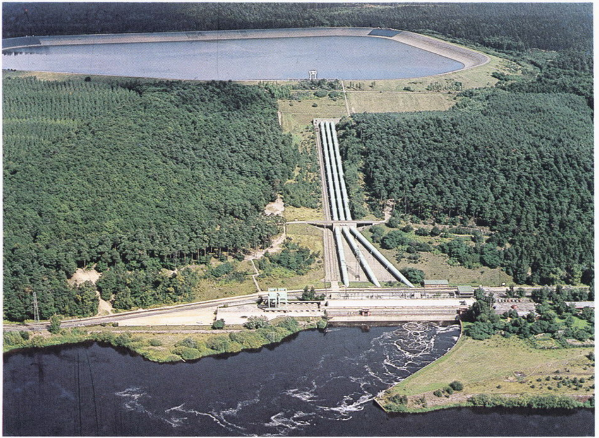
Nachts pumpt das Speicherwerk Geesthacht 3,3 Millionen cbm Elbwasser in das 90 m höher gelegene Becken. Bei Bedarf stürzt das Wasser auf drei Turbinen, deren Generatoren 600 000 kWh erzeugen.
