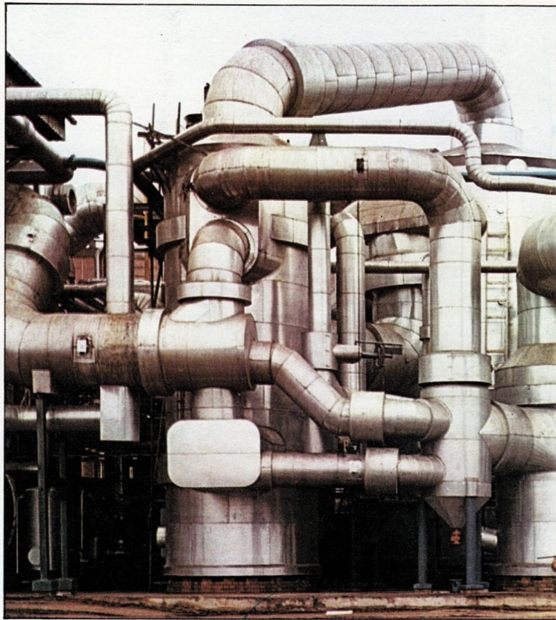
Oben: Das Bild zeigt den Konverter einer modernen Schwefelsäureanlage, in der das Kontaktverfahren angewendet wird. Sie verbraucht etwa 500 t Schwefel pro Tag. Das gesamte Rohrleitungssystem besteht aus Thomasstahl, der korrosionsbeständig ist. Die hochkonzentrierte Säure würde Edelstahl in Minuten zerstören.
