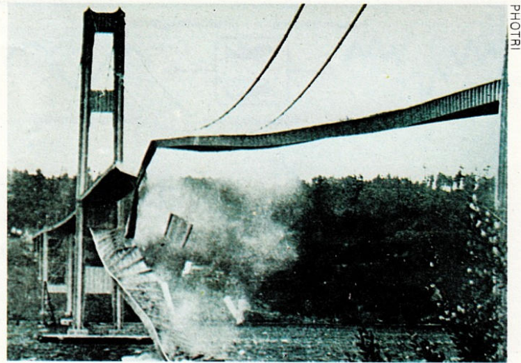
Oben: Der Einsturz der Tacoma-Narrows-Brücke in Washington wurde im Jahre 1940 durch Resonanz verursacht. Windböen mit etwa 70 km/h Windgeschwindigkeit erzwangen eine Schwingung, die zum Einsturz der Brücke führte. Nach diesem Unglück wurden Brücken dieses Typs mit größerer Steifigkeit konstruiert.
