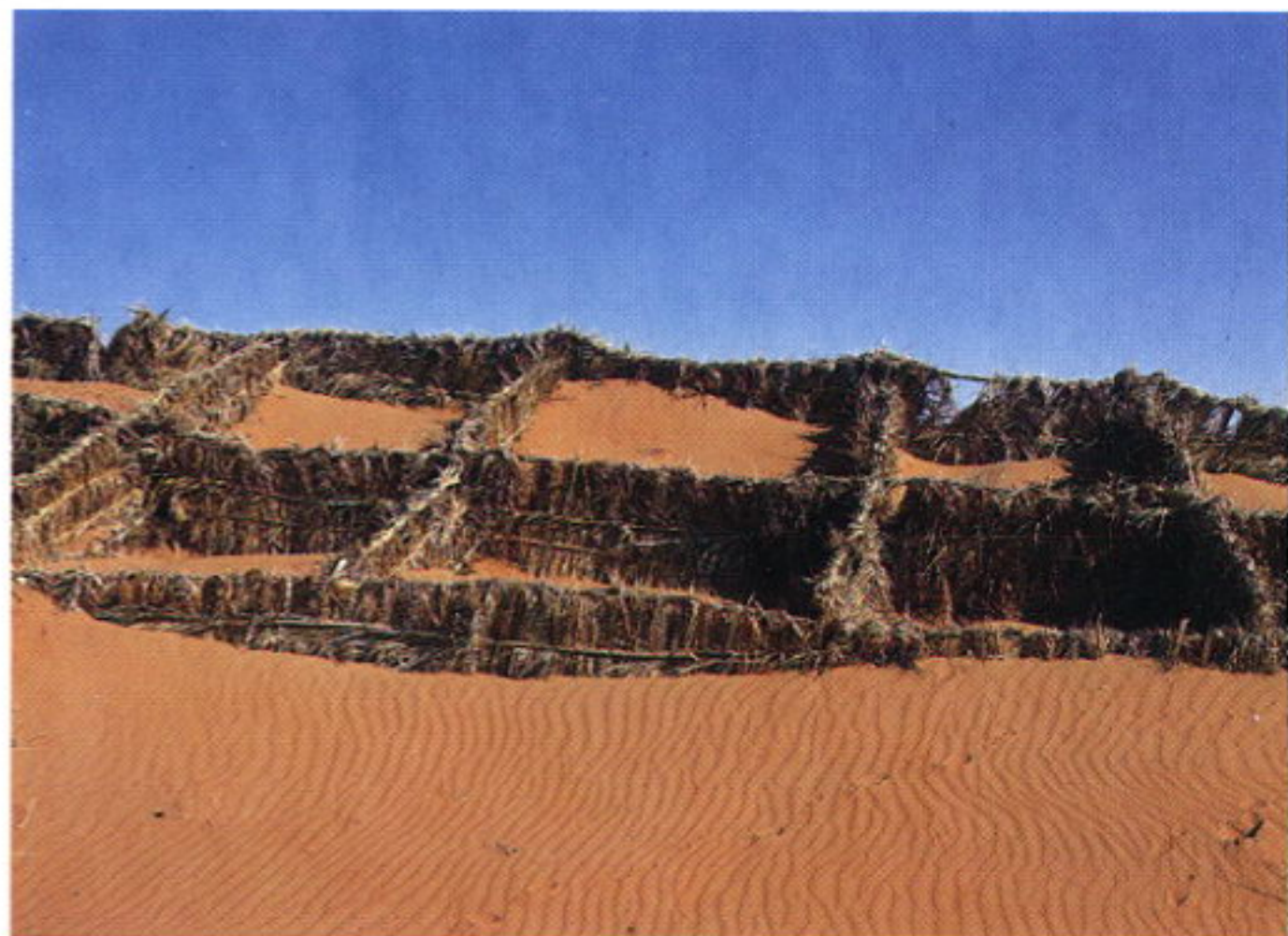
Aus trockenen Palmwedeln errichtete Dünenbefestigung in der Sahara.
