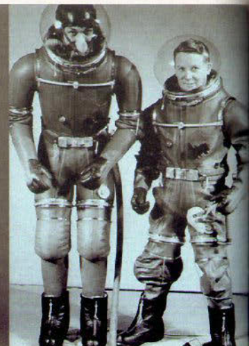
Ein DEUTSCHER PROTOTYP aus Metall von 1942 (links) war zu schwer. Dem US-ANZUG aus der gleichen Zeit (rechts) fehlte, sobald er unter Druck gesetzt wurde, die nötige Flexibilität
