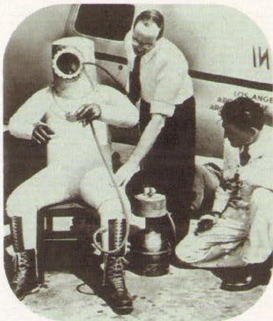
Der einäugige US-Flugpionier Wiley Post erkundete Mitte der 1930er Jahre in einem Volldruckanzug die STRATOSPHERE; das erste Modell dieser Reihe war noch bei einem Test geplatzt.
