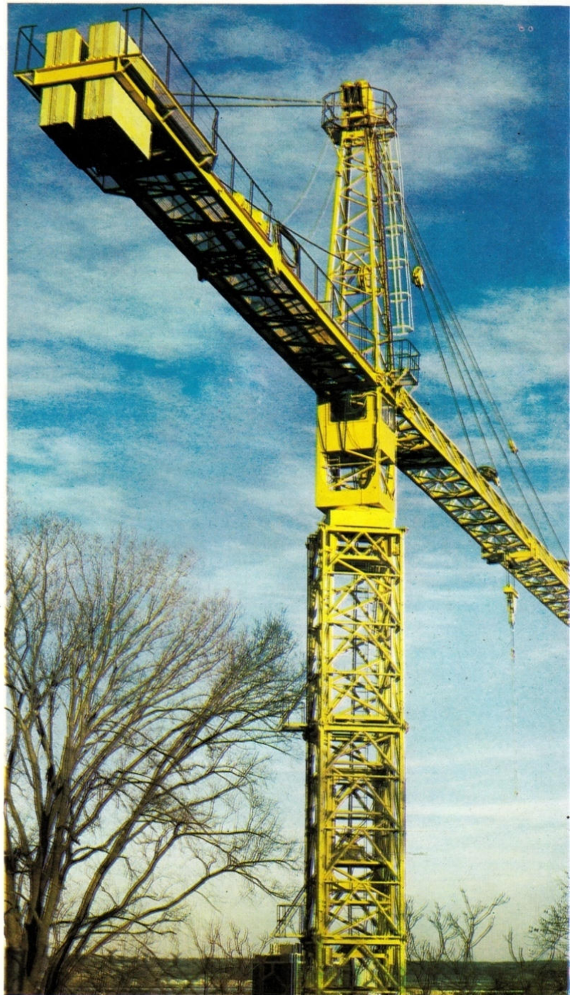
Unten: Turmkran auf einer Baustelle in den USA. Im Vordergrund links oben die Gegengewichte.
