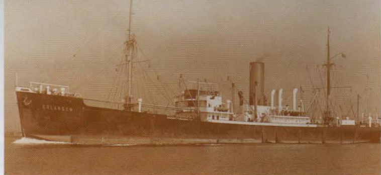
Ein Stückgutfrachter mit mittschiffs liegender Brücke und Maschine, wie er hundert Jahre lang bis etwa 1970 auf allen Meeren anzutreffen war.
