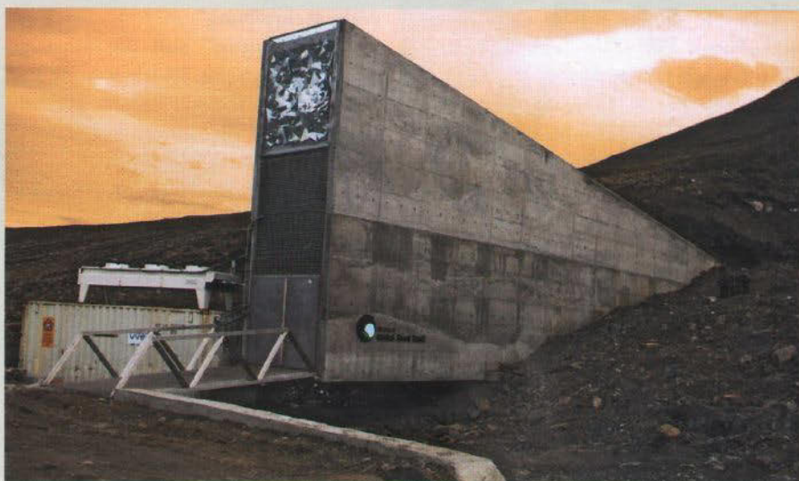
Tief in den Fels gebaut ist die Pflanzensamen-Bank »Svalbard Global Seed Vault« in Spitzbergen. Betonmauern und Stahltüren sollen sie vor Naturkatastrophen schützen
