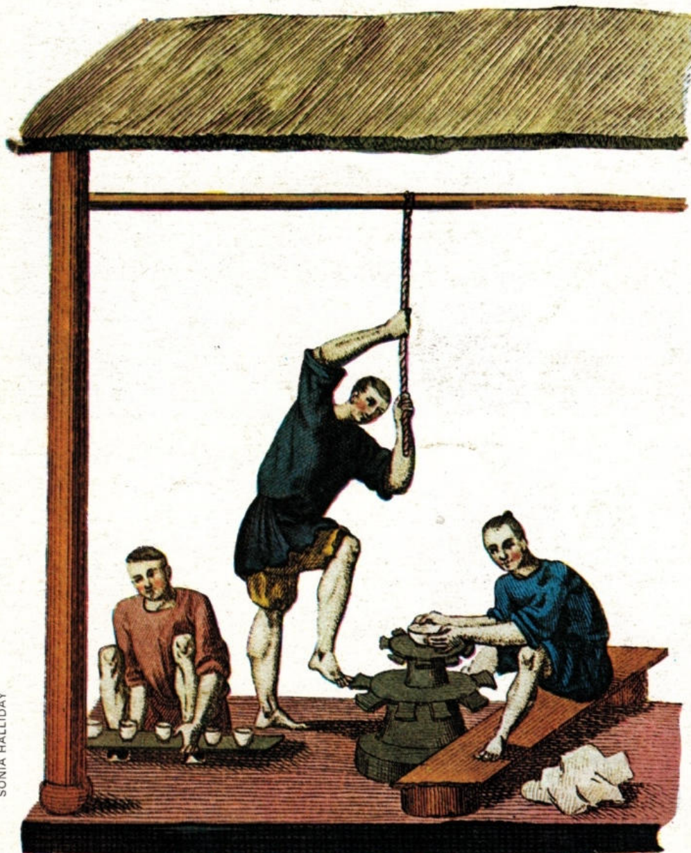
Links: Chinesischer Stich aus dem Jahr 1811, der Arbeiter bei der Porzellanherstellung zeigt. Der Mann rechts formt die Gefäße aus Ton auf einer Drehscheibe, die der sich am Seil festhaltende Mann mit dem Fuß dreht. Die fertigen Gefäße werden im Schatten getrocknet und im Ofen gebrannt.
