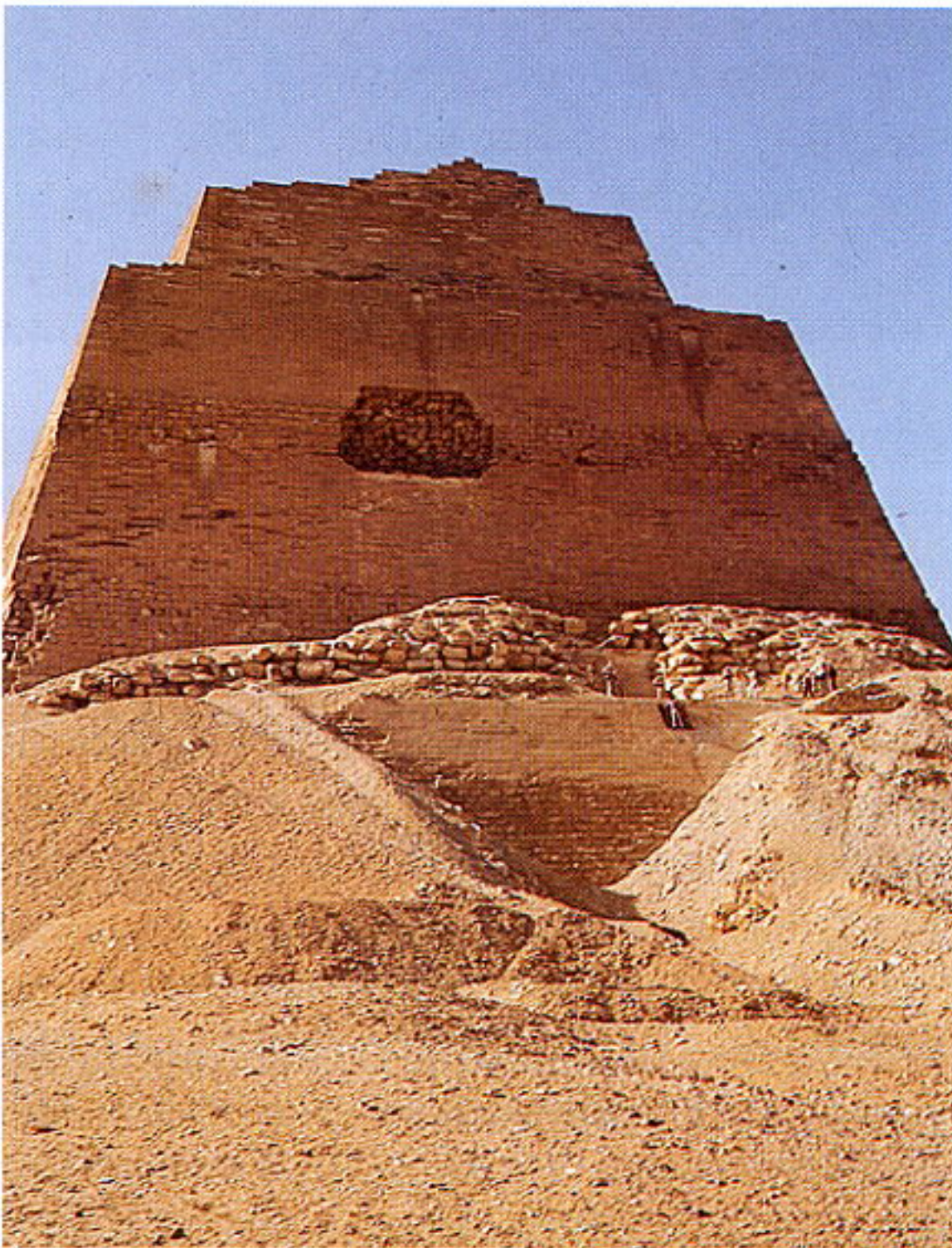
Wahrscheinlich endete der Bau der Stufenpyramide von Meidum um das Jahr 2590 v. Chr. mit einer Katastrophe: Weil die Pyramide zu steil geplant war, rutschte die Deckschicht von dem stufenförmigen Kern ab und blieb am Fuß des Bauwerks als Trümmerschutt liegen. Ob und wieviel Menschen dabei umkamen, ist unbekannt.
