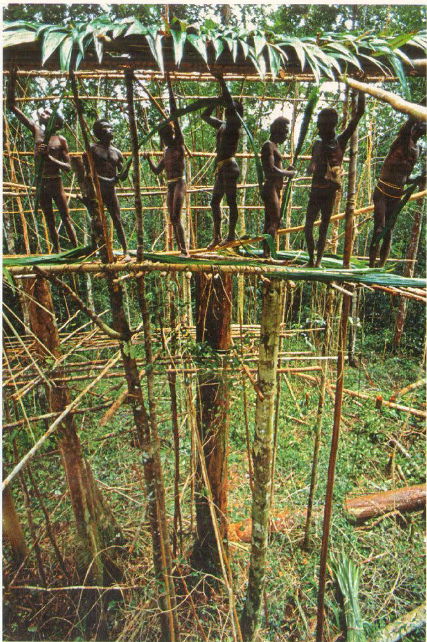
Der Bau eines Hauses dauert drei Wochen. Die Stangen werden mit Lianen in die Höhe gehievt und mit Rattan zusammengebunden, dann werden die Fugen mit Rinde ausgefüllt. Das fertige Baumhaus ist in Räume aufgeteilt. Männer und Frauen schlafen getrennt
