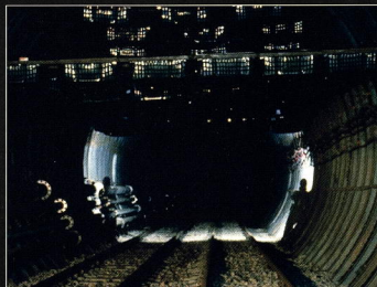
Die zahlreichen Behälter der Wassertrogsperrung hängen übereinander.
