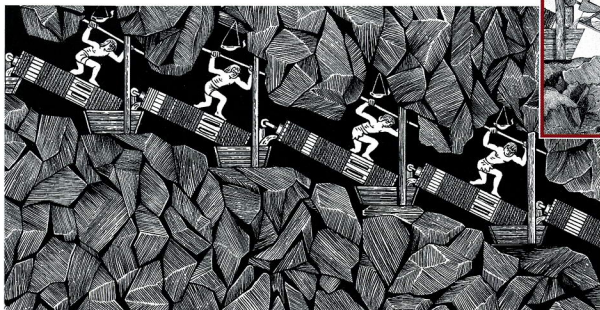
Im Schein von Öllämpchen drehten Sklaven mit bloßer Körperkraft die sogenannten Archimedisches Schrauben. So wurde das Wasser aus den Stollen Stück um Stück hochtransportiert.
