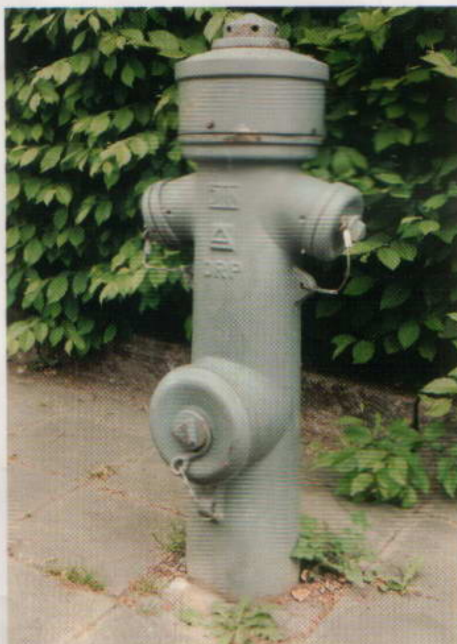
Links ein Überflurhydrant, oben ein Unterflurhydrant.
