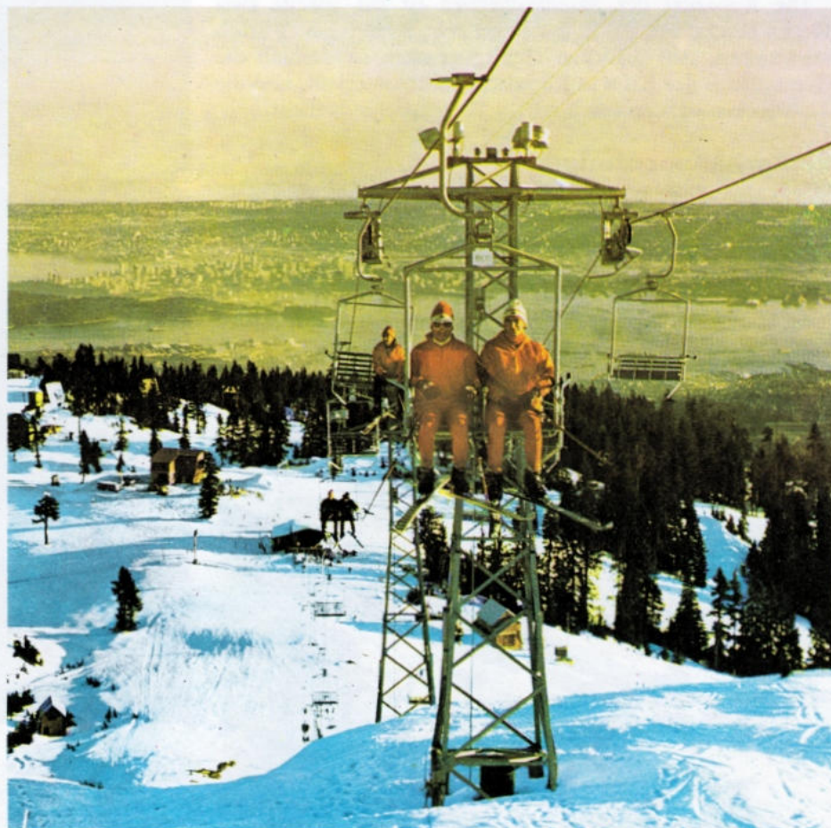
Oben: Winkelträger an einem Skilift mit Änderung der Laufrichtung der Seile. Dieser Schlepplift kann 1 000 Personen pro Stunde befördern.
