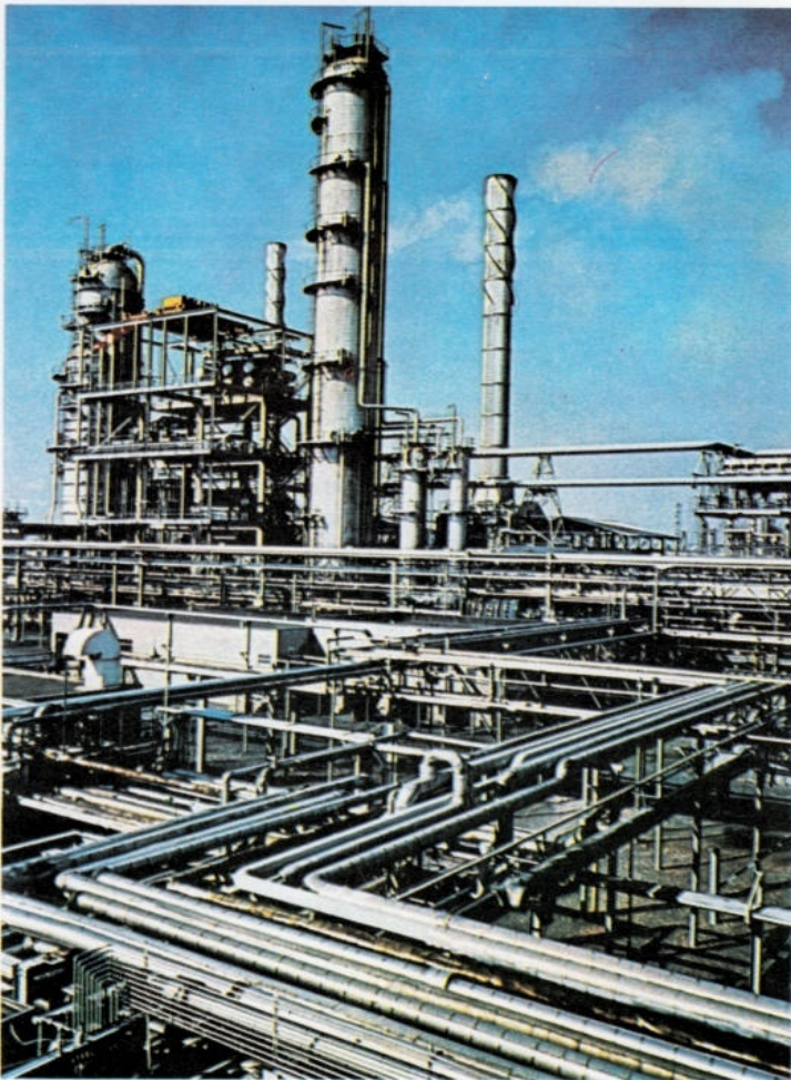
Oben: Ein 64 Meter hoher Destillationsturm für Rohöl beherrscht diese moderne Raffinerieanlage.
