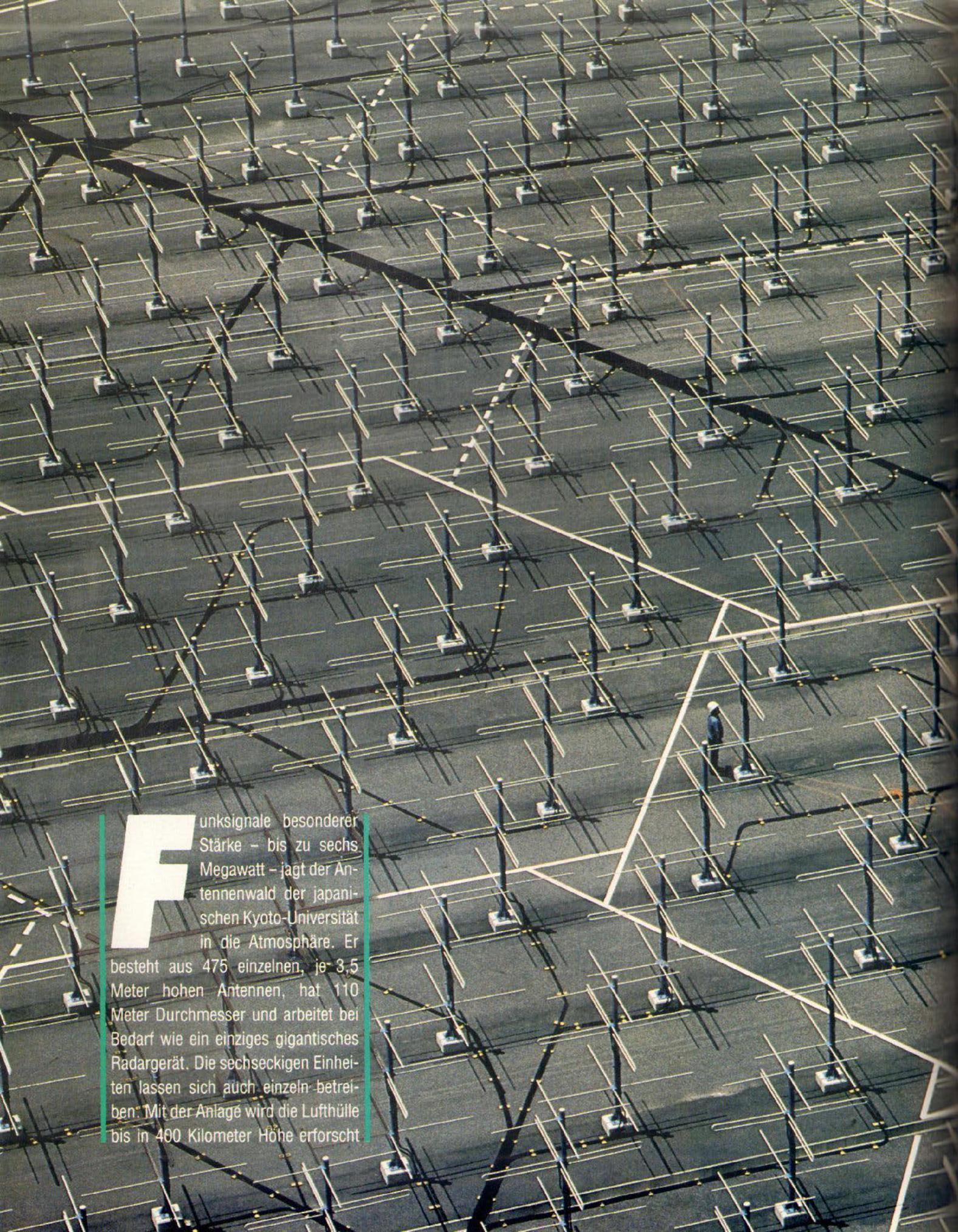
**F**unksignale besonderer Stärke – bis zu sechs Megawatt – jagt der Antennenwald der japanischen Kyoto-Universität in die Atmosphäre. Er besteht aus 475 einzelnen, je 3,5 Meter hohen Antennen, hat 110 Meter Durchmesser und arbeitet bei Bedarf wie ein einziges gigantisches Radargerät. Die sechseckigen Einheiten lassen sich auch einzeln betreiben. Mit der Anlage wird die Lufthülle bis in 400 Kilometer Höhe erforscht
