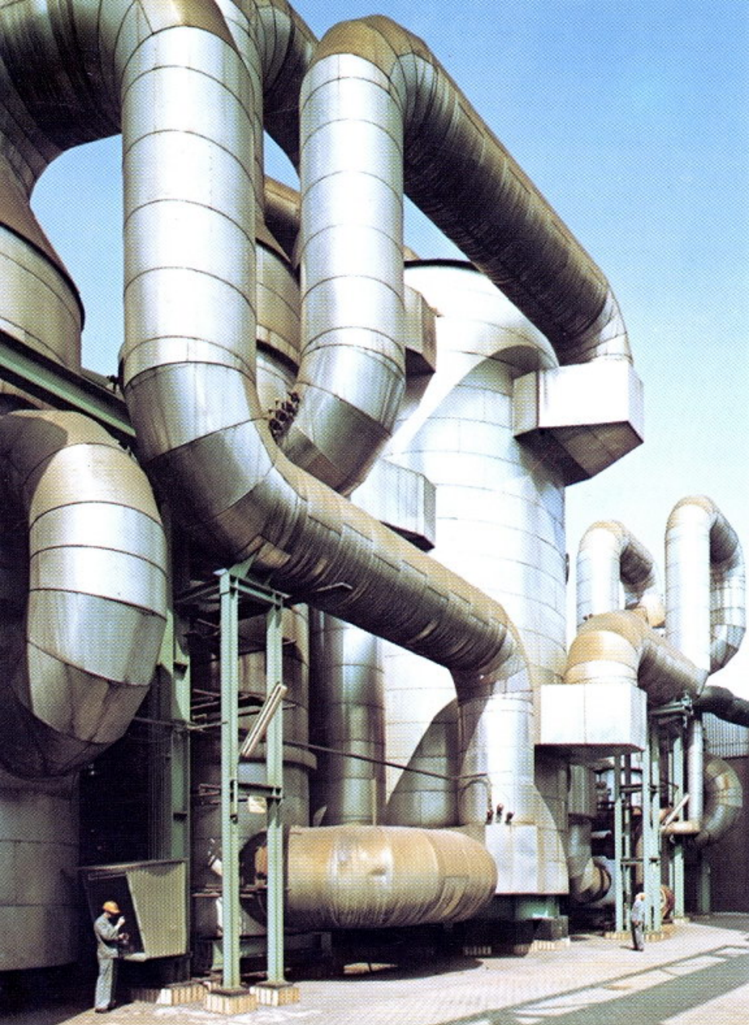
Kontaktkessel mit Zu- und Ableitungen in einem großen Chemiewerk.
