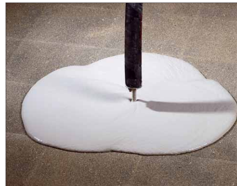
Der Nivellierestrich kann auch direkt auf Trennlagen, hier Fliesen, aufgebracht werden
