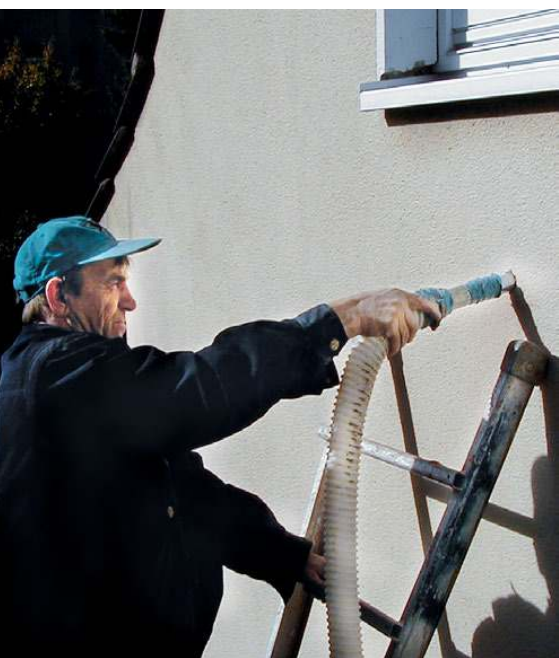
Dämmung einblasen. Hohlraum im Mauerwerk lässt sich kostengünstig etwa mit loser Stein- oder Glaswolle füllen.
