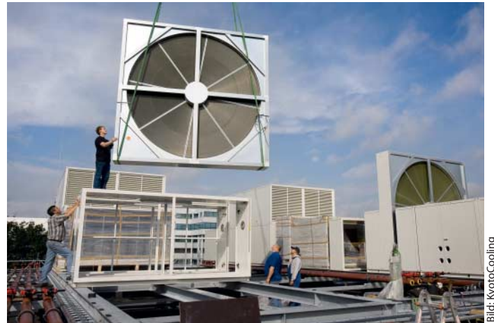
Ein Rotationswärmetauscher erweitert den Temperaturbereich, in dem man ohne Kältemaschinen auskommt.
