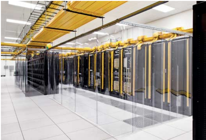
Ein transparenter Lamellenvorhang trennt kalte und warme Luftströme.
