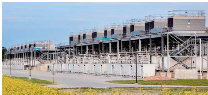
Typisch für große Rechenzentren sind „Water Towers“, die Verdunstungskälte erzeugen.
