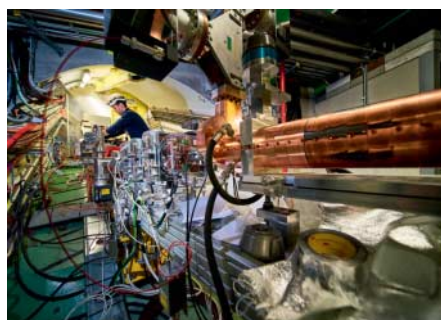
Das neue Elektronenstrahlrohr der Awake-Kooperation beschleunigt Elektronen im Plasma mit der bis zu 50-fachen Leistung bisheriger Linearbeschleuniger.
