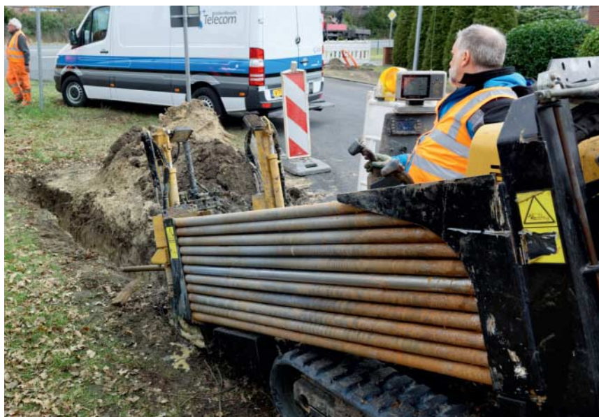
Für gelenkte Bohrungen muss keine tiefe Grube ausgehoben werden. Der Bohrer kann im Erdreich die Richtung ändern.
