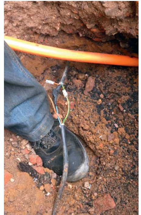
Kabelflickerei: Mit Lüsterklemmen und Isolierband versuchte der Tiefbauer zunächst, den Schaden zu beseitigen – erfolglos und sicher nicht fachgerecht.
