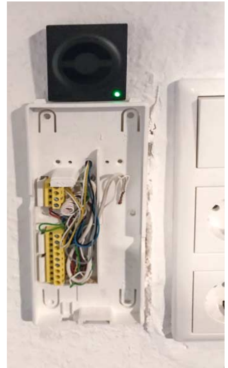
In unserer Gegensprechanlage herrschte bereits ein ordentliches Kabelwirrwarr, was die Installation des Nello One erschwerte.
